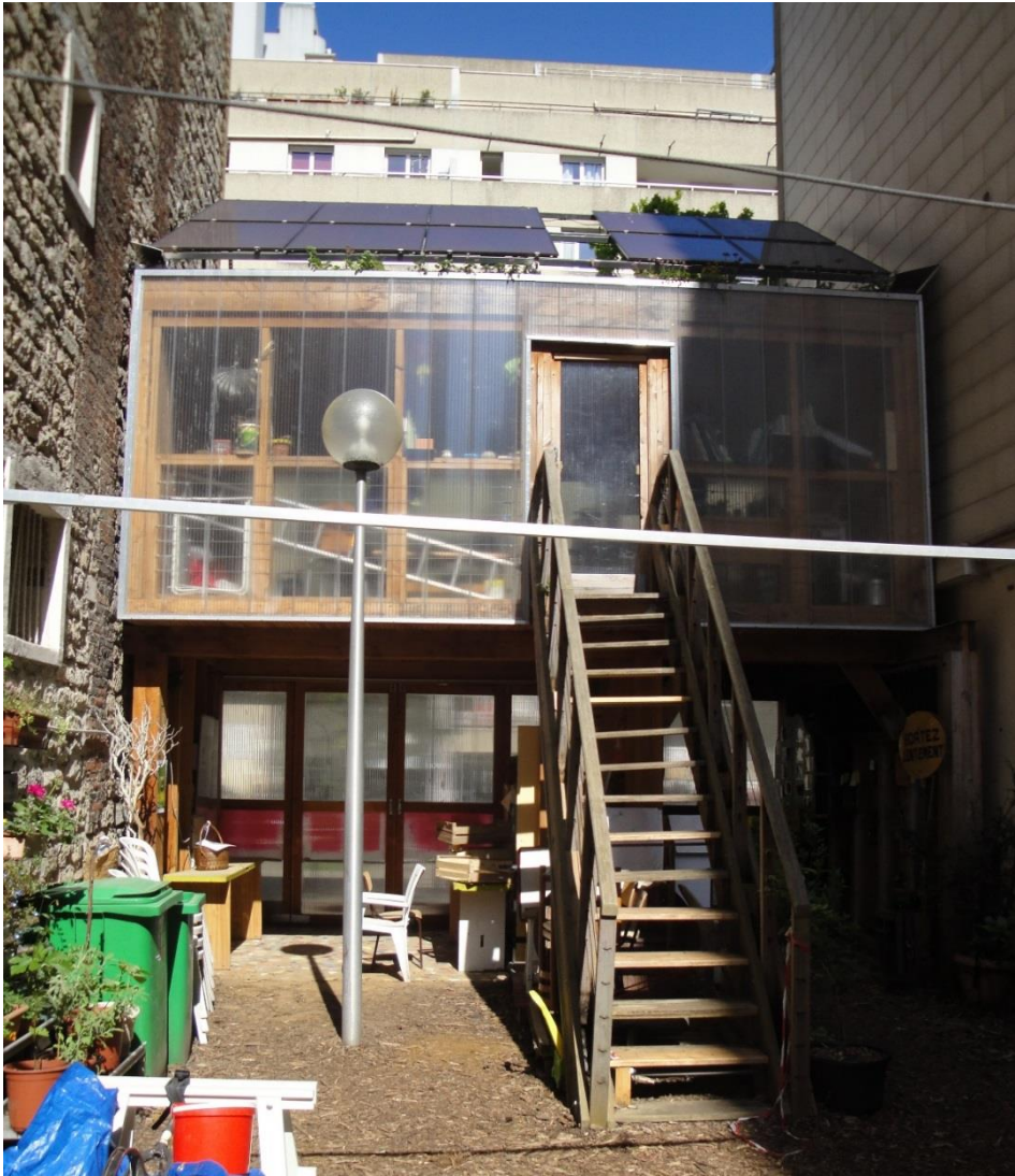
Figure 7-7. Vue de la façade depuis l'intérieur du 56.
