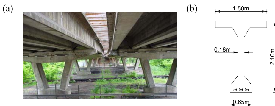
Figure 4.30 (a) viaduc de Merlebach et (b) section de poutre à mi-travée.
