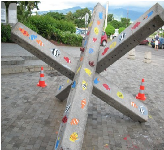
Figure II.6 : Photographie d'un récif artificiel de type tripode construit avec des poteaux EDF usagés. Photo : David Guyomard CRPMEM.
