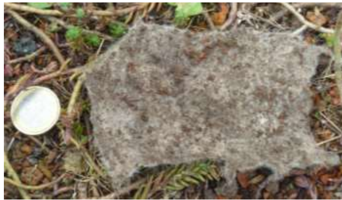
Figure 49 - Présence de particules de substrat en surface et dans le filtre géosynthétique (prélèvement d'avril 2013 - toiture des Vosges)
