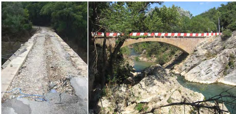
FIGURE 1.6 – État du pont de la Tournavelle, sur l'Argens, en aval du quartier des Badiés, sur la commune des Arcs-sur-Argens à la suite de l'inondation du 15 juin 2010. L'eau est passée près de 2 m au-dessus du pont, détruisant la chaussée et arrachant les garde-corps (photo à gauche, C. MARTIN, août 2010 et photo de droite, Cécile MARTIN, juin 2010), d'après *Martin (2010)*
