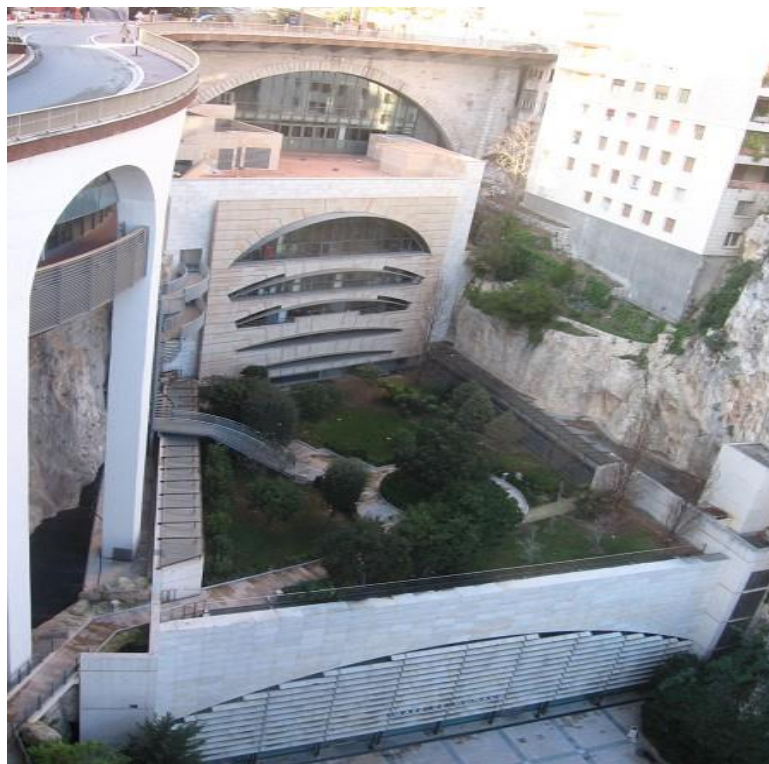
Figure 20 : La nouvelle gare de Monaco - Monte Carlo dans la montagne [Photo : B RIVIERE]
