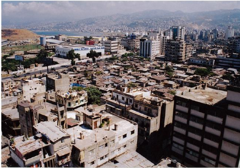
Photo 9 : Le camp Sandjak encore habité malgré la démolition en cours
