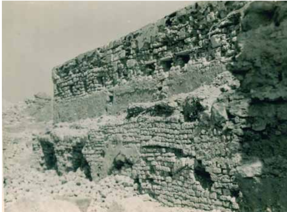
Abb. 166. Östliche Vormauer, Innenansicht 1904 (SCA).
