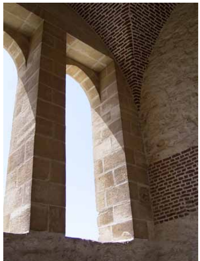
Abb. 381. 2. Obergeschoss: Fenster der Loggia.
