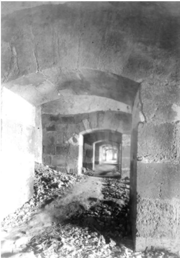
Abb. 176. Kasematten: Eskarpengang, 1949 (SCA).
