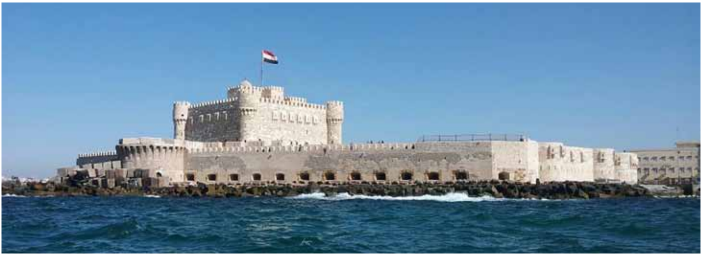
Abb. 134. Ansicht von Norden.
