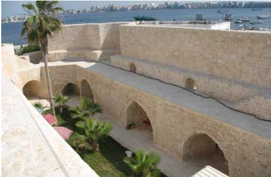
Abb. 149. Südlicher Zwinger: Blick nach Südosten.
