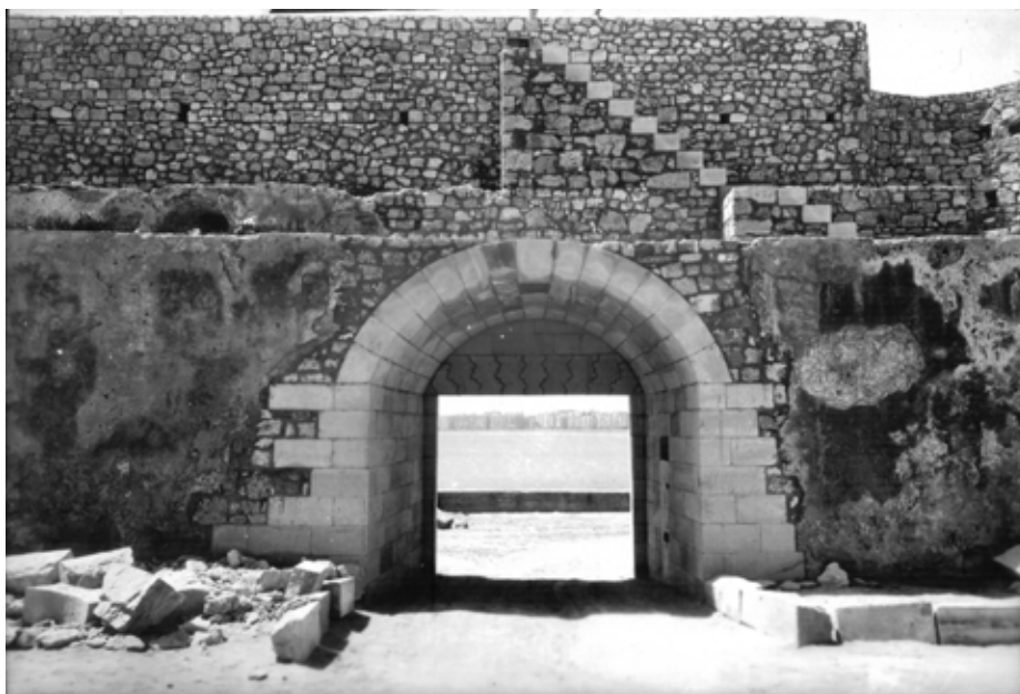
Abb. 153. Südliche Vormauer: Eingangstor, 1949 (SCA).
