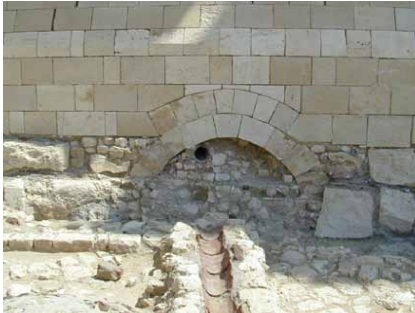
Abb. 203. Zisterne 1: Tonröhrenleitung auf dem Zisternendach, 2001.
