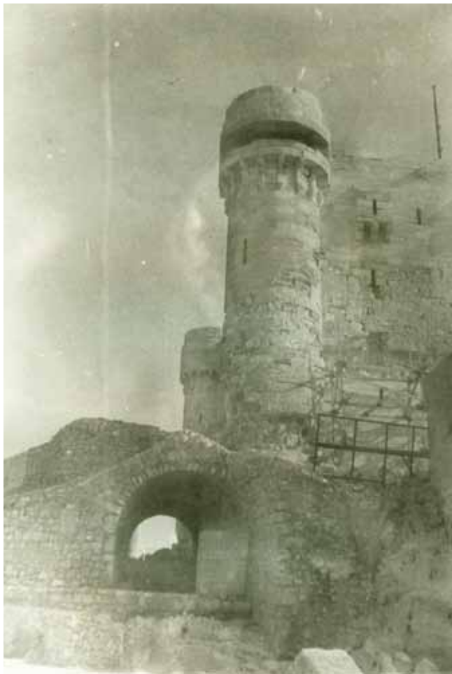
Abb. 250. Hauptturm: Nordostecke, 1964 (SCA).
