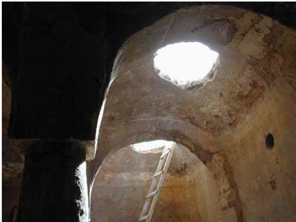
Abb. 208. Zisterne 1: Ziegelsteinkuppeln und Überlauf in der westlichen Längswand, 2001.
