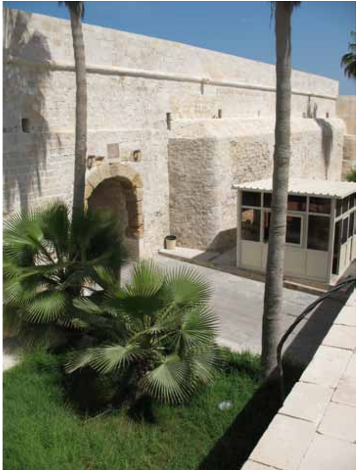
Abb. 159. Südliche Hauptmauer. Eingangspassage und östlicher Mauerabschnitt.
