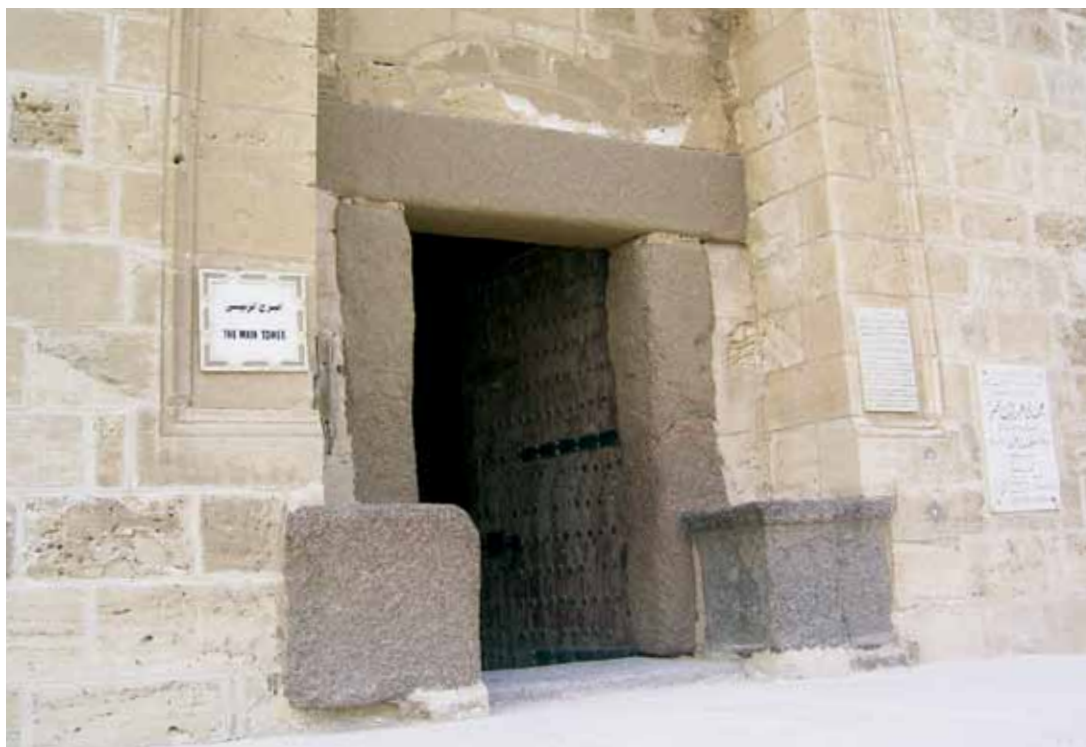
Abb. 293. Die Eingangstür mit den wiederverwendeten Blöcken aus Rosengranit.
