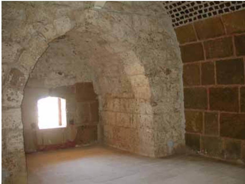
Abb. 172. Kasematten: Artilleriekammer mit Kanonenscharte.
