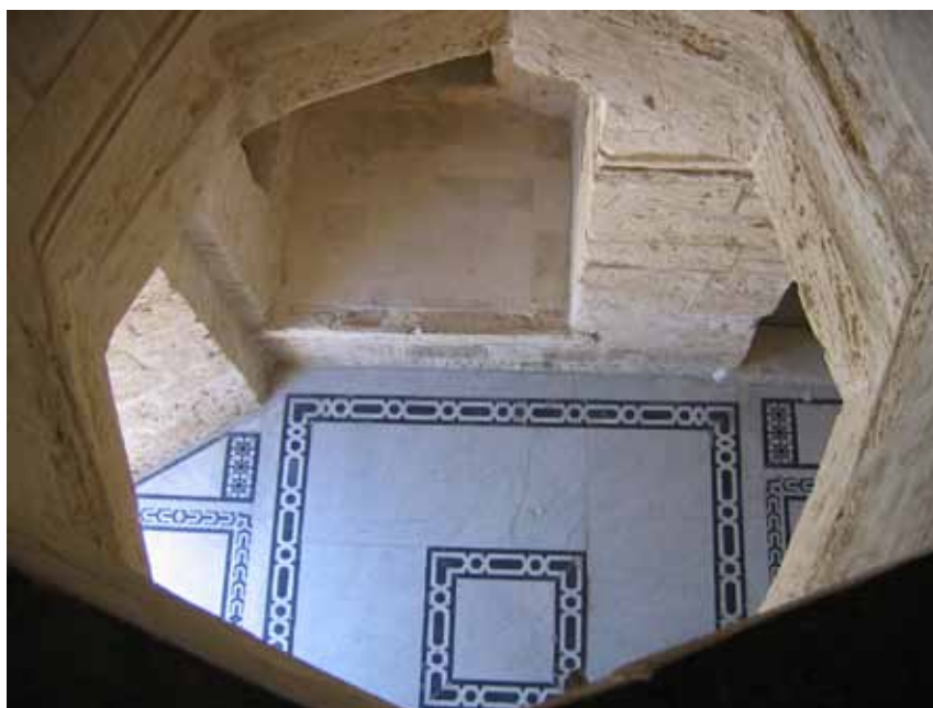
Abb. 336. Vestibül: Blick von oben.
