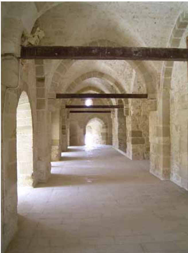
Abb. 367. 1. Obergeschoss: westlicher Umgang, Blick nach Norden.
