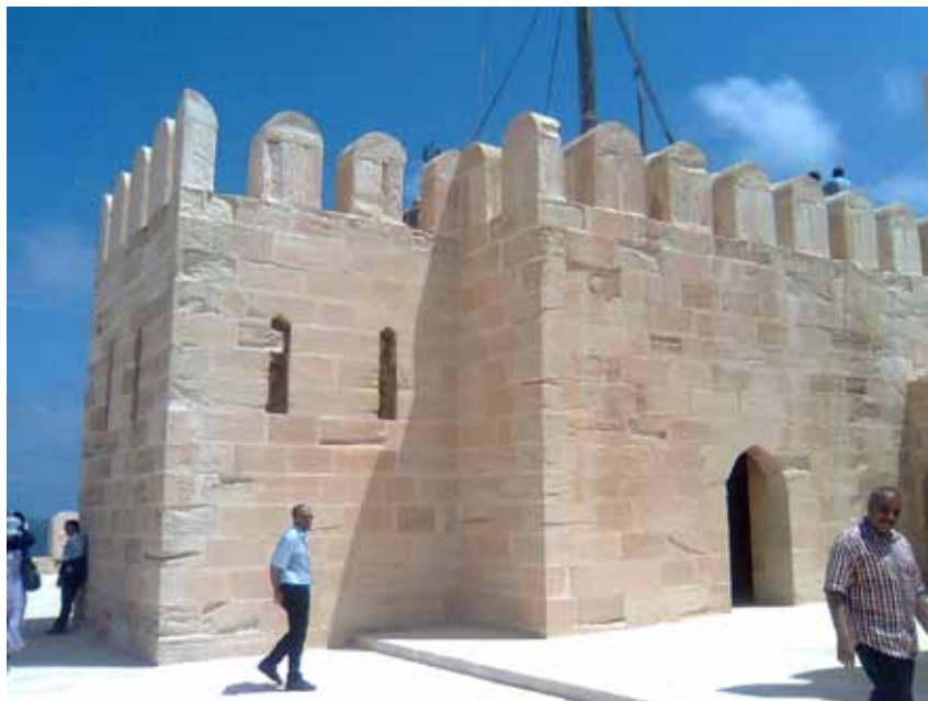
Abb. 386. Zentraler Dachaufbau: Blick nach Norden.
