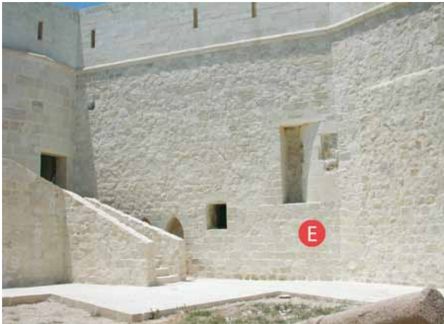
Abb. 156. Südliche Hauptmauer: alter eingebauter Portalturm (E).
