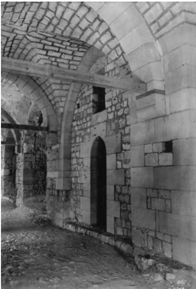
Abb. 375. 1. Obergeschoss: westlicher Umgang, Blick nach Norden, 1949 (SCA).
