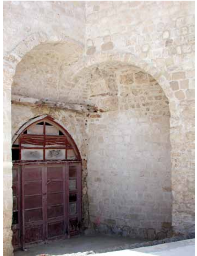
Abb. 82. Rückwärtiges Portal des Torbaus: Ausgang zum Innenhof.
