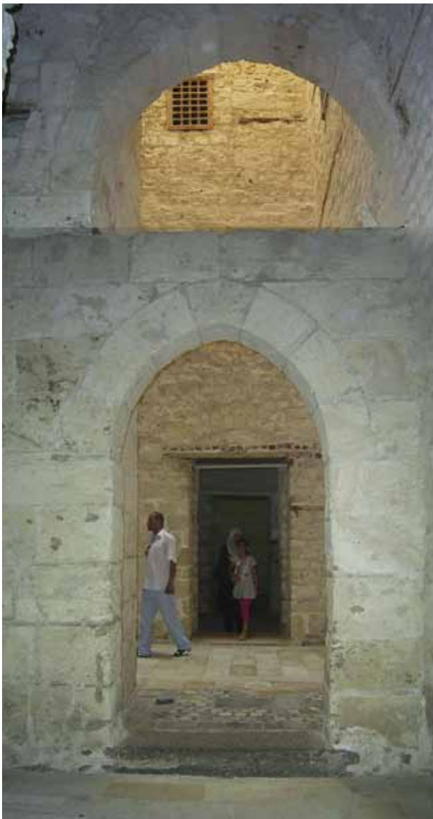
Abb. 347. Durchgang zum Manwar vor der Moschee: Blick nach Norden.
