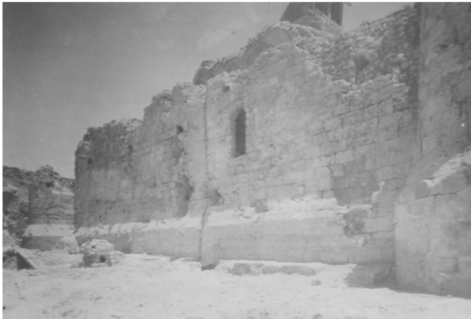
Abb. 245. Hauptturm: Westfassade, 1904 (SCA).
