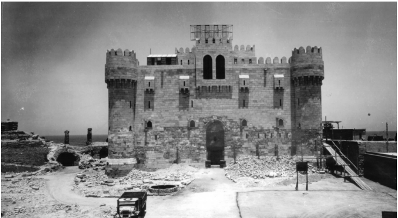
Abb. 264. Hauptturm: Südfassade nach dem Wiederaufbau, 1941 (SCA).
