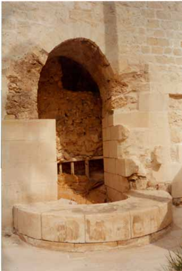
Abb. 158. Südliche Hauptmauer: freigelegter Flankierungsturm, 2002.
