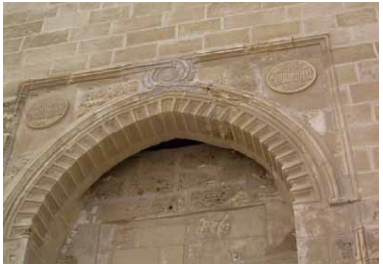
Abb. 292. Die Archivolte des Eingangsportals mit dem dahinter liegenden Maschikuli.
