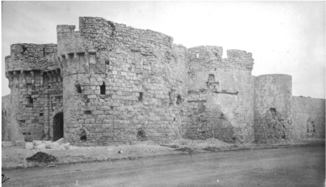
Abb. 124. Der Torbau, Südansicht, 1904 (SCA).
