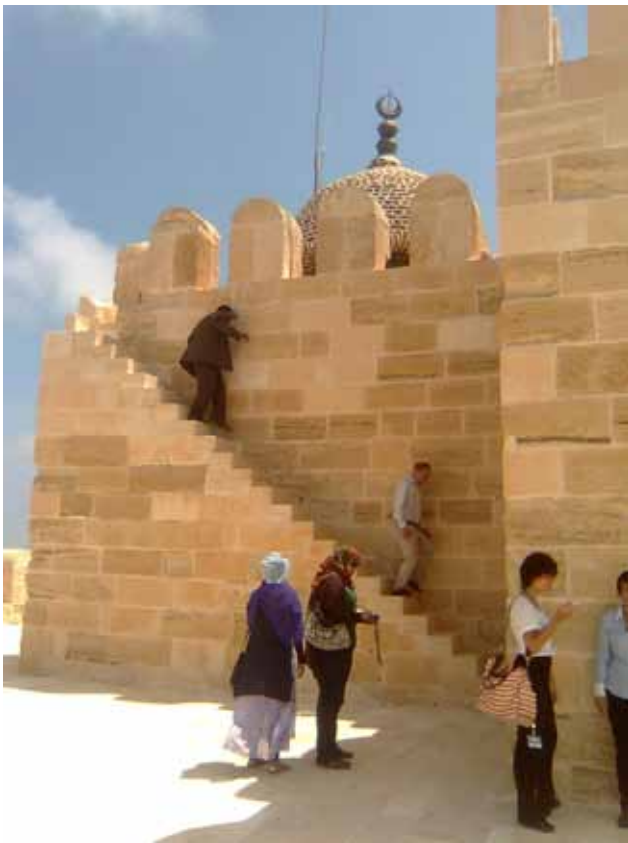
Abb. 388. Zentraler Dachaufbau: Blick nach Osten.
