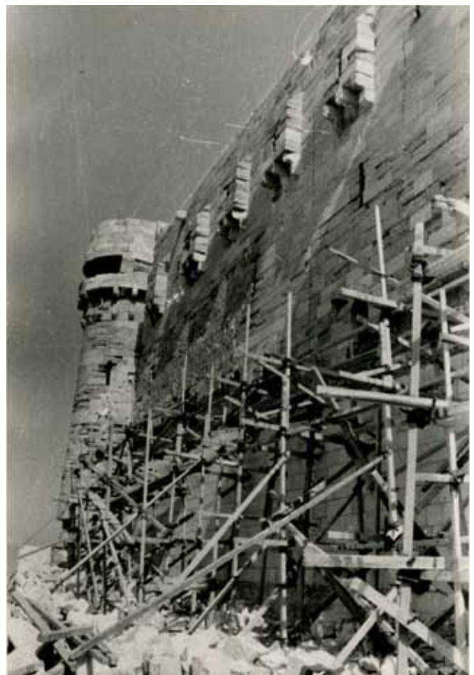
Abb. 251. Hauptturm: Nordfassade, 1964 (SCA).
