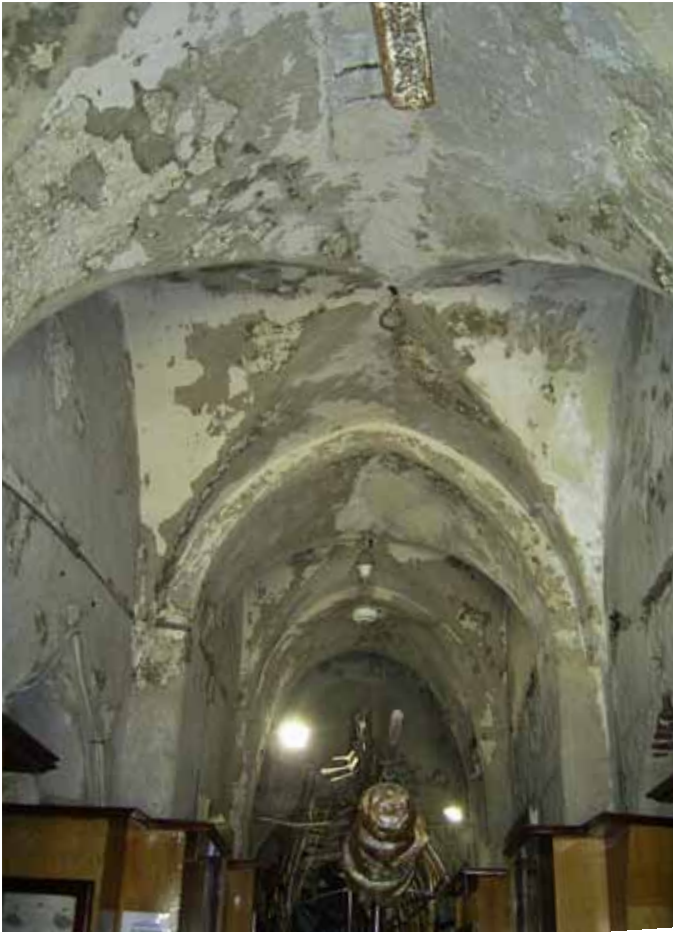
Abb. 73. Der Torbau: Kreuzgratgewölbe in der mittleren Raumflucht.
