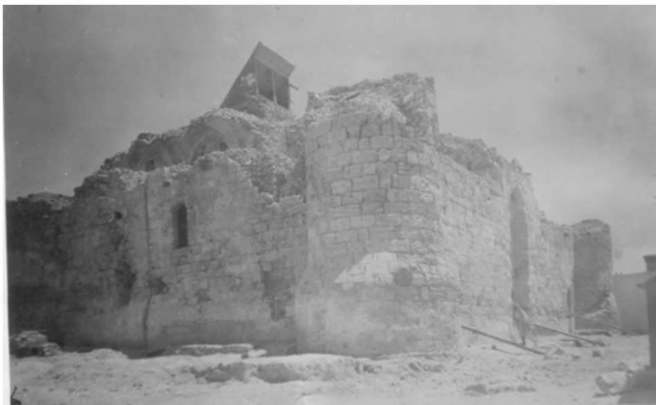
Abb. 246. Hauptturm: Westfassade, 1904 (SCA).
