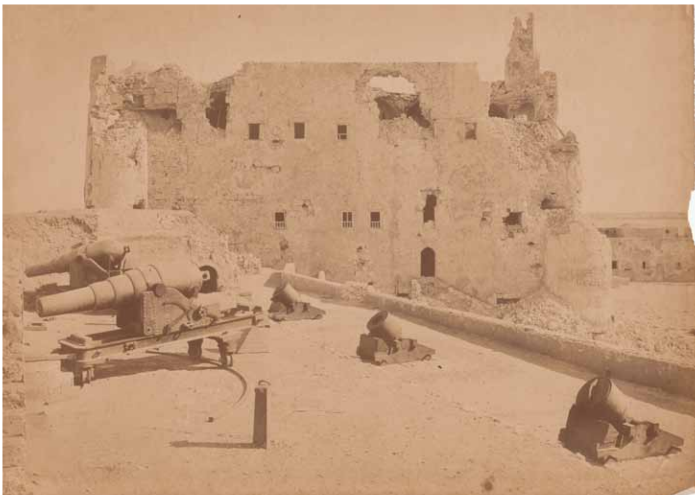
Abb. 243. Hauptturm: Westfassade, 1882 (L. Fiorillo).
