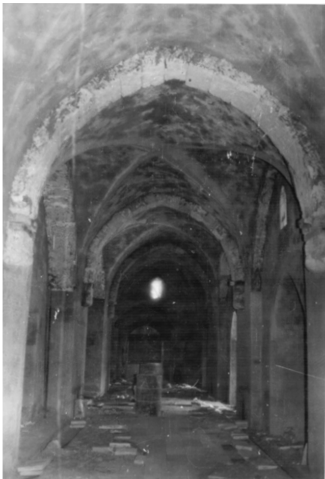
Abb. 373. 1. Obergeschoss: östlicher Umgang, Blick nach Norden, 1964 (SCA).
