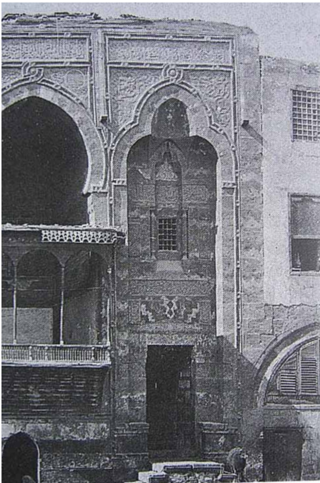
Abb. 475. SCA 228 - Palast Qaitbay (1485).
