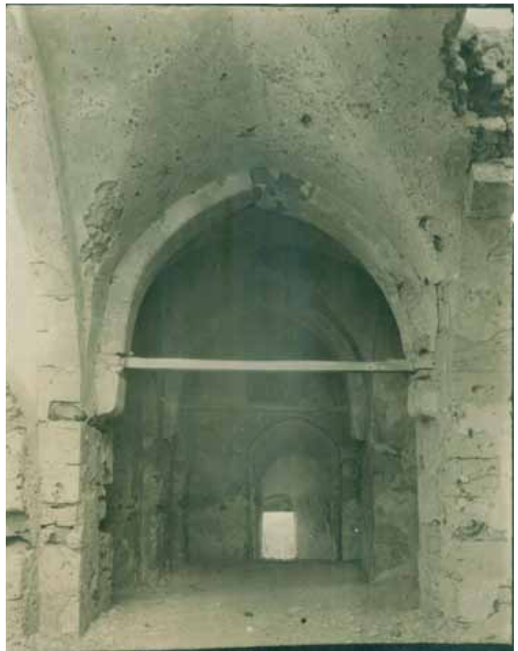
Abb. 376. 1. Obergeschoss: östlicher Umgang, Blick nach Norden, 1904 (SCA).
