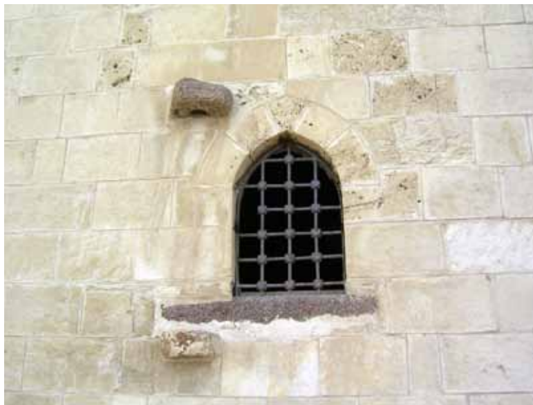
Abb. 254. Hauptturm: Ostfassade, Spitzbogenfenster des 1. OG.
