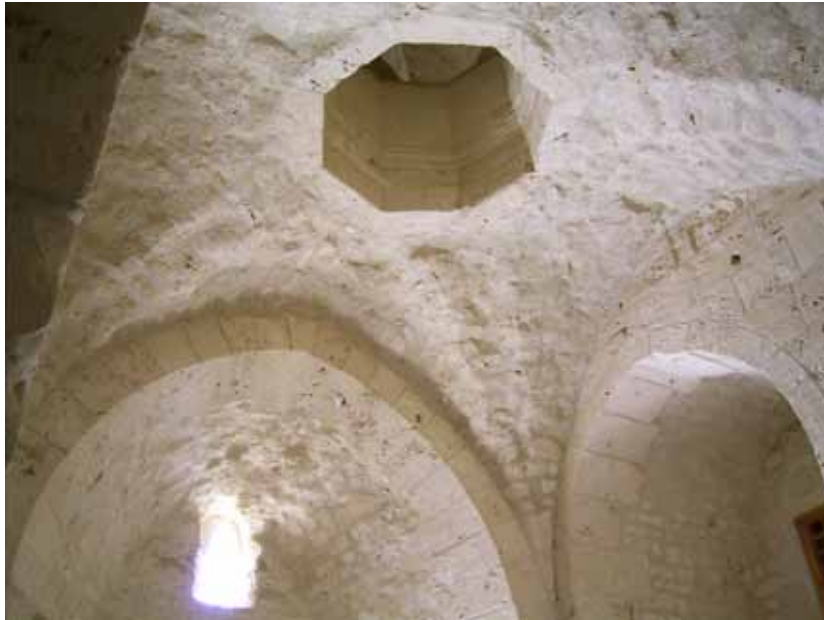
Abb. 334. Vestibül: Faltgewölbe mit der Kommunikationsluke.
