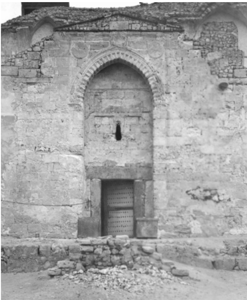
Abb. 296. Das Eingangsportal nach dem Teilabriss 1904 (SCA).
