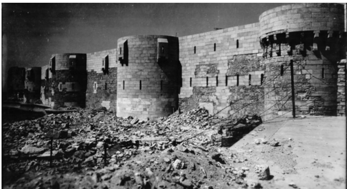
Abb. 120. Ansicht der wiederaufgebauten Westmauer, 1949 (SCA).
