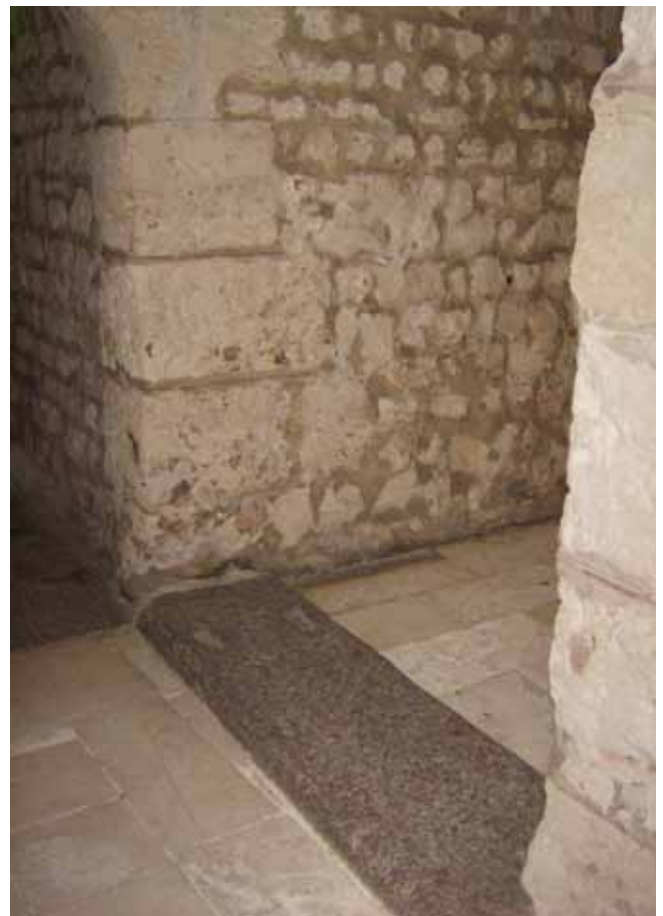
Abb. 343. Granitpolie am Eingang zum Ostsaal.
