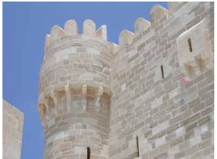
Abb. 242. Hauptturm: Westfassade, Details.
