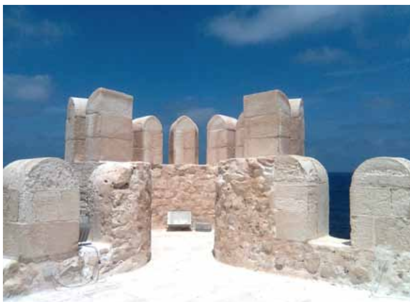
Abb. 387. Dachfläche: begehbare Eckturm.
