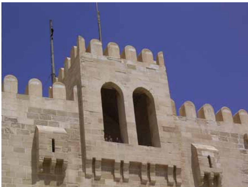
Abb. 263. Hauptturm: Loggia und Wehrrerker an der Südfassade.
