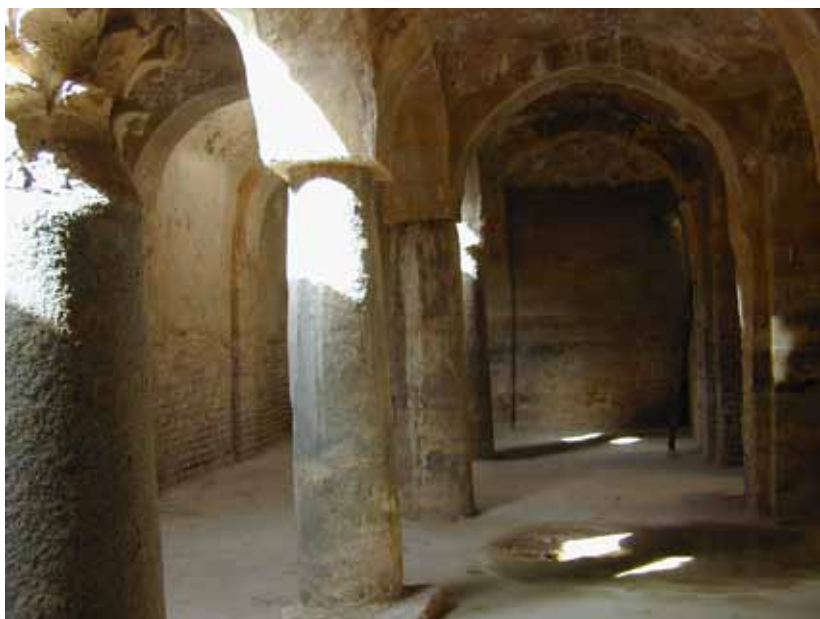
Abb. 205. Zisterne 1: Innenansicht, Blick nach Norden, 2001.
