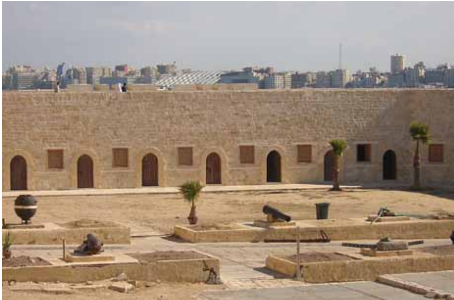
Abb. 185. Innenhof: Blick auf die Ostkasernen.
