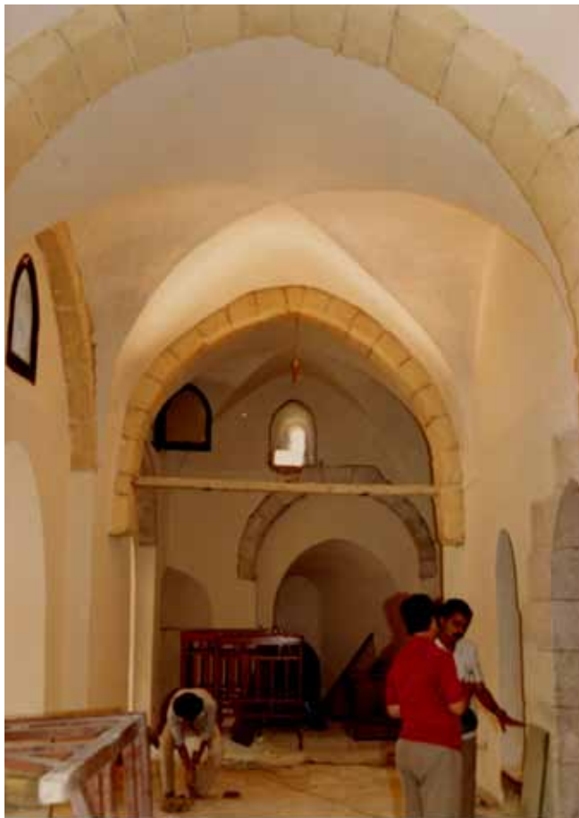
Abb. 371. 1. Obergeschoss: östlicher Umgang während der Restaurierung von 1984 (SCA).
