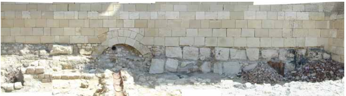
Abb. 240. Hauptturm: Westfassade, Sockelzone mit unregelmäßigen Fundamentquadern, 2001.
