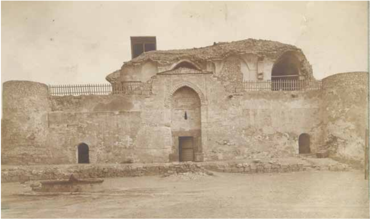
Abb. 267. Hauptturm: Südfassade nach der Teilniederlegung, 1904 (SCA).
