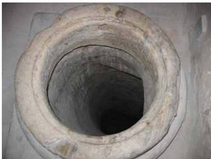
Abb. 356. Blick in den Zisternenschacht im Westsaal.
