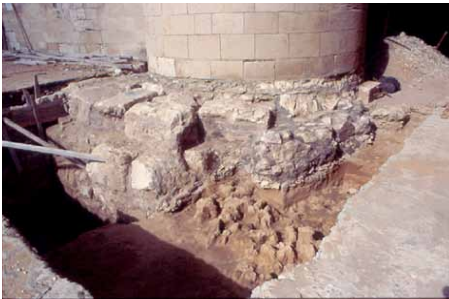
Abb. 284. Die Mauerfundamente unter der Südostecke des Hauptturms, 2001.
