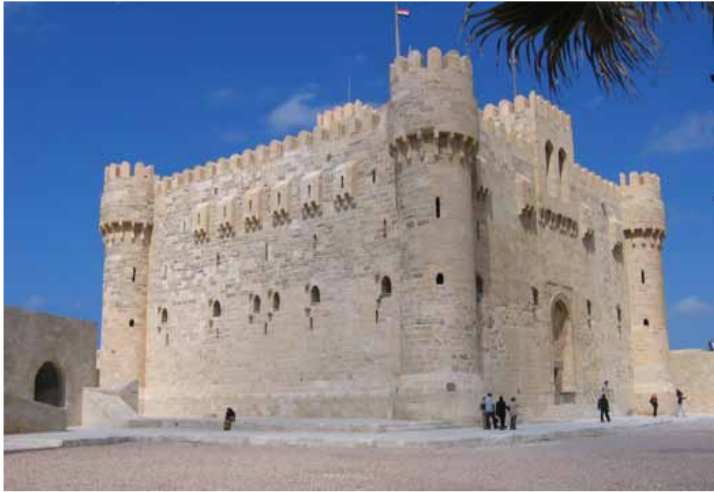
Abb. 238. Hauptturm: West- und Südfassade.
