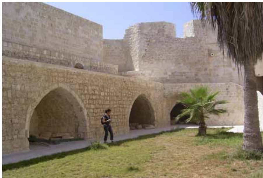
Abb. 151. Südlicher Zwinger: Blick nach Südwesten.
