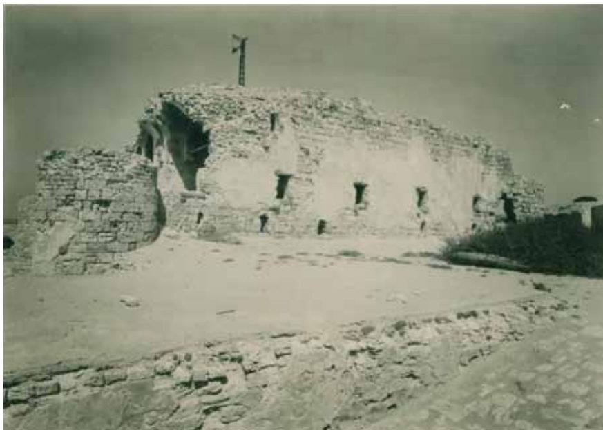
Abb. 257. Hauptturm: Ostfassade nach dem Teilabriss, 1904 (SCA).
