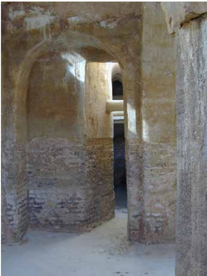
Abb. 209. Zisterne 1: unterirdische Passage zum Hauptturm, 2001.
