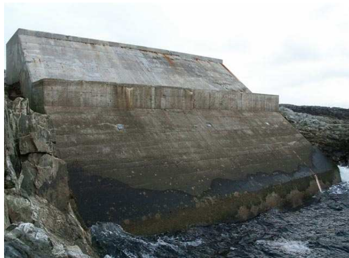
FIGURE 2.13 – La centrale à colonne d'eau oscillante sur l'île de Islay, en Ecosse.
