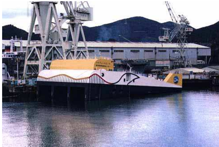
FIGURE 2.15 – Le système à colonne d'eau oscillante flottante Mighty Whale au Japon.
