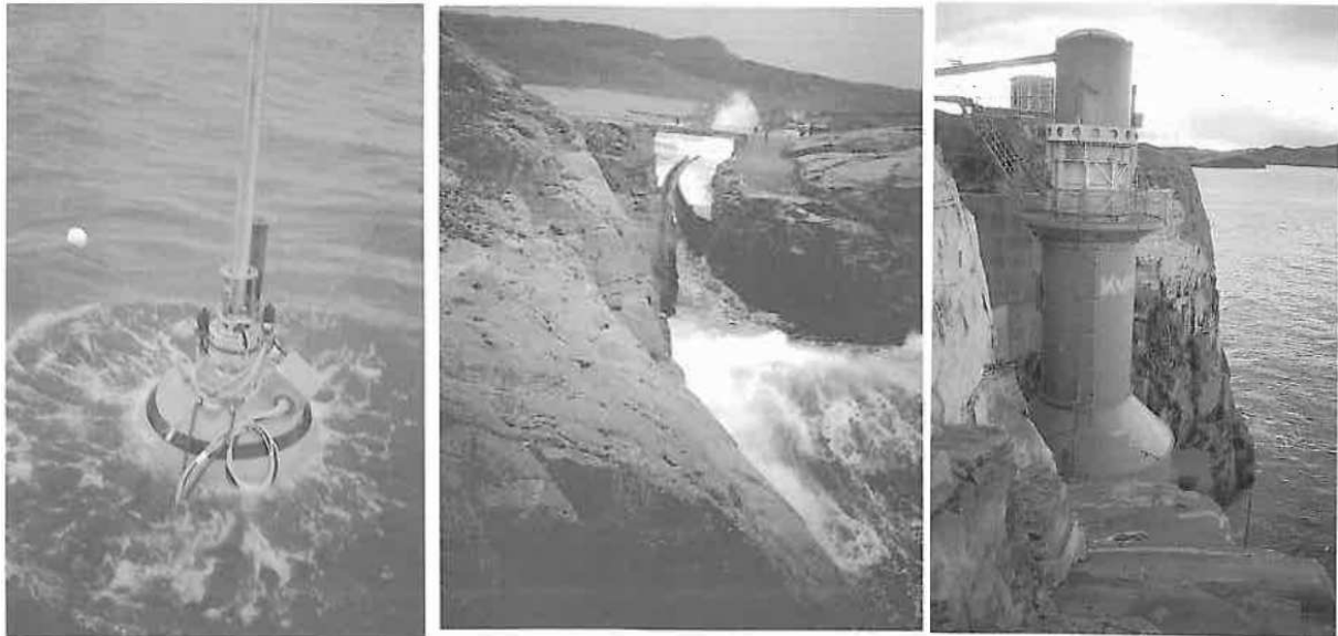
FIGURE 2.9 – Prototypes houlomoteurs testés en Norvège entre 1978 et 1988. A gauche, un point absorber , au centre, le TAPCHAN, à droite, la colonne Kvaerner. Source : [37]
