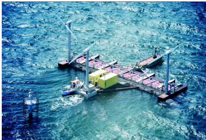
FIGURE 2.30 – Le démonstrateur du système hybride Poseidon P37 de Floating Power Plant au Danemark.
