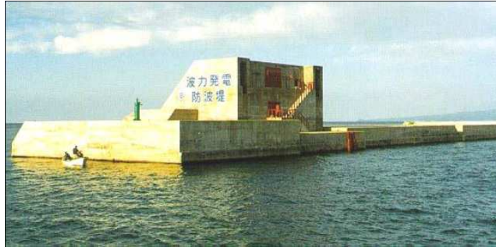
FIGURE 2.10 – La centrale à colonne d’eau oscillante intégré à la digue du port de Sakata au Japon en 1990. Source : [25]
