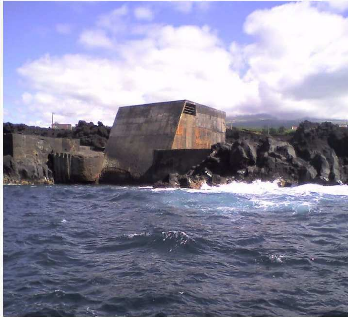
FIGURE 2.11 – La centrale à colonne d’eau oscillante de l’île de Pico, aux Açores. Source [42]
