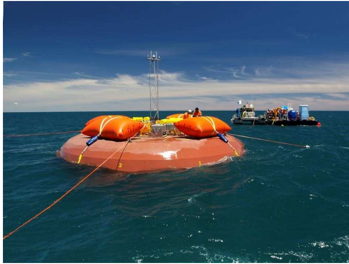
FIGURE 2.34 – Un prototype du Ceto en installation à Perth, Australie, en 2014. Source : [60]
