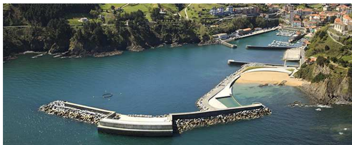
FIGURE 2.25 – La centrale à colonnes d'eau oscillante intégrée à la digue du port de Mutriku au Pays Basque Espagnol.
