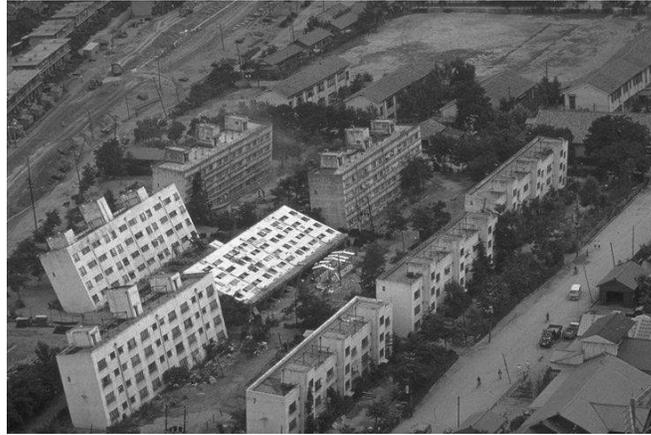
FIG. 7.1 – *Photo illustrant la liquéfaction d'un sol lors d'un tremblement de terre, Niigata, Japon 1964. Photo extraite du site web [www.ce.washington.edu/~liquefaction/](http://www.ce.washington.edu/~liquefaction/)*
