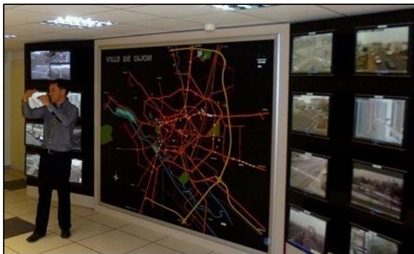
Figure 1.23 : Illustration du PC de la circulation routière de la ville de Dijon (au centre, l'écran de contrôle à diodes des carrefours à feux ; de chaque côté de l'écran de contrôle des écrans numériques permettent de visualiser l'état du trafic routier en direct par l'intermédiaire de caméras)
