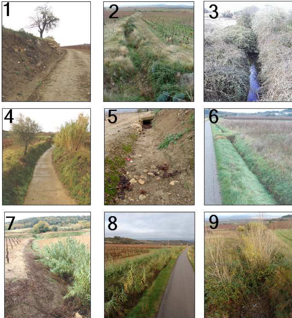
FIG. 1.2 – Photographies d'éléments de réseaux hydrographiques artificiels : 1-fossé agricole de drainage en pied de talus, 2- fossé de transport(1), 3-fossé de transport(2), 4-élément de voirie, 5-canalisation enterrée, 6-fossé de bord de route, 7-fossé de transport sur un coteau, 8-fossé de bord de route et cannes de provence, 9-fossé-drain principal du réseau de Roujan (34), fortement encombré de végétation.
