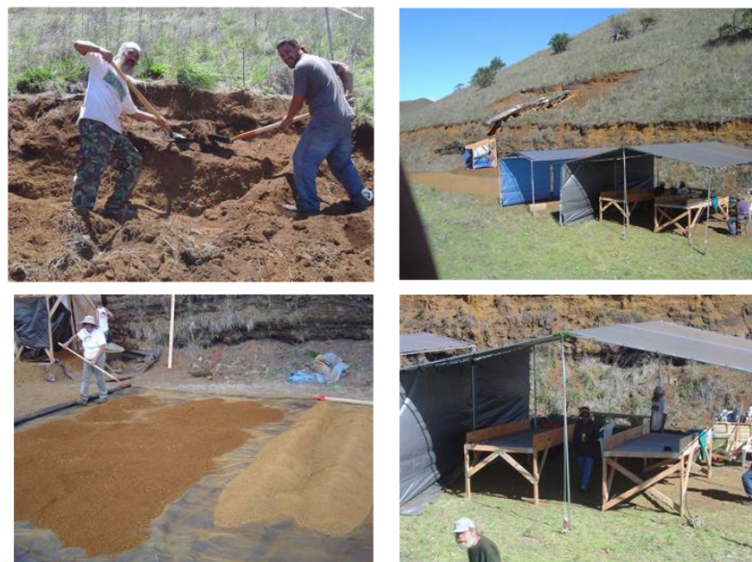
FIGURE 2.6 – Production du simulant de régolite martien à partir du cône volcanique Pu'u Nene, sur le flanc Sud du volcan Mauna Kea (Hawaï). Crédits : NASA.
