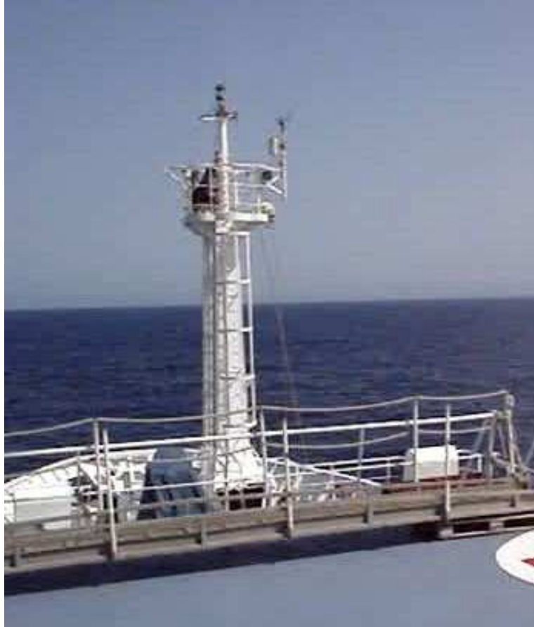
Figure I. 4. Mât météo sur lequel est installé le collecteur aérosols - Atalante
