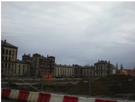
3 - La Caserne Lefebvre en cours de réhabilitation
