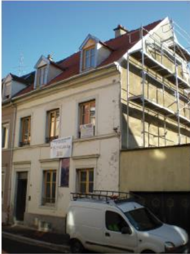
1 - Immeubles BBC rénovés dans Franklin
