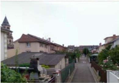
La cité ouvrière de la Société Mulhousienne des Cités Ouvrières Maisons individuelles mitoyennes accolées quatre par quatre Quartier Briand
