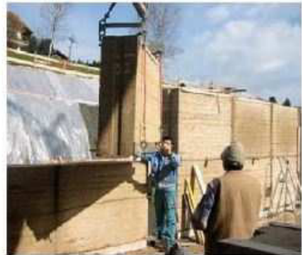
Figure 1-14 : Transport et mise en œuvre sur chantier d'un pisé préfabriqué. Photo : M. Rauch
