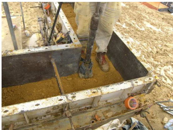
Figure 5-3 : Implantation des capteurs pendant la construction du mur sud/ouest. Passage des câbles des CS616 (en haut à gauche), pose des CS616 sur la partie ouest (en haut à droite), damage sur les CS616 (au milieu à gauche), pose des CS616 modifiées (au milieu à droite), damage sur les CS215 (en bas à gauche) et centrale d'acquisition sur son mat avec le panneau photovoltaïque (en bas à droite)
