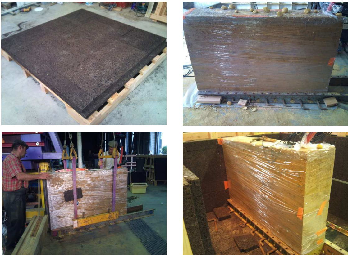
Figure 4-8 : Fabrication du socle des caissons étanches avec isolation au sol (en haut à gauche), un des murs dans un film plastique après sa fabrication (en haut à droite), déplacement d'un mur grâce aux U (en bas à gauche) et placement d'un mur dans un caisson (en bas à droite)
