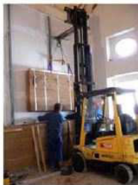
Figure 1-14 : Transport et mise en œuvre sur chantier d'un pisé préfabriqué. Photo : M. Rauch
