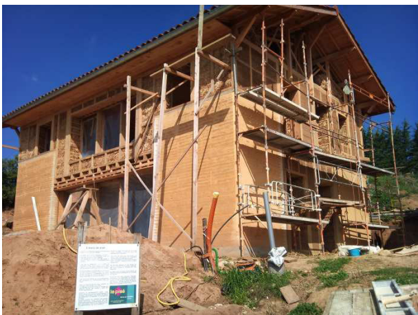
Figure 1-21 : Quelques étapes de l'édification de la maison. En haut à gauche, le chantier avant la construction du mur sud/ouest et en haut à droite, la construction de ce mur. Au milieu à gauche, le mur sud/ouest instrumenté fini. Au milieu à droite, la mise en place des armatures bois et remplissage à la paille. En bas à gauche, la pause du Douglas extérieur. En bas à droite, la perspective d'intégration par l'architecte.
