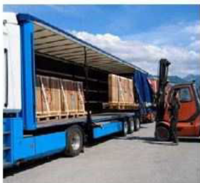
Figure 1-14 : Transport et mise en œuvre sur chantier d'un pisé préfabriqué. Photo : M. Rauch
