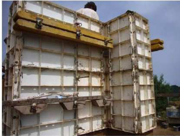
Figure 1-11 : Un coffrage moderne en métal sur un chantier en France. Photo : N. Meunier
