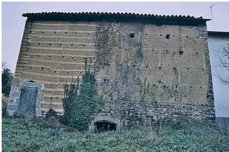
Figure 1-9 : Technique de jointure à la chaux oblique à gauche (17 ème siècle) et verticale à droite (19 ème et 20 ème siècle) sur une même construction en pisé (Guibaud, 2005)
