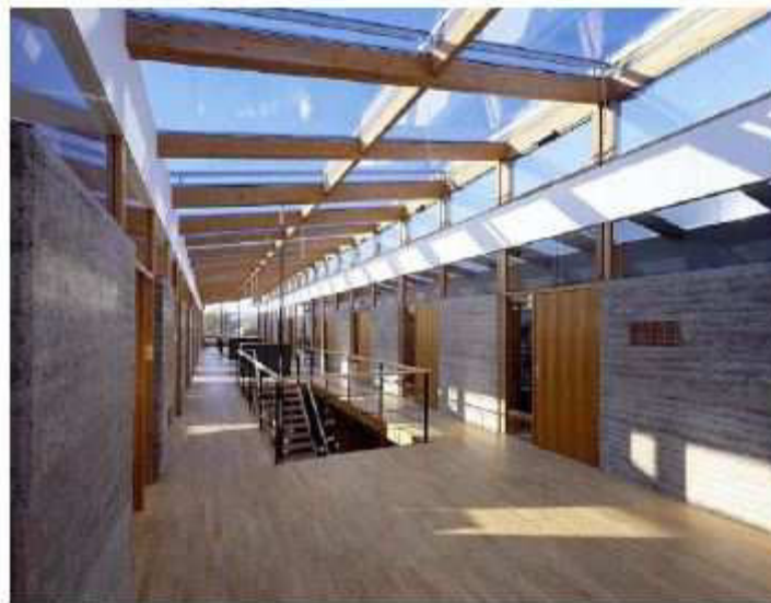
Figure 1-15 : Un bâtiment composé de 160 éléments de pisé préfabriqué. Photo : M. Rauch
