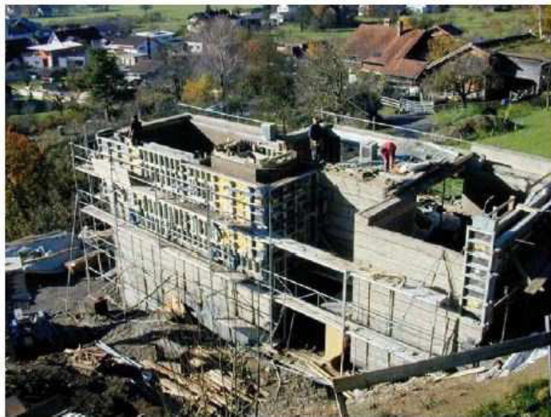
Figure 1-12 : Bâtiment en pisé non-stabilisé en Autriche. Photo : M. Rauch
