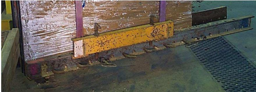
Figure 4-1 : U et tirants permettant de soulever le mur en pisé après sa fabrication
