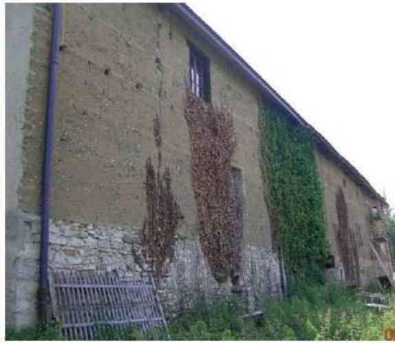
Figure 1-7 : Maison en pisé datant de la fin du 19<sup>ème</sup> siècle avec un soubassement en maçonnerie de pierres
