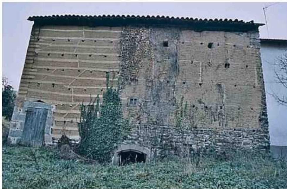
Figure 1-9 : Technique de jointure à la chaux oblique à gauche (17<sup>ème</sup> siècle) et verticale à droite (19<sup>ème</sup> et 20<sup>ème</sup> siècle) sur une même construction en pisé (Guibaud, 2005)
