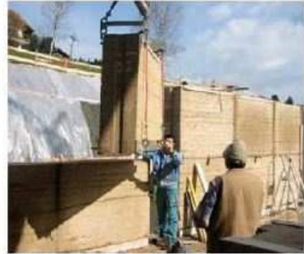
Figure 1-14 : Transport et mise en œuvre sur chantier d'un pisé préfabriqué. Photo : M. Rauch
