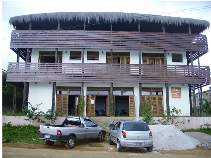
Façade principale du siège de l'ISA à São Gabriel da Cachoeira.
