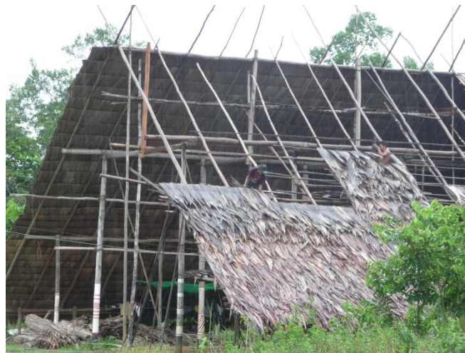
Pose de la nouvelle toiture de buçu en 2011.
