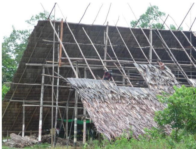
Pose de la nouvelle toiture de buçu en 2011.
