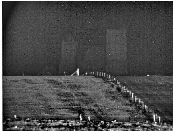
Figure 95. Images thermique acquise avec l'instrument MILPAT (capteur thermique) de la Cathédrale de Bourges par temps de pluie et avec l'application d'une augmentation de contraste.
