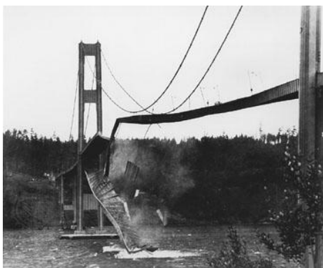
(b) Pont de Tacoma Narrows au moment de l'effondrement sous l'effet du vent (source : http://www.egretsnest.files.wordpress.com )
