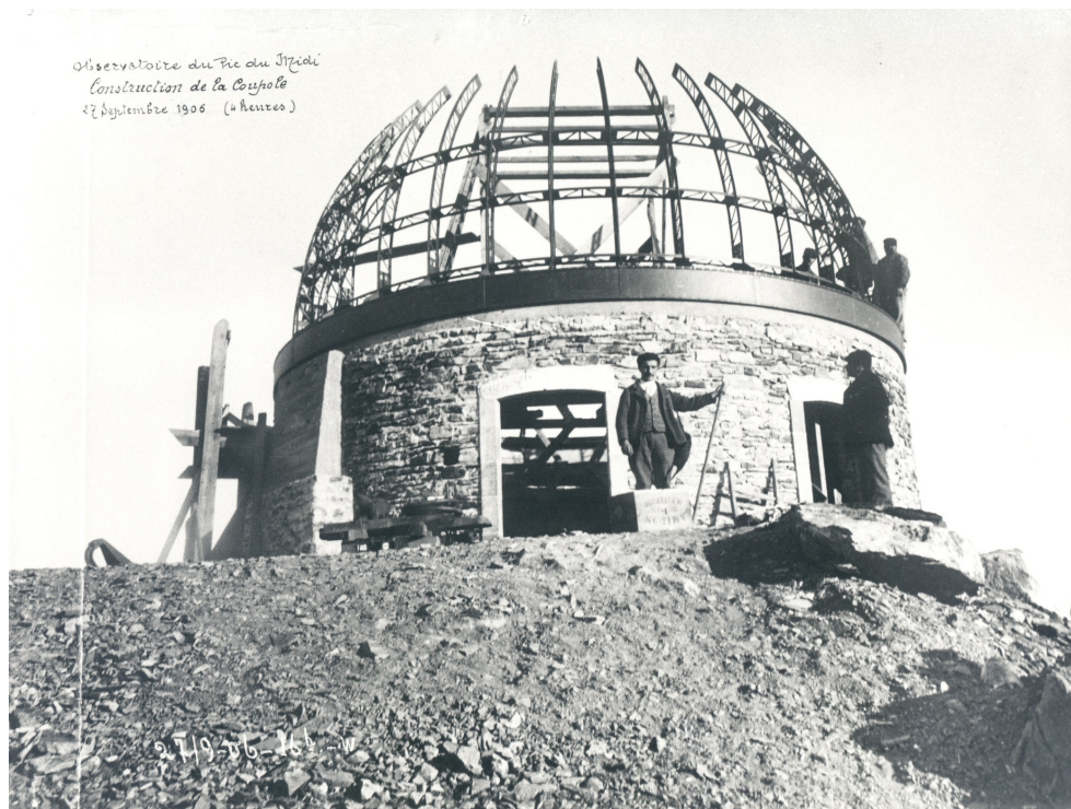
Document 13. La coupole Baillaud en cours de construction en 1906.
