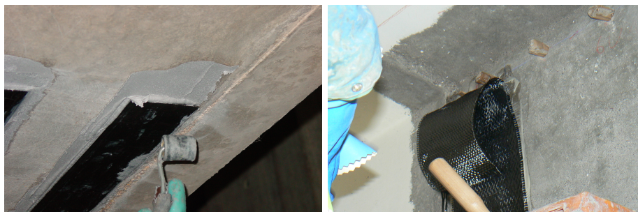
FIGURE 3.1: Photos de l'installation d'un plat pultrudé à fibres de carbone à gauche et d'un tissu sec bidirectionnel à fibres de carbone à droite
