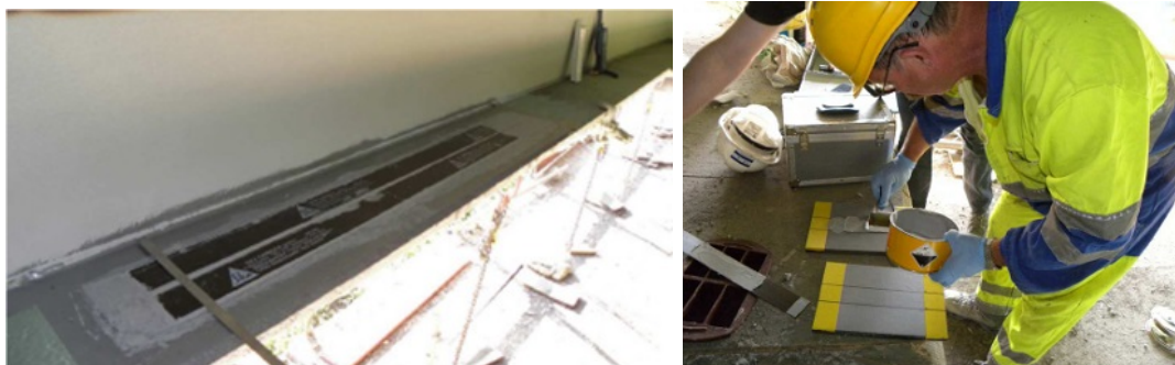
FIGURE 4.7: Photo des renforts composites appliqués sur l'ouvrage du Dancourt et de la réalisation des éprouvettes de cisaillement pour l'épreuve de convenance et le suivi (Laboratoire d'Autun)
