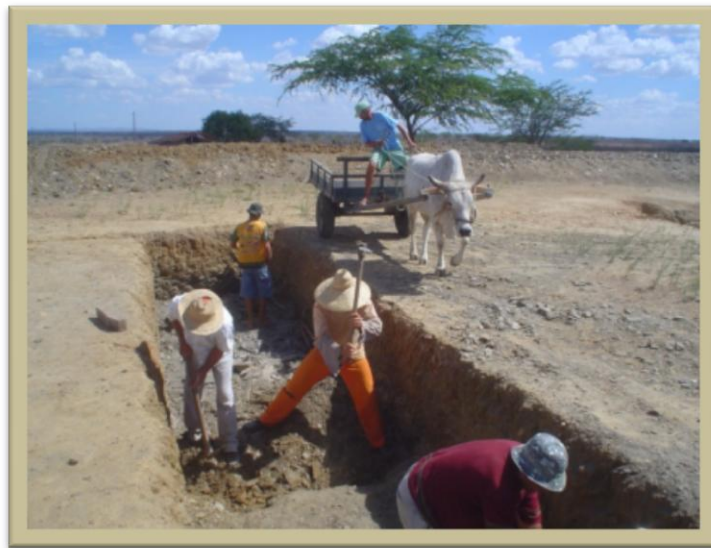
PHOTO 12 MUTIRÃO DE CONSTRUCTION DE BARRAGE SOUTERRAIN
