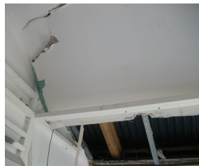
Figure III.12 : Démontage des plaques de placoplâtre.
