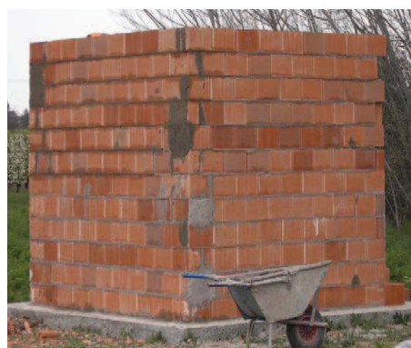
(d) Cabine en brique alvéolaire
