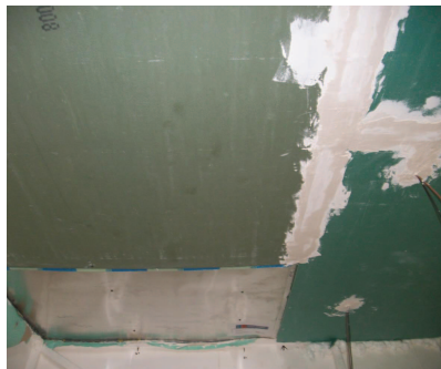
(a) Pose des MCP faux-plafond.
