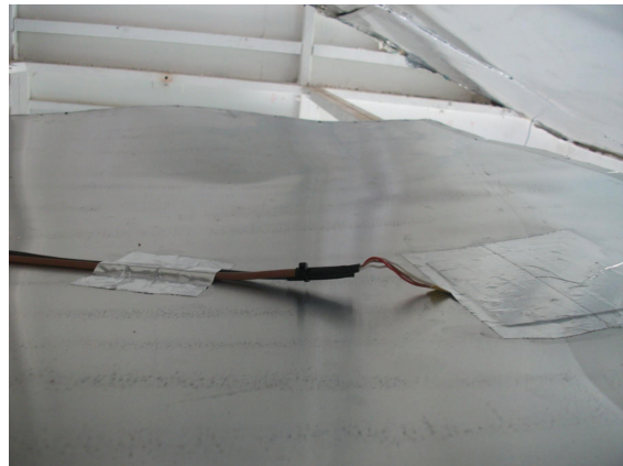
(b) Pose d'un fluxmètre en surface
