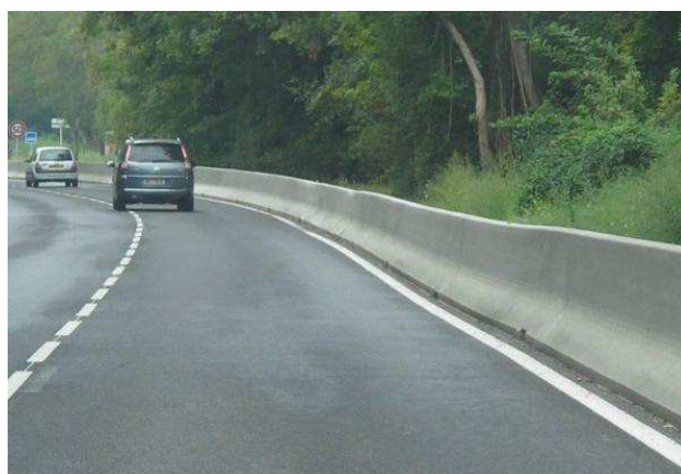
(d) Glissière en béton
