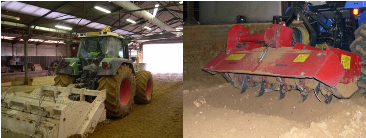
Figure 7.1 : Malaxage du matériau avec deux types de « rotavateur ».
