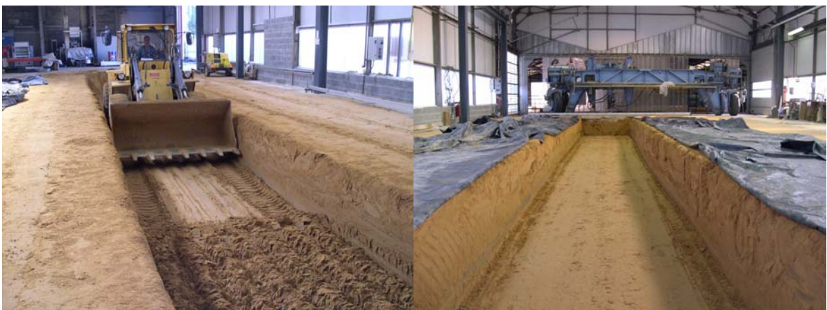
Figure 7.3 : Réalisation de la tranchée dans l'encaissant.
