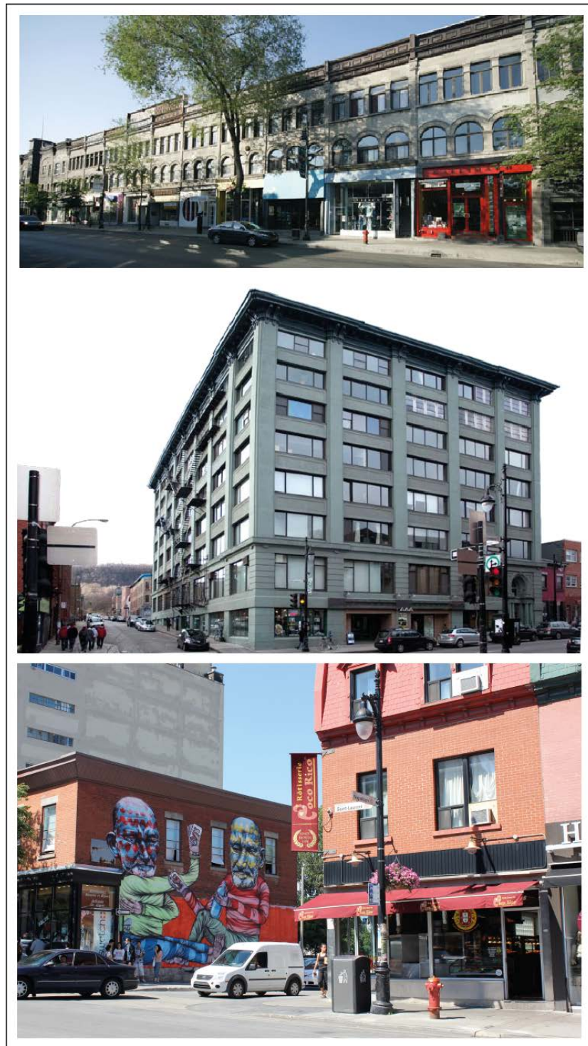
Figure 3.2. Les commerces et bâtiments des trois figures d'entrepreneurs de la SDBSL
