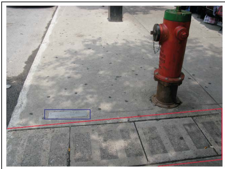
Figure 3.4. Le marquage au sol des dates de construction
