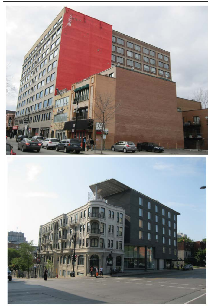
Figure 1.12. Le boulevard Saint-Laurent : « laboratoire d'architecture »
