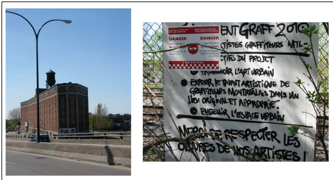
Figure 7.7. L'entrepôt Van Horne. En dessous du viaduc, pancarte sur les « graff »
