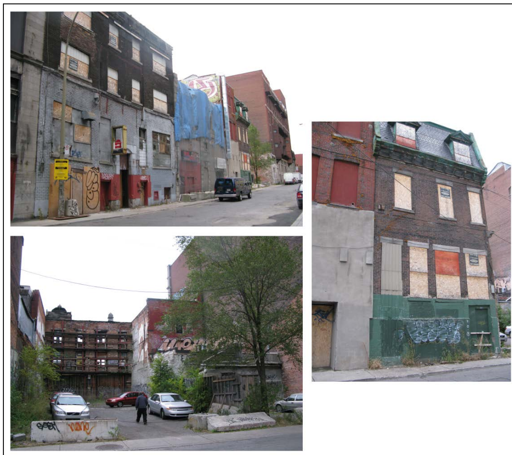
Figure 5.12. La détérioration du bâti des édifices du boulevard Saint-Laurent donnant sur la rue Clark
