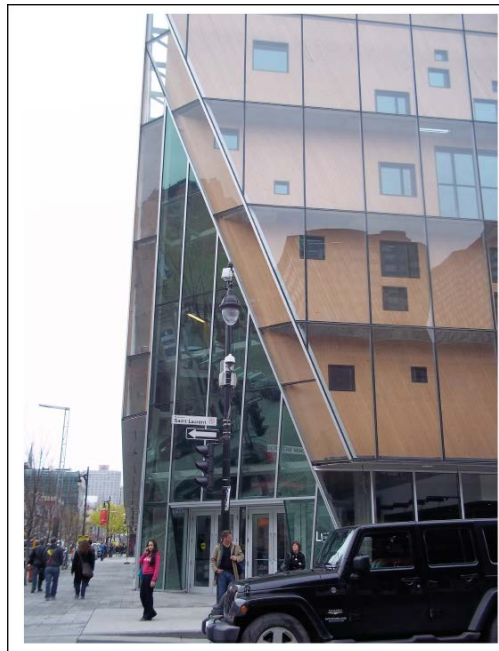
Figure 5.5. Le bâtiment du 2.22 avec son entrée au coin Saint-Laurent / Sainte-Catherine
