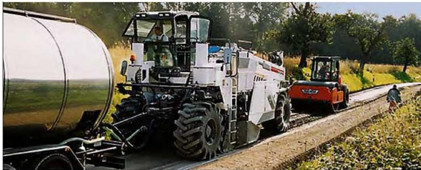
Figure II.5 – Atelier de recyclage en place à l'émulsion.
