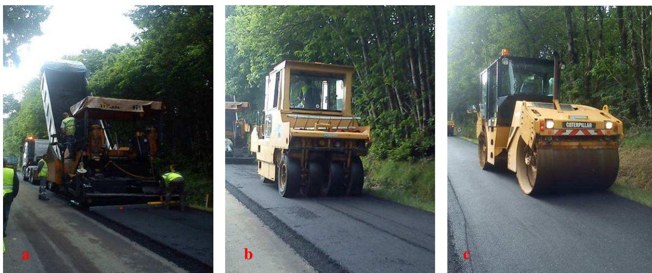
Figure II.4 – Finisseur (a), compacteur à pneus (b), compacteur à cylindre (c).
