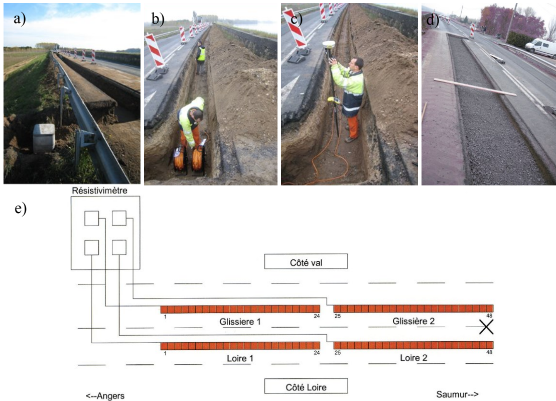
Figure 37. a) à d) Mise en place du système d'imagerie électrique (photos) et e) schéma d'implantation des « flûtes électriques ». [Guillon, 2008]
