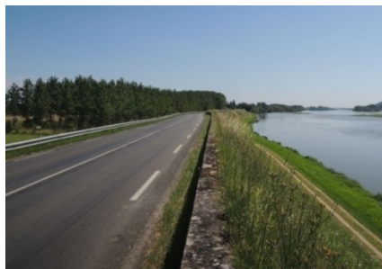
Figure 35. Site de St-Clément-des-levées sur la « Levée du val d'Authion-aval de Saumur ».
