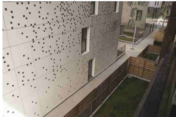
« Venelle » entre immeubles de logements
