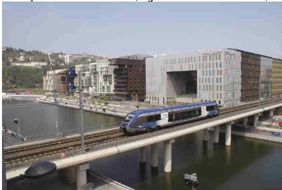
Franchissement ferré de la « darse »
