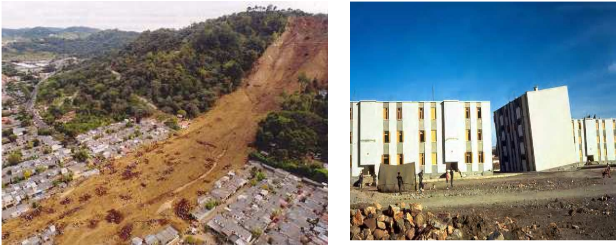
Figure 1. 12. Rupture diffuse, Glissement de terrain en rupture diffuse, Santa Tecla Salvador, 2001 ; Basculement de Bâtiment à El Asnam, Algérie en 1980.
