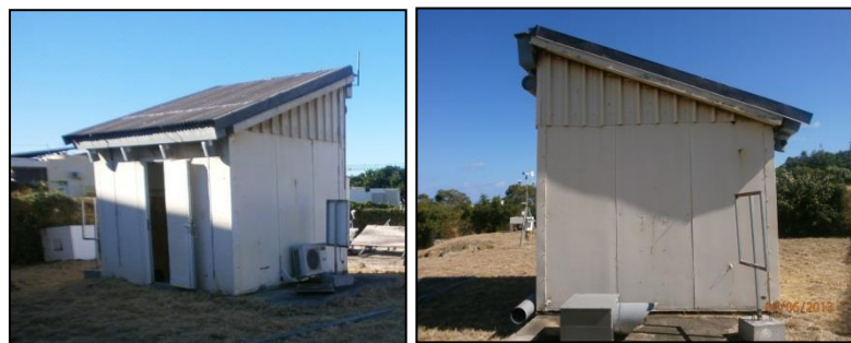
Figure 52 : Cellule LGI - Vues extérieures avant modification
