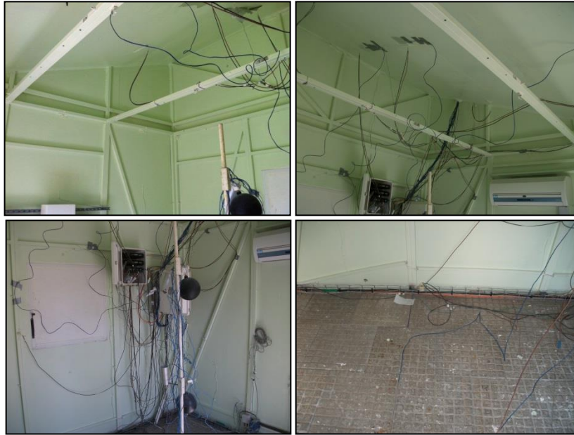
Figure 53 : Cellule LGI - Vues intérieures avant modification (Guichard 2013)
