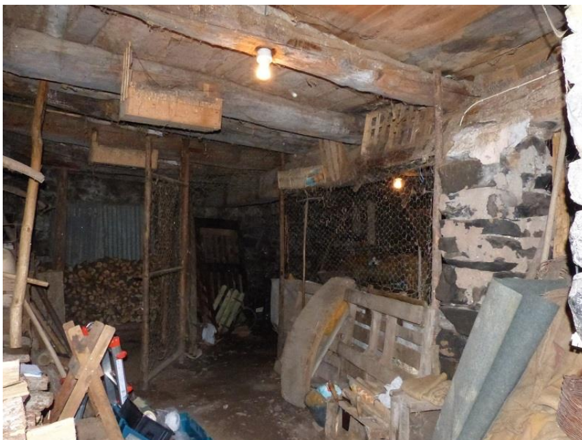
Figure 725 : Vue de l'écurie (rez-de-chaussée) depuis le sud-ouest (La Javie).
