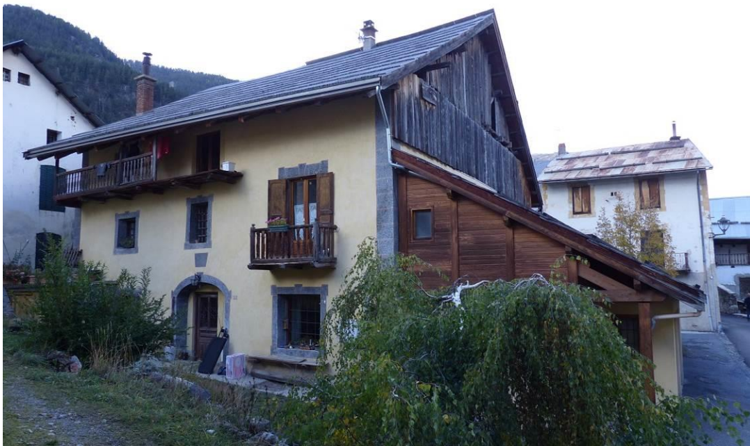
Figure 397 : Vue de la maison sud depuis le sud-est, mai 2014 (le Serre, Val-des-Prés).
