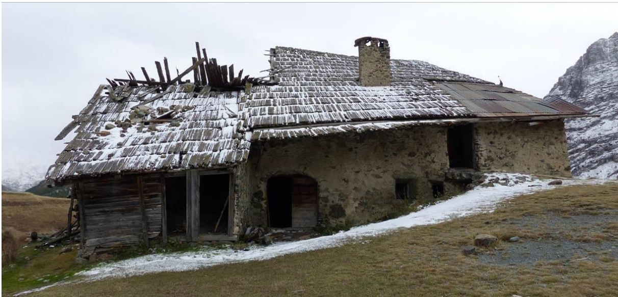
Figure 457 : Façade nord-est, octobre 2013 (les Fraches, Cervières).
