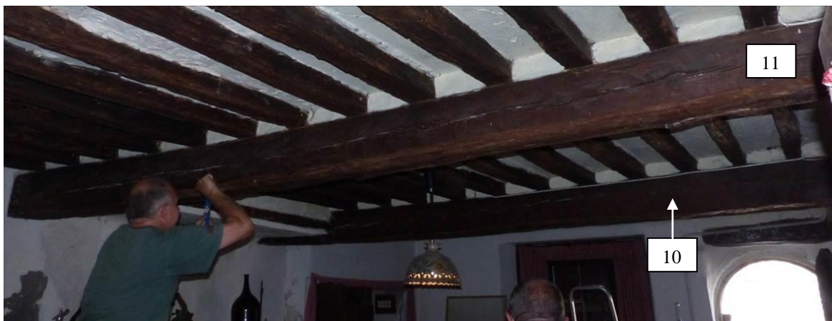
Figure 239 : Détail de la poutre 11 (La Javie).
