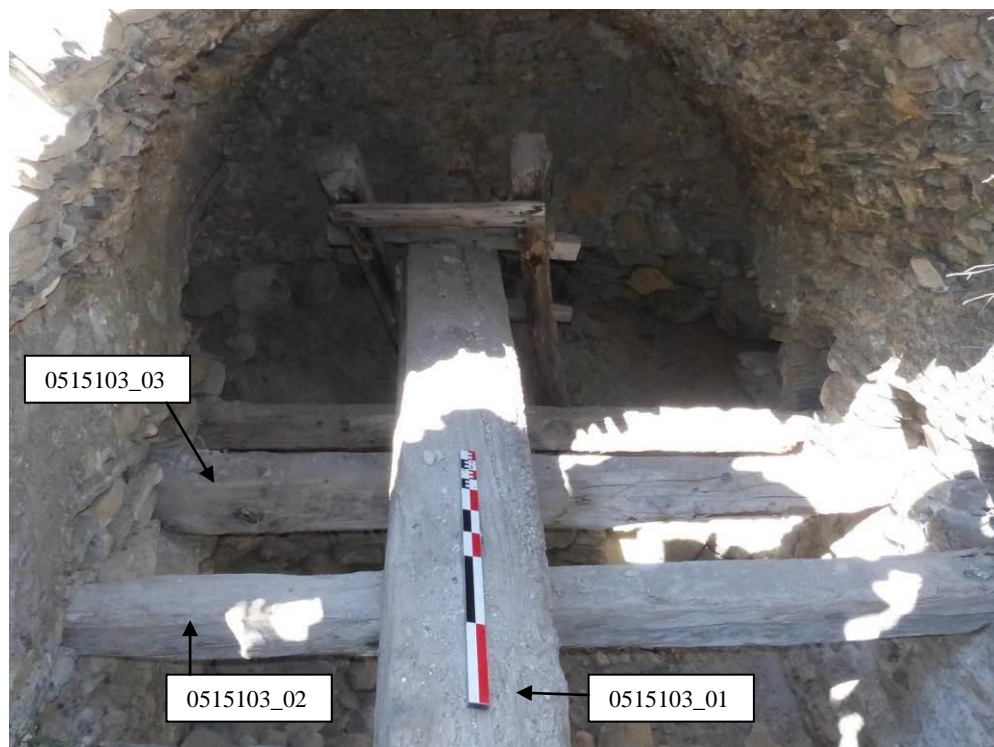
Figure 141 : Pressoir Bermont B04 (0515103). Le levier repose sur les solives et les jumelles.
