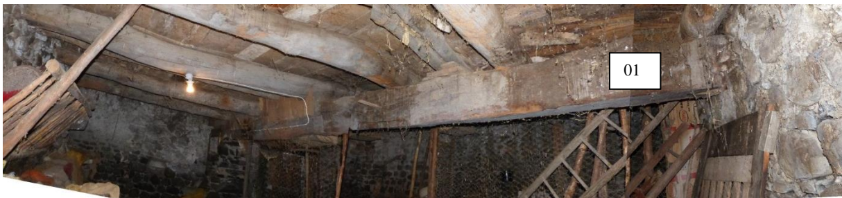
Figure 731 : La poutre 01, orientée sud-ouest nord-est soutient les solives (La Javie).
