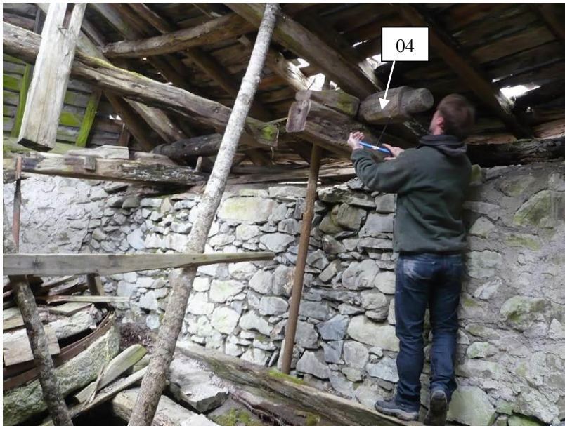
Figure 618 : Carottage de l'ancien arbre de transmission réemployé (VIOL 04), par V. Labbas. Cette pièce est coincée entre les arbalétriers ouest et les entrants des fermes sud et centrales (les Viollins, Freissinières).
