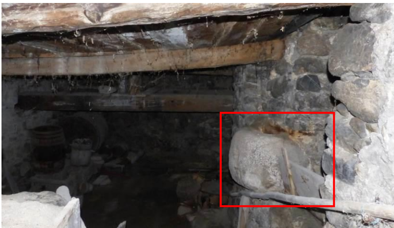
Figure 635 : Une pierre de contrepoids est prise dans la maçonnerie du mur nord, à 1 m du sol (la Fare, La Roche-de-Rame).
