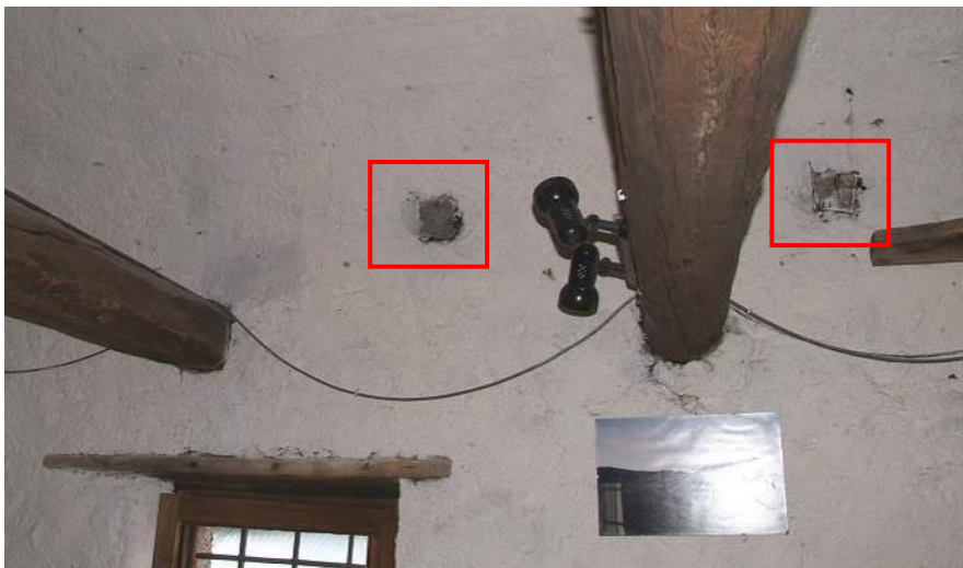
Figure 422 : Détail de deux des trois sections de poutres prises dans la maçonnerie du mur oriental (le Serre, Val-des-Prés).
