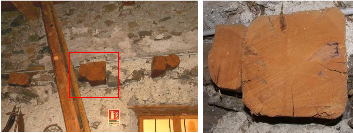
Figure 83 : Mur sud du fenil (niveau 3) où se trouve la poutre sciée 10 et détail de cette poutre (le chef-lieu, Cervières).
