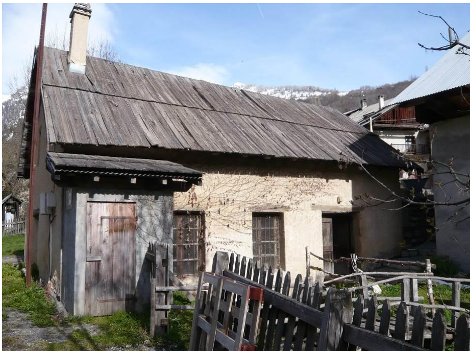
Figure 626 : Façade est du moulin des Ribes (les Ribes, Freissinières).
