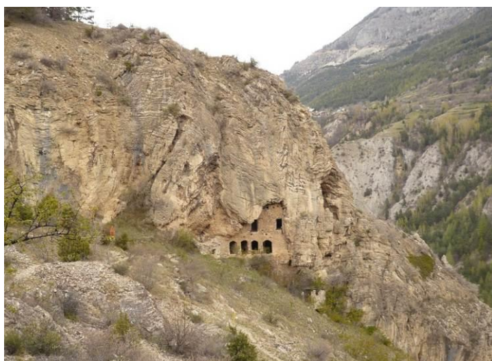
Figure 128 : Vue de la Balmette et des installations troglodytes. Façade sud.
