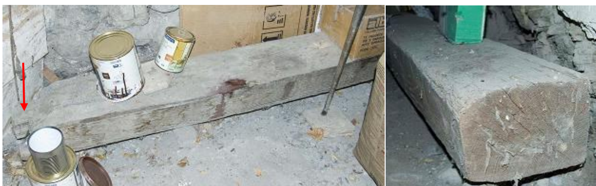
Figure 772 : Vues des extrémités ouest et est de la poutre où ont été réalisés les carottages 05. Un tenon est sculpté à l'extrémité ouest de cette longue poutre (flèche rouge, photographie de gauche) (Marcoux).
