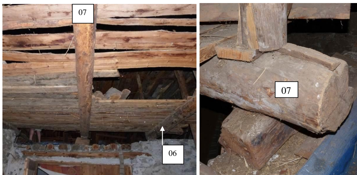
Figure 497 : Aire de battage de la grange vue vers l'est. Afin que le niveau supérieur soit horizontal, l'extrémité est de la solive 07 repose sur une cale en bois (la Chau, Cervières).
