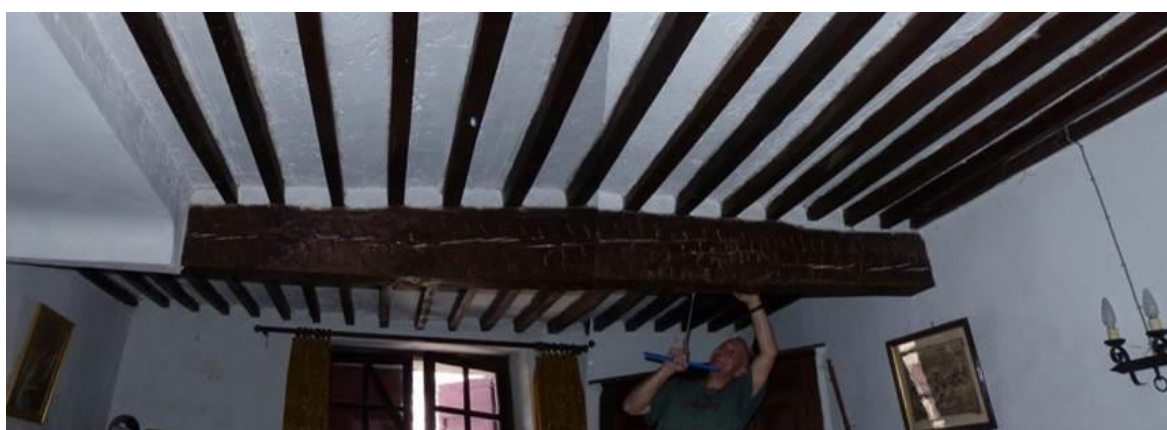
Figure 236: Vue de la chambre du premier étage côté route de Prads. La poutre 08 est celle proche de la fenêtre (La Javie).
