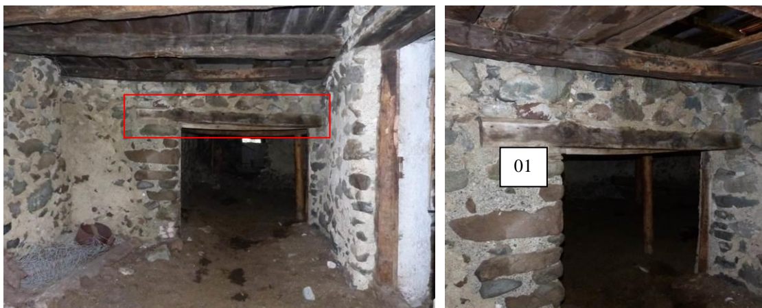
Figure 464 : Linteau de la baie séparant la cour nord-est de l'écurie (?), août 2014 (les Fraches, Cervières).
