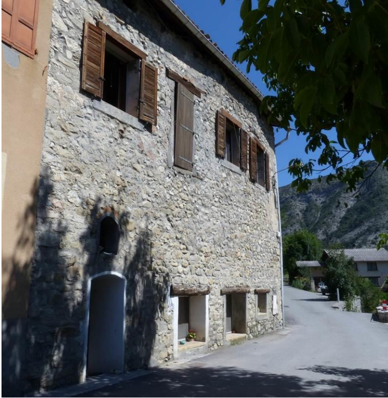
Figure 690 : Façade sud-est de l'ancien presbytère (Blégiers, Prads-Haute-Bléone).
