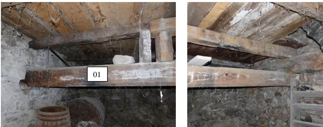
Figure 636 : Vues depuis l'est de la poutre 01 (la Fare, La Roche-de-Rame).
