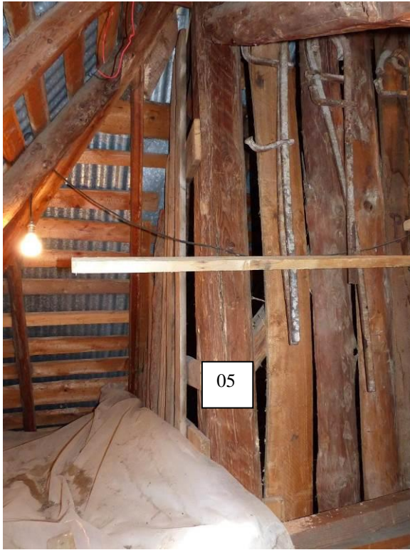
Figure 600 : Niveau supérieur de la grange, poinçon (05) de la ferme nord. Vue depuis le nord-ouest (Favette, L'Argentière-La Bessée).
