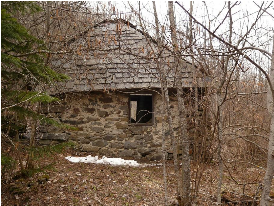
Figure 610 : Façade sud du moulin (les Viollins, Freissinières).
