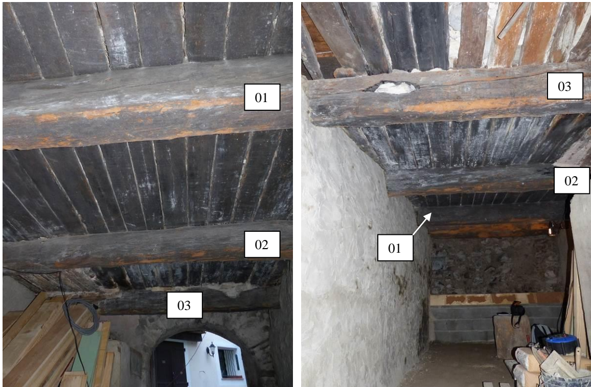
Figure 671 : Ecurie vue depuis le sud-est (à gauche) et depuis l'entrée nord-ouest (à droite) (Chanolles, Prads-Haute-Bléone).
