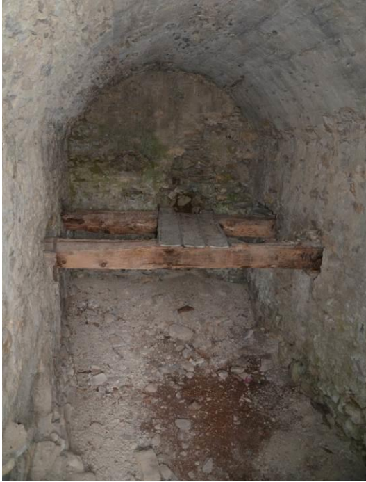
Figure 137 : Pressoir Martin Courcier B02 (0515102), seules deux solives sont conservées (cliché V. Labbas).
