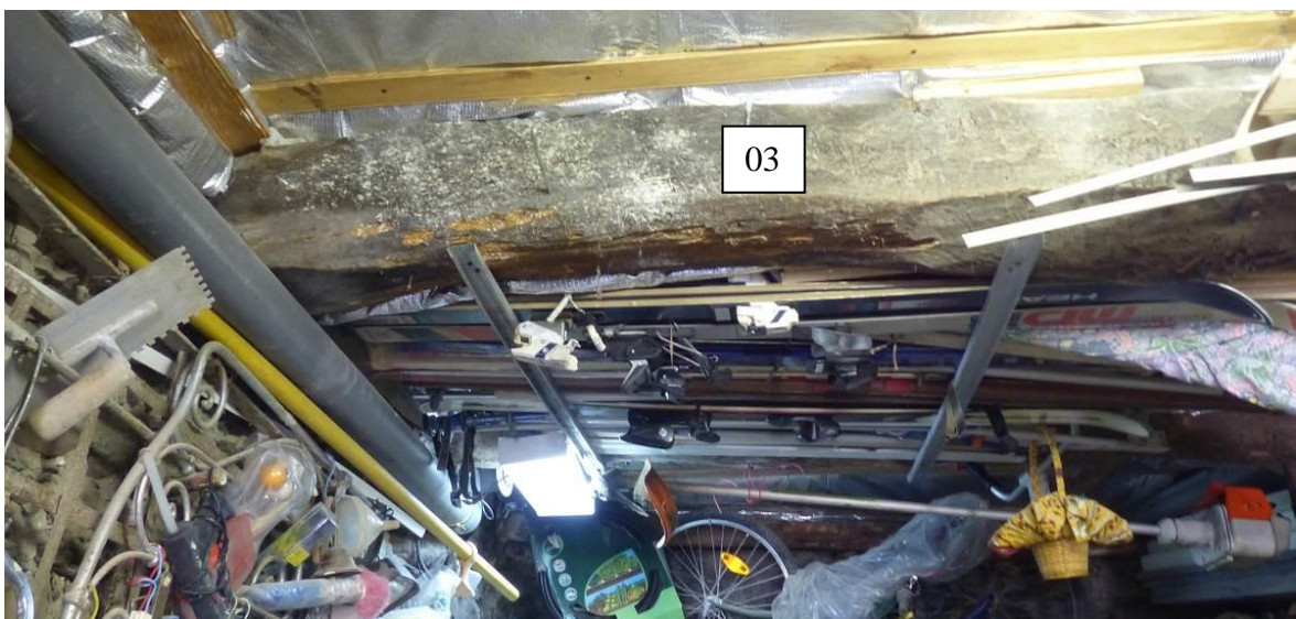
Figure 743 : La solive 03 se trouve dans l'écurie, près de l'entrée, au niveau inférieur de la maison (La Javie).
