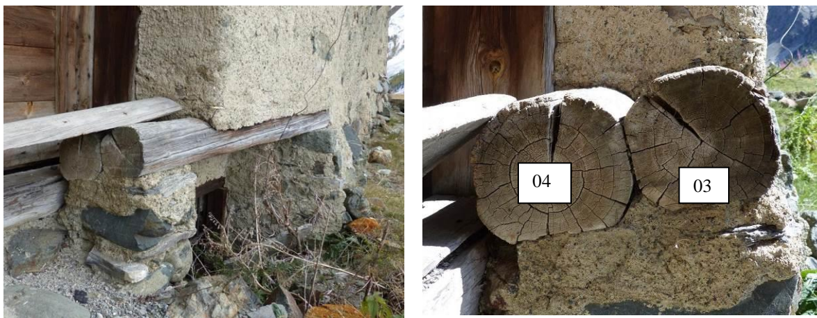
Figure 467 : Détails des poutres 03 et 04, provenant peut-être du même arbre, août 2014 (les Fraches, Cervières).
