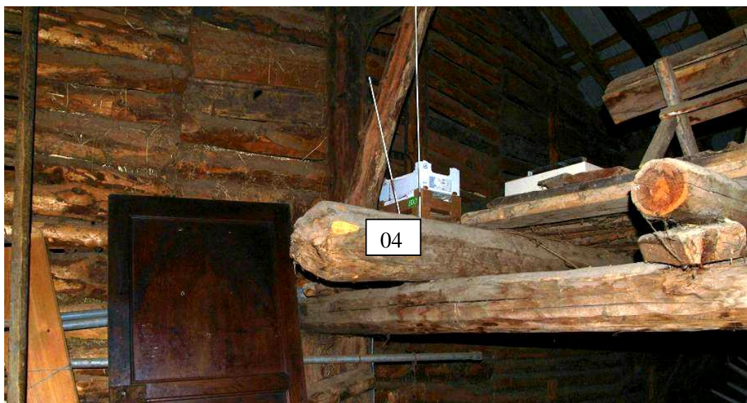
Figure 525 : Vue de l'extrémité sud de la solive 04, à l'ouest de la grange. Elle soutient le plancher du troisième niveau, au nord (le chef-lieu, Cervières).
