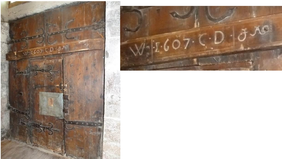
Figure 191 : Face intérieure du portail ouest et détail de l'inscription gravée sur la poutre transversale ; « W . 1607 . C . D . JA ».
