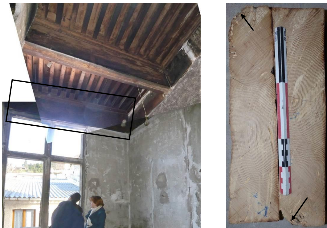
Figure 255 : Localisation de la planche 0416601_46 (partie supérieure du mur nord, deuxième étage). Sur la photographie de droite, les deux flèches indiquent les cernes les plus récents.
