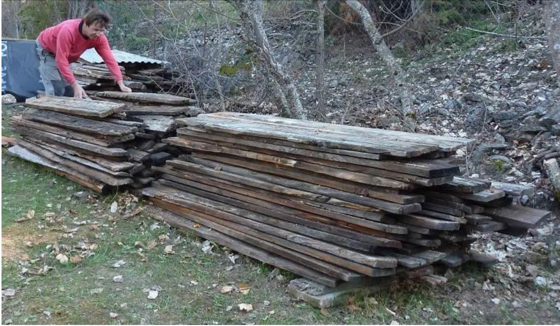
Figure 587 : Les planches et bardeaux de la grange sont déposés dans le jardin (La Bâtie, Les Vigneaux).
