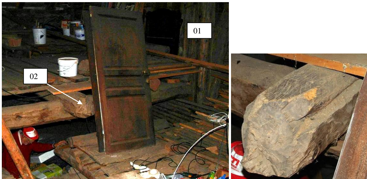
Figure 523 : Vue vers le sud de la grange, deuxième niveau. La solive 02 est orientée nord-sud. A droite, détail de l'extrémité nord de la solive 02, grossièrement taillée (le chef-lieu, Cervières).
