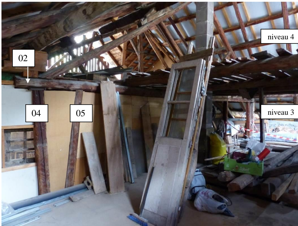
Figure 405: Cloison en pan de bois. Les niveaux 3 et 4 sont visibles sur cette vue depuis le sud-est (le Serre, Val-des-Prés).
