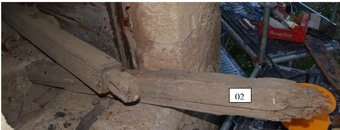
Figure 658 : Photographie de la pièce de bois 02, celle posée directement sur le seuil de la baie (Mont-Dauphin).
