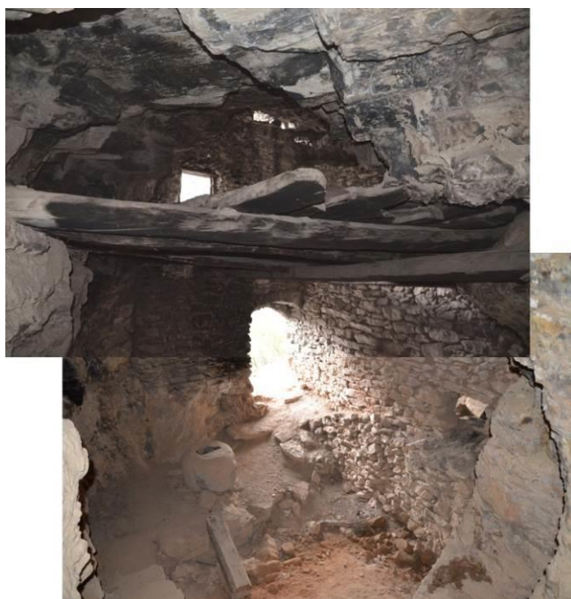
Figure 129 : Cellule sud des installations troglodytiques, vue depuis le fond (depuis l'est). Un plancher est encore en place, qui divise cette cellule en deux niveaux (photographies V. Labbas).
