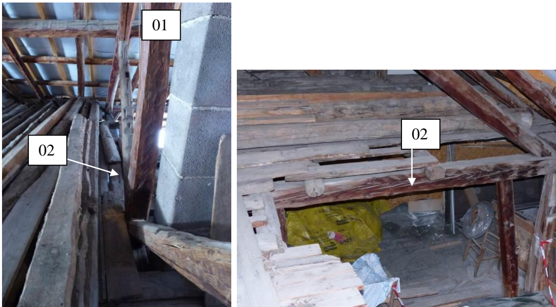
Figure 403 : Entrait de la deuxième ferme en partant de l'est, orienté nord-sud (le Serre, Val-des-Prés).
