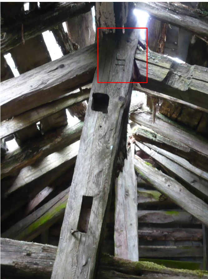
Ferme centrale. Deux encoches sont gravées dans la partie supérieure du poinçon, sur la face est.
