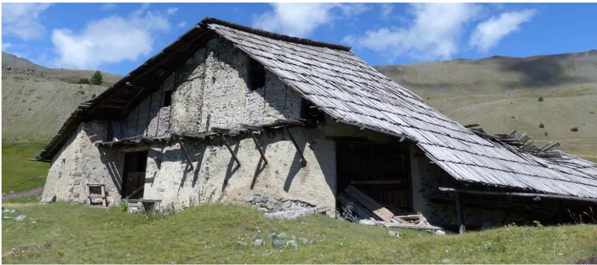
Figure 459 : Vue des fermes depuis l'ouest, août 2014 (les Fraches, Cervières).
