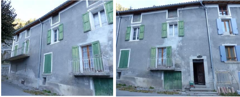
Figure 709 : Vues de la façade ouest. Le bâtiment étudié est construit dans le prolongement de l'ancien moulin (à droite de la gouttière sur la photographie de droite) (le Moulin, La Javie).
