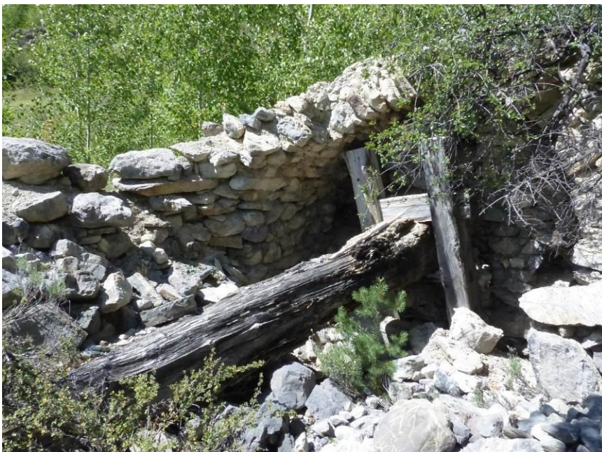
Figure 155: Pressoir B09 (0515107), la voûte du cellier est conservée dans sa partie nord, à droite sur la photographie.
