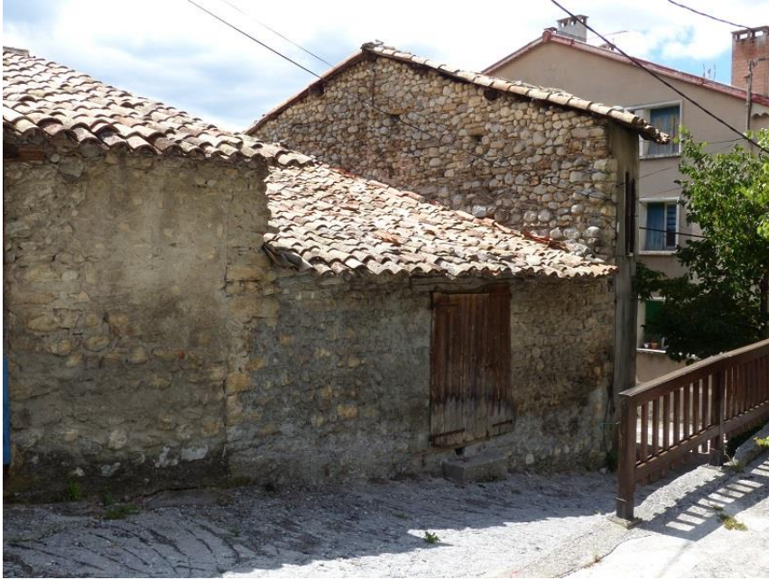
Figure 726 : L'accès à la grange (premier étage) s'effectue aujourd'hui uniquement depuis l'arrière du bâtiment (depuis le nord-est), par la porte à doubles battants visible au centre de la photographie (La Javie).
