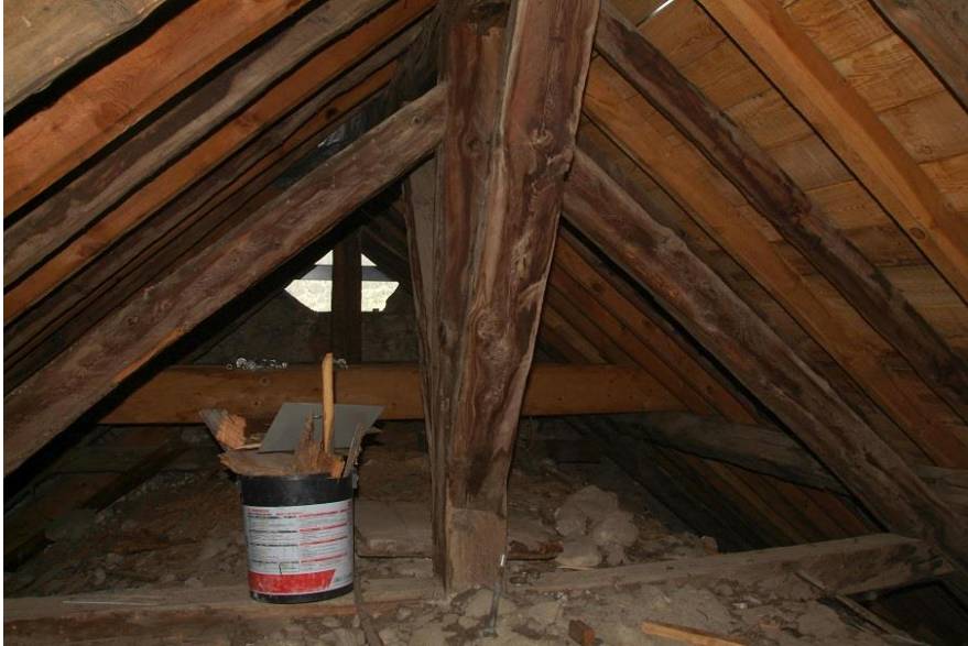
Figure 656 : Vue de la charpente des combles (non étudiée) depuis l'est (Mont-Dauphin).
