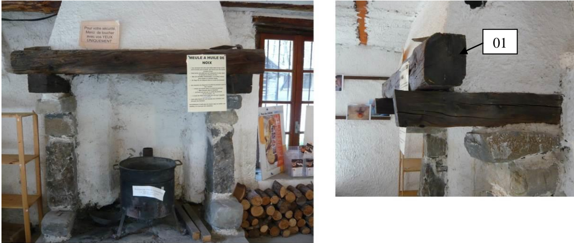
Figure 629 : Au sud du deuxième niveau du moulin des Ribes, le linteau de la cheminée a été mesuré à son extrémité ouest (RIBE01) (les Ribes, Freissinières).
