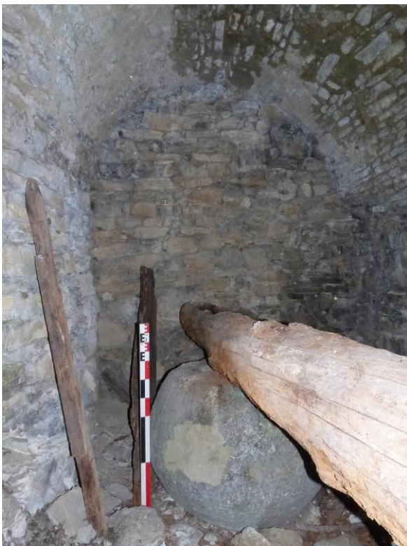
Figure 152 : Pressoir B08 (0515106), le levier repose sur la pierre de contrepoids, dans la partie sud-ouest du cellier.
