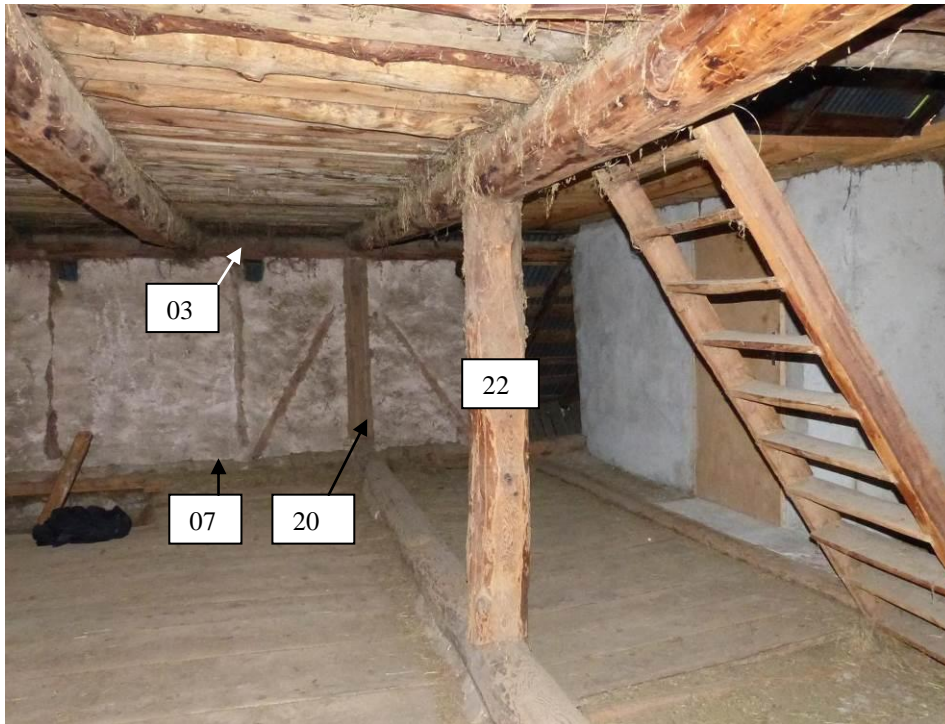
Figure 34 : N+2, vue vers le nord-est de la grange. L'échelle de meunier reliant l'aire de battage à ce niveau, se trouve dans la partie gauche de la photographie. A droite, l'échelle mène à N+3 (le Serre, Val-des-Prés).
