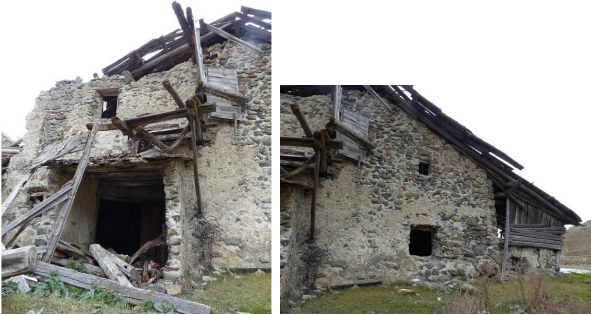
Figure 456 : Détails de la façade sud des fermes. A gauche, le porche donnant accès à la cour sud. A droite, l'extrémité est du mur pignon sud, octobre 2013 (les Fraches, Cervières).
