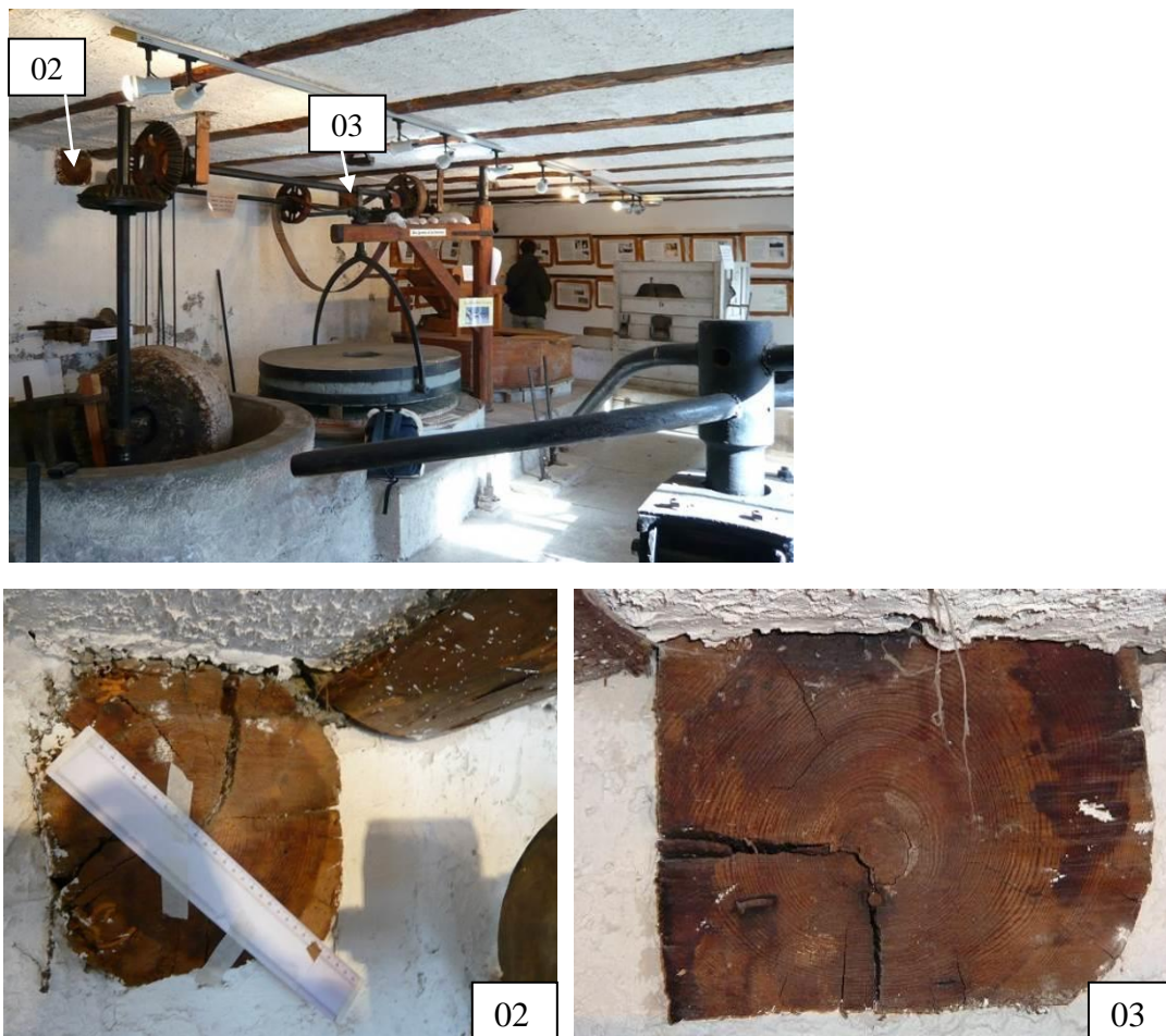
Figure 630 : Deux extrémités de solives ( ?), prises dans le mur ouest ont été étudiées au moulin des Ribes (RIBE02 et RIBE03) (les Ribes, Freissinières).
