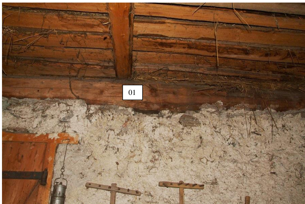
Figure 71 : Grange, niveau 4, mur nord. Détail de la partie orientale de la panne sablière 01 (le chef-lieu, Cervières).
