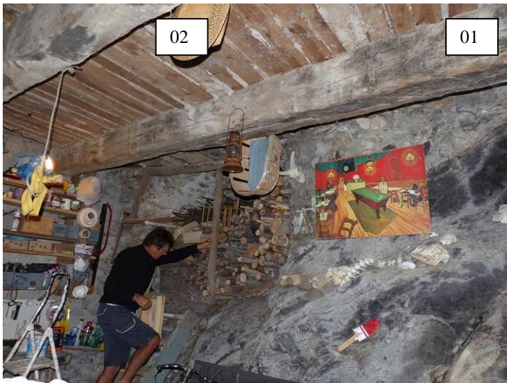
Figure 750 : Vue de la partie nord-est de l'écurie. Contre la paroi rocheuse se trouve la solive 01. La solive 02 est visible dans le coin supérieur gauche de la photographie (La Javie).
