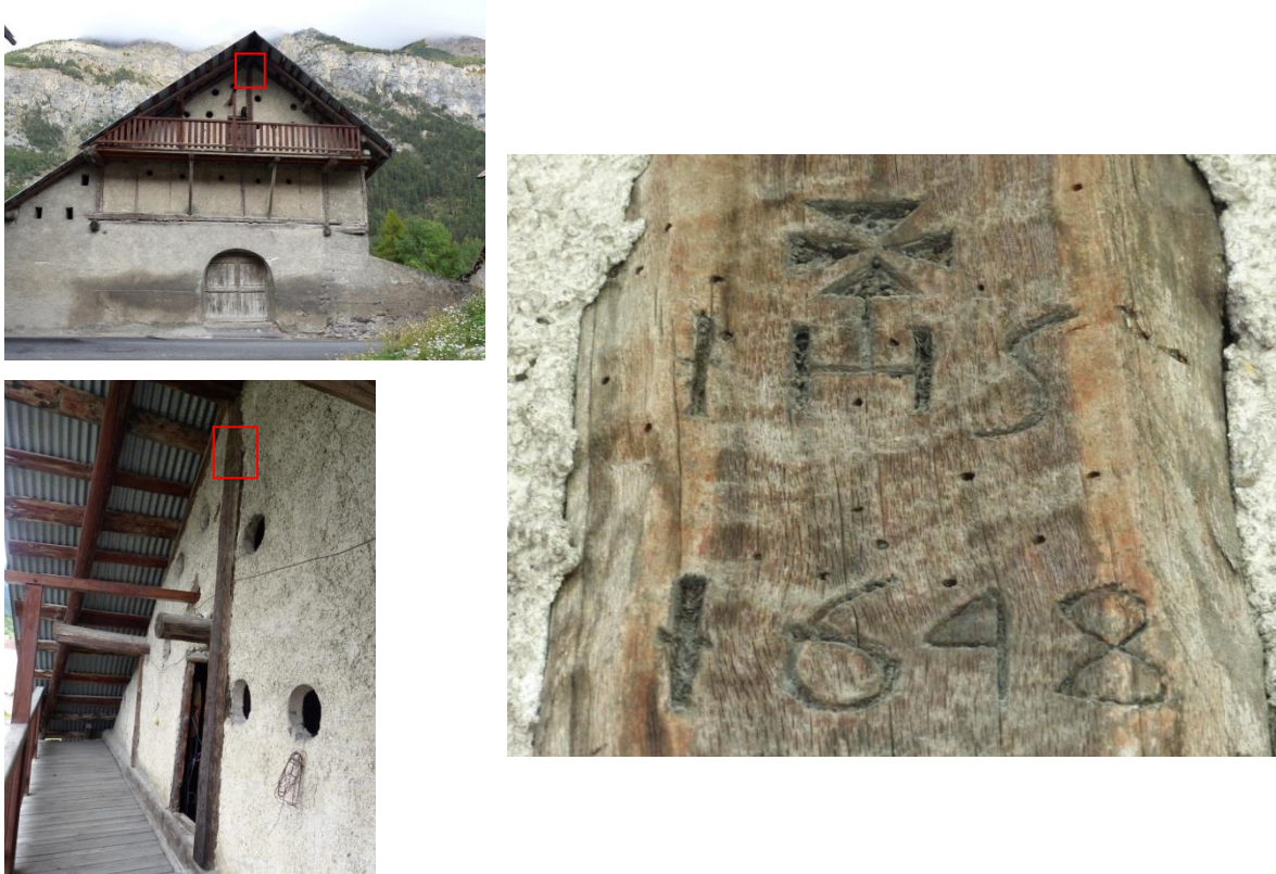
Figure 30 : Localisation et détail de l'inscription datante gravée dans la partie supérieure du poinçon de la ferme ouest : «IHS / 1648 » surmonté d'une croix pattée (le Serre, Val-des-Prés).
