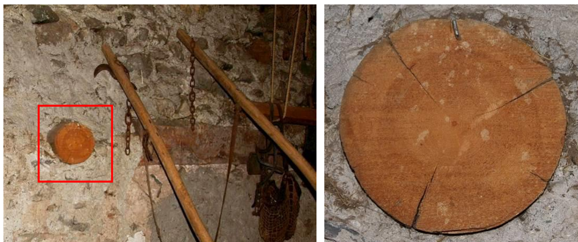
Figure 72 : Grange, niveau 4. Vue du mur oriental où se trouve la poutre sciée 02 et détail de cette poutre (le chef-lieu, Cervières).
