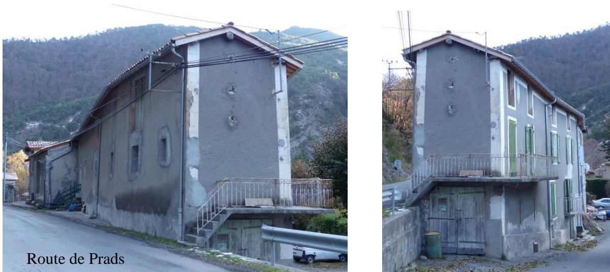
Figure 708 : Vue du bâtiment vers le sud-est (à gauche) et vers le sud-ouest (à droite) (le Moulin, La Javie).
