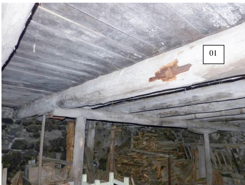
Figure 491 : Ecurie vue vers le nord-ouest. Les huit solives les plus au nord sont étayées car le mur ouest est très humide (l'hiver, la neige s'accumule dans la ruelle entre cette ferme et celle immédiatement à l'ouest). Cette opération a eu lieu dans l'enfance de M. Aschkanian, dans les années 1960 (longueur d'une solive : 5,60m) (la Chau, Cervières).
