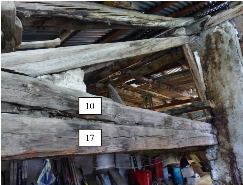
Figure 370 : Grange, N+2 et N+3, vue vers le nord-ouest, ferme centrale. Les faces orientales des pièces 10 et 17, visibles sur le cliché, ont été exposées aux intempéries (Pra Premier, Val-des-Prés).
