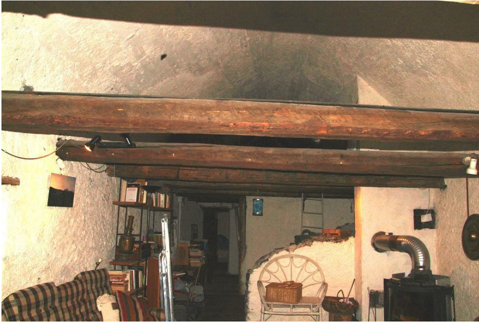
Figure 421 : Grenier, vue depuis le nord (le Serre, Val-des-Prés).
