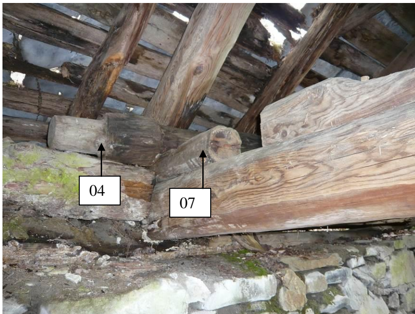
Figure 620 : La pièce 07, posée sur l'extrémité ouest de l'entrait de la ferme sud maintient l'arbre de transmission 04 en place (les Viollins, Freissinières).
