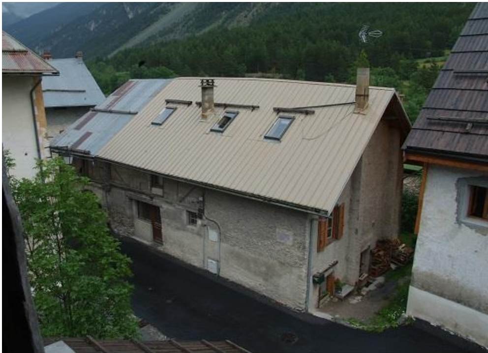
Figure 383 : Vue de la maison depuis le sud-ouest, depuis la grange de la ferme Pourbaix-Toussaint (0511705) octobre 2013 (le Serre, Val-des-Prés).
