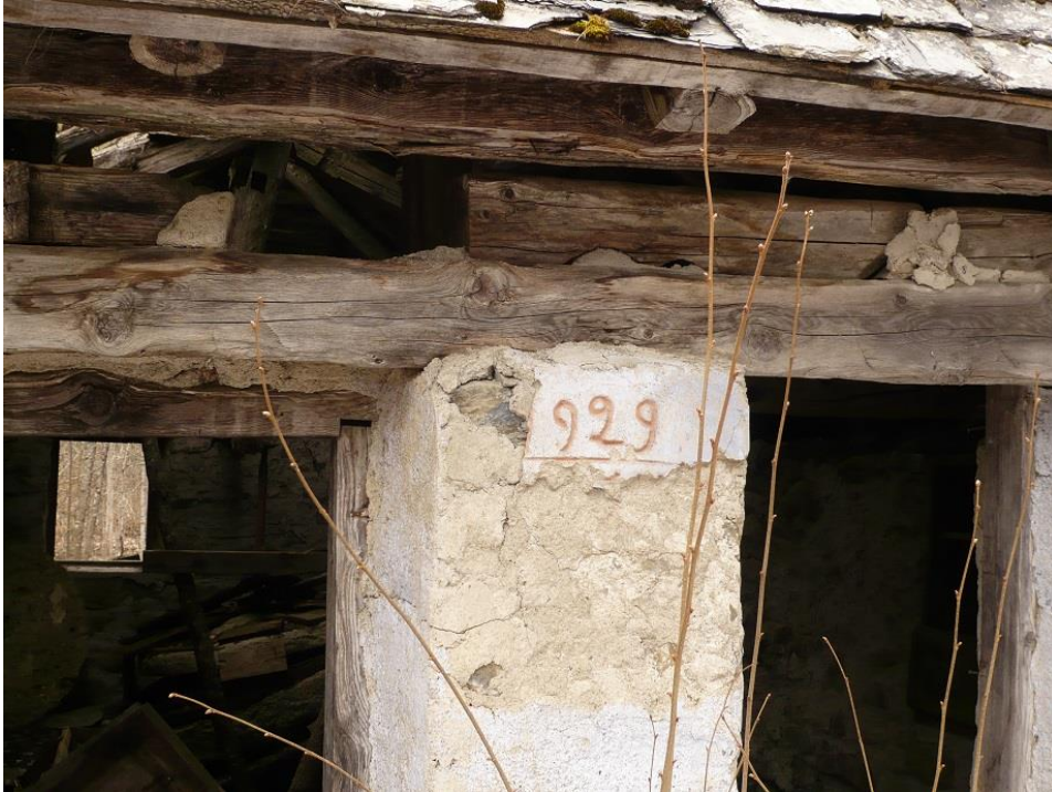
Figure 607 : Inscription « 929 » (anciennement « 1929 ») inscrite sur l'enduit et teintée en rouge, au centre de la façade nord (les Violins, Freissinières).
