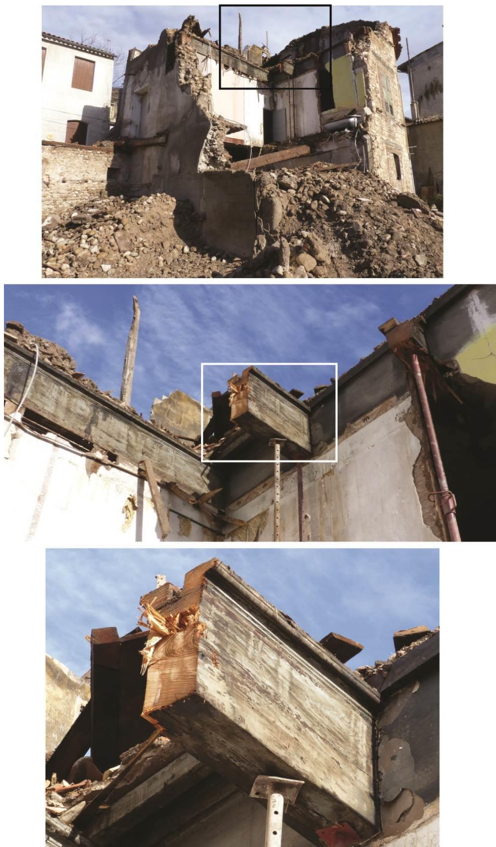
Figure 271 : Détail du plafond sud-ouest du premier étage, corps de bâtiment nord de l'hôtel Ferrier, lors de la déconstruction. Sur la photographie inférieure, la coupe permet de distinguer l'assemblage entre l'une des poutres et les deux moultures qui la surmontent.
