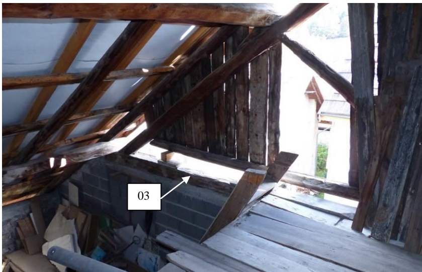
Figure 404 : Entrait de la première ferme en partant de l'est, orienté nord-sud (le Serre, Val-des-Prés).
