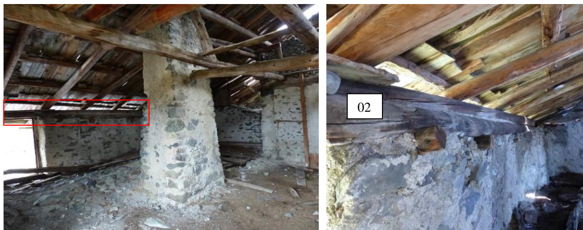
Figure 465 : Le deuxième prélèvement a été réalisé dans la panne sablière (longueur 7,50 m) du mur gouttereau nord-est, août 2014 (les Fraches, Cervières).
