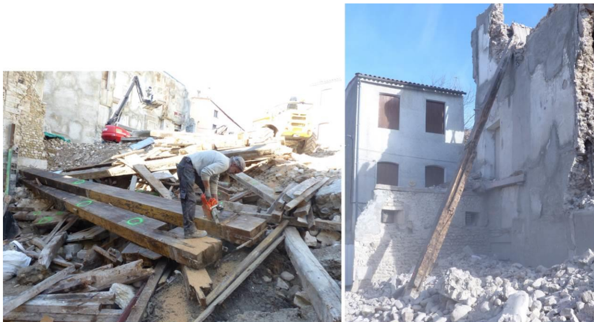
Figure 270 : Prélèvement des poutres de plafond, certainement celui du premier étage de l'hôtel Ferrier dont une partie était peinte en jaune et l'autre en marron (tronçonnage par Antoine, entreprise Turcan). A droite, une poutre provenant du plafond du deuxième étage est déposée (longueur 10 m).
