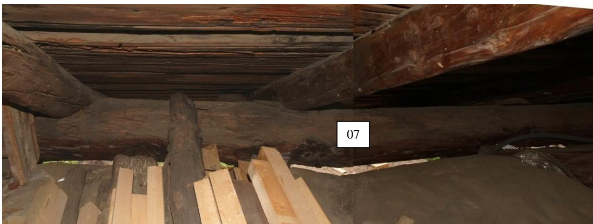
Figure 545 : Vue partielle de la panne sablière sud, 07 (le Pinet, Puy-St-Pierre).
