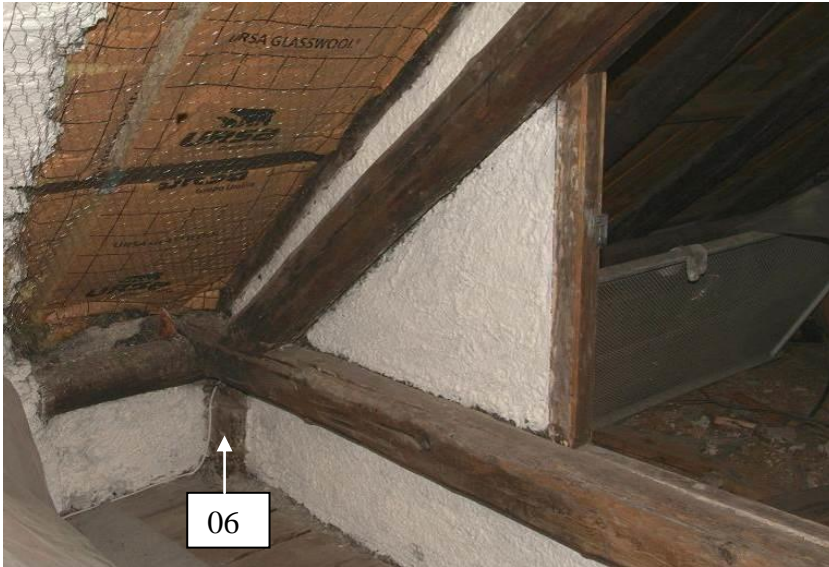
Figure 427 : Poteau soutenant l'entrait de la ferme précédant la partie sud. Vue depuis le nord-ouest (niveau 4) (le Serre, Val-des-Prés).
