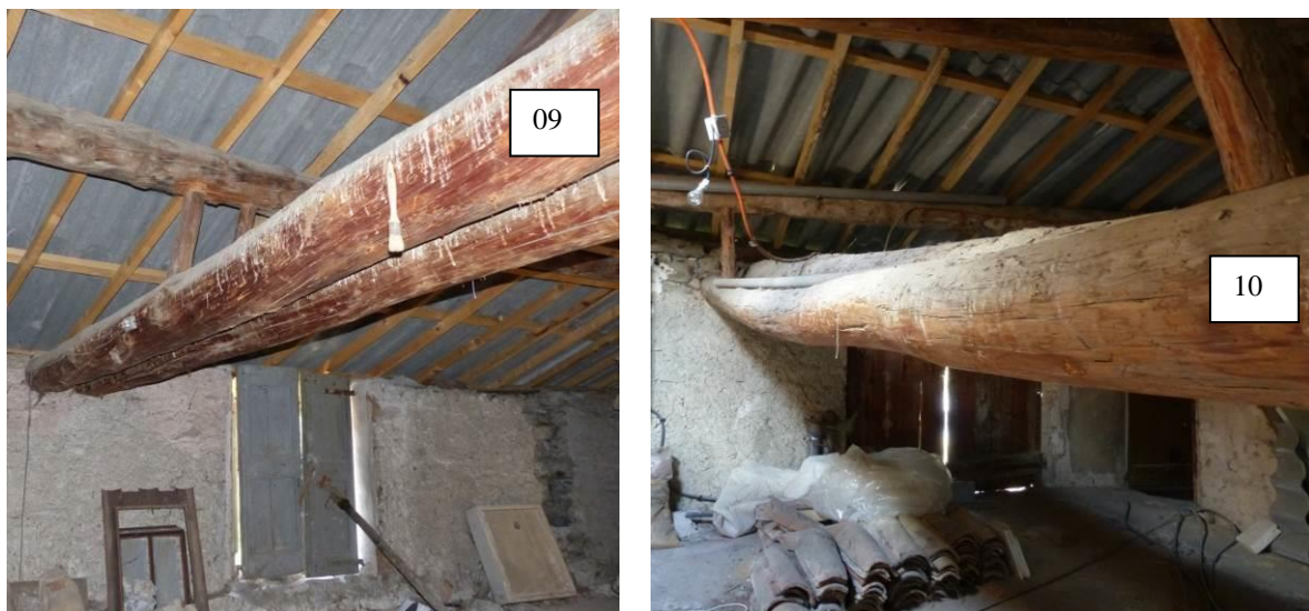
Figure 718 : Niveau 4, combles, pièce sud. A gauche, vue vers le nord-ouest, à droite, vue vers le sud-est. Les deux poutres 09 et 10 sont parallèles. Des sortes de jambettes, soutenant les pannes intermédiaires, reposent sur ces deux poutres, à l'est et à l'ouest (le Moulin, La Javie).
