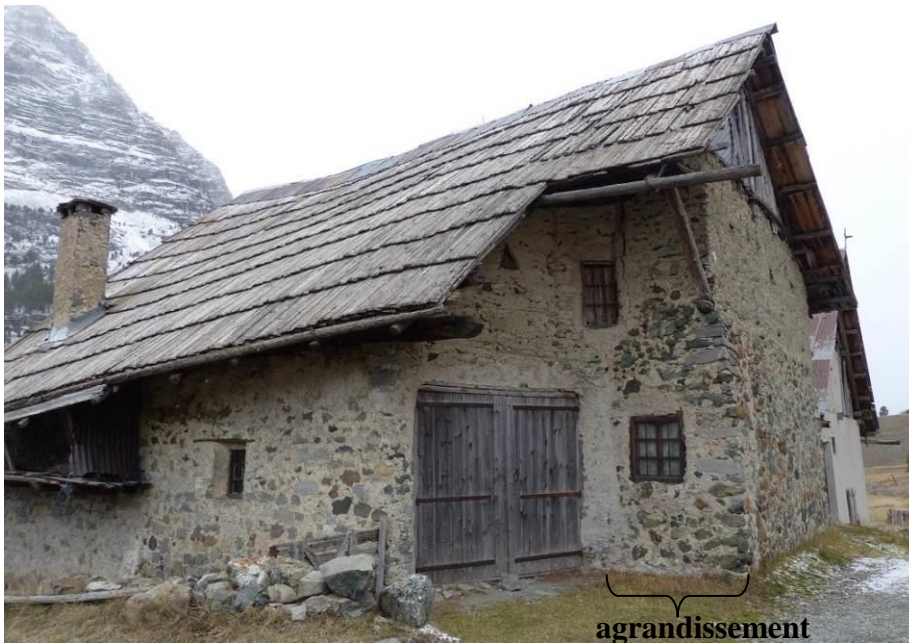
Figure 485 : Vue du bâtiment depuis le nord-est et de l'agrandissement au nord (la Chau, Cervières).
