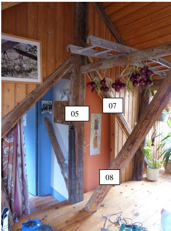
Figure 389 : Charpente des combles, vue de la ferme sud (le Serre, Val-des-Prés).
