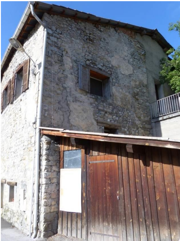
Figure 691 : Vue extérieure du bâtiment depuis le nord-est (Blégiers, Prads-Haute-Bléone).
