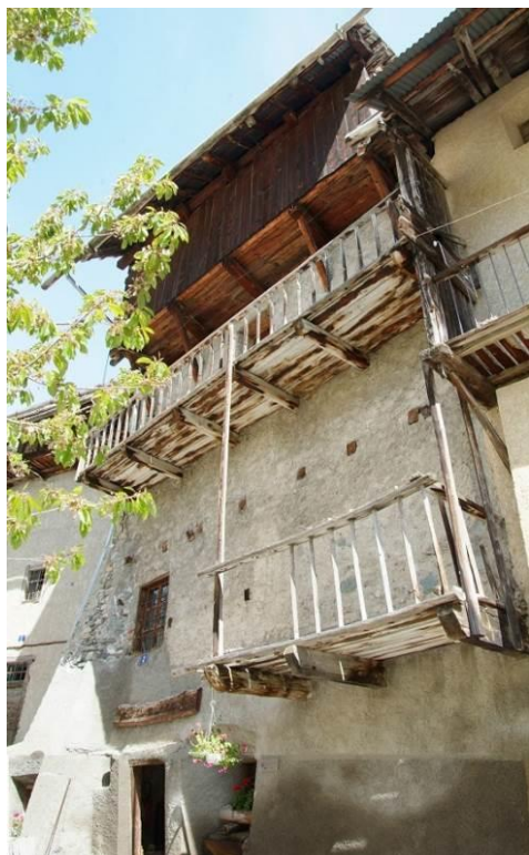
Figure 70 : Façade sud de la maison (le chef-lieu, Cervières).
