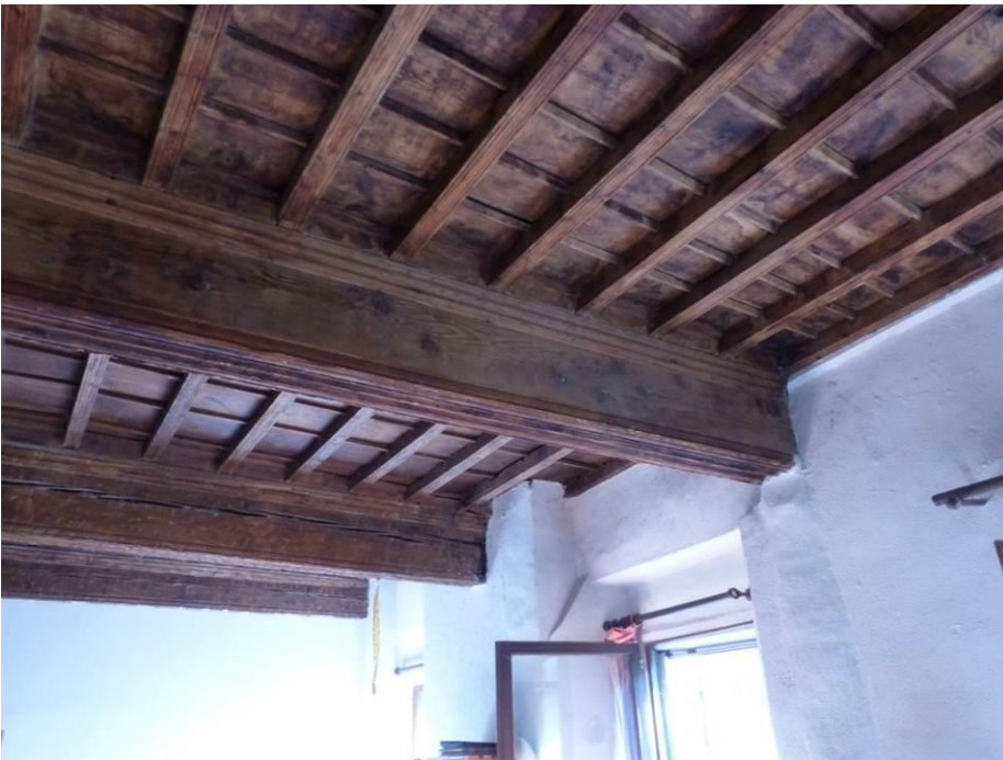
Figure 695 : Vue de la partie nord-est de la pièce et des poutres 02, 03 et 04 (Blégiers, Prads-Haute-Bléone).
