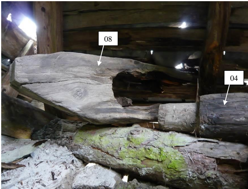
Figure 619 : La pièce 08 est posée au sommet du mur, dans l'angle sud-est du bâtiment. L'extrémité sud de l'arbre de transmission réemployé (04) est visible dans la partie droite de la photographie (les Viollins, Freissinières).
