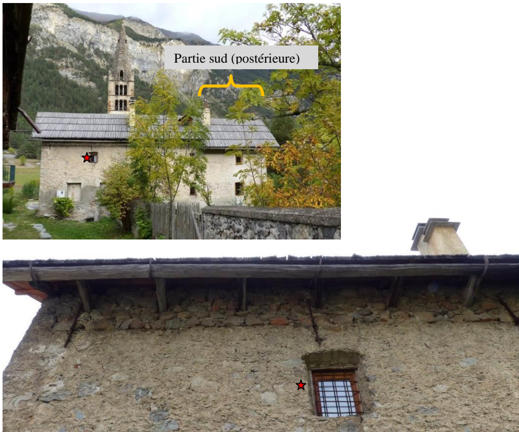
Figure 419 : Façade ouest, ensemble et détail de la partie nord. La partie supérieure de ce mur gouttereau a été construite dans un deuxième temps (rehaussement de la charpente ?) (le Serre, Val-des-Prés).
