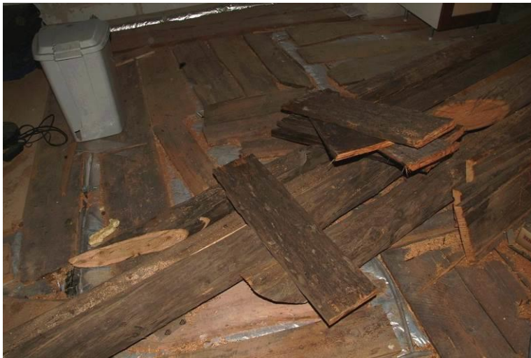
Figure 547 : Vue des poutres déposées provenant de la grange de Puy-Richard (01, 02 et 03). Sur celles-ci reposent les bardeaux prélevés (11 à 17) (le Pinet, Puy-St-Pierre).
