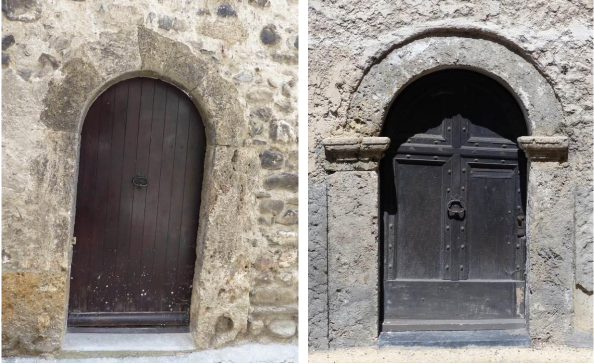
Figure 230 : A gauche, porte nord-est (côté ruelle) et à droite, porte sud-ouest (côté route de Prads) (La Javie).
