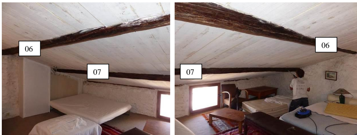
Figure 753 : Vues des combles (niveau 4) depuis l'est. A droite, carottage de la panne 07 ; la panne 06 est au premier plan (La Javie).
