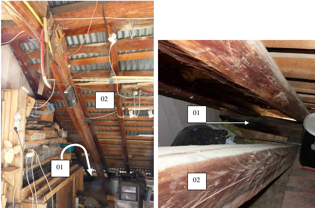
Figure 598 : Vues vers le sud-ouest du niveau inférieur de la grange : la panne sablière ouest (01) et l'arbalétrier de la ferme sud (01) ont été échantillonnés (Favette, L'Argentière-La Bessée).
