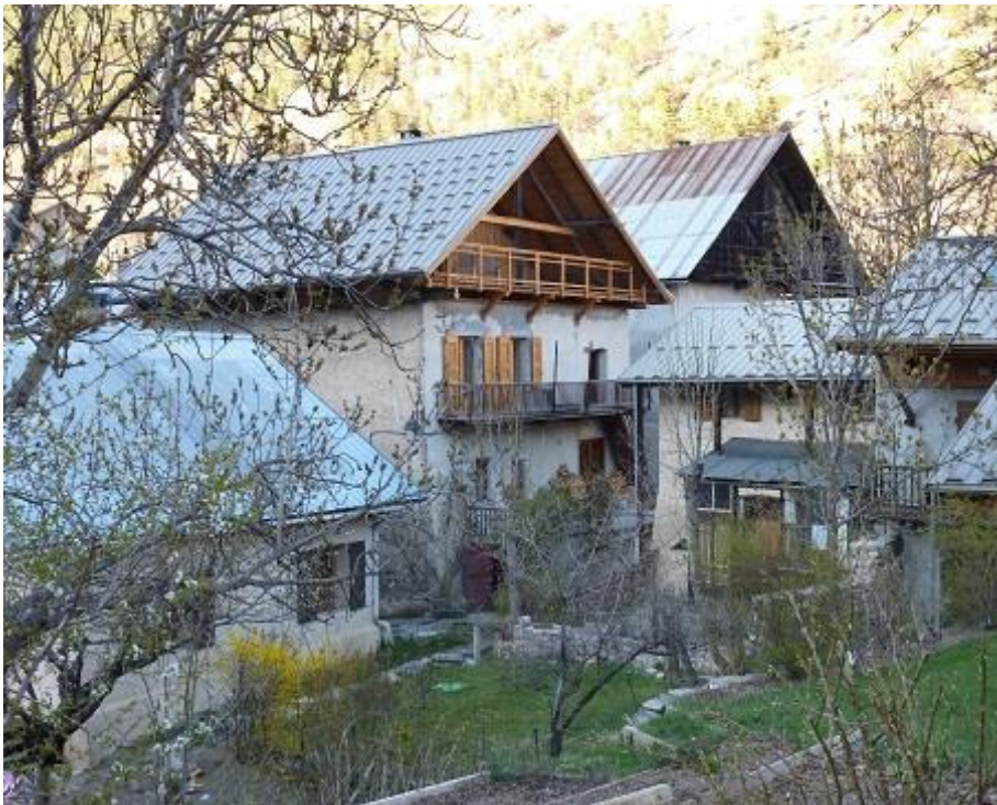
Figure 584 : Vue de la maison depuis le sud-ouest, après les travaux, avril 2013 (La Bâtie, Les Vigneaux).
