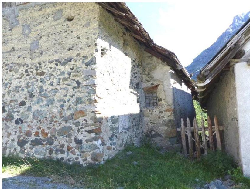
Figure 488 : La façade ouest, vue depuis le nord (la Chau, Cervières).
