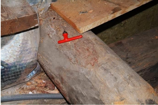
Figure 543 : Détail de la partie supérieure de la solive 05. Sous la clef rouge de la perceuse, l'écorce est conservée (le Pinet, Puy-St-Pierre).
