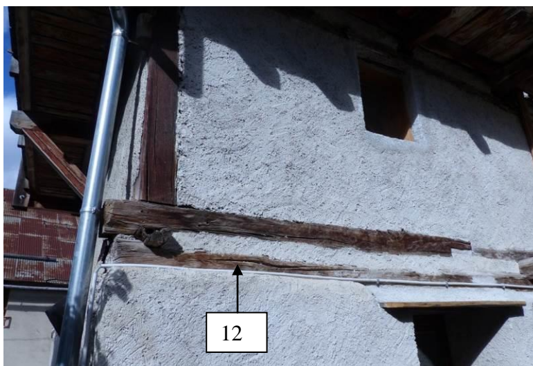
Figure 411 : Empilage entre le deuxième et le troisième niveau, façade sud de la maison nord (le Serre, Val-des-Prés).
