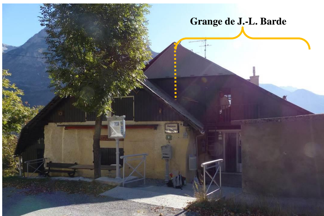
Figure 597 : Façade nord de la ferme, octobre 2013 (Favette, L'Argentière-La Bessée).
