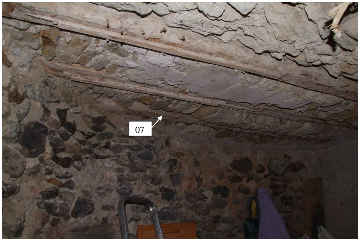
Figure 557 : Vue du deuxième niveau, vers le nord (Pont de Cervières, Briançon).
