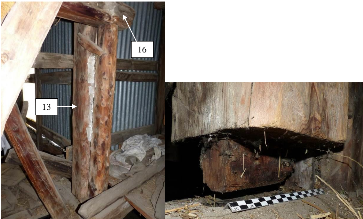
Figure 372 : Grange, N+3, vue vers le nord-est au niveau du poinçon (13) de la ferme centrale. Détail du tenon taillé à l'extrémité inférieure du poinçon (13) de la ferme centrale, suspendu au-dessus de sa mortaise : cela pose problème quant à la stabilité de la structure (Pra Premier, Val-des-Prés).
