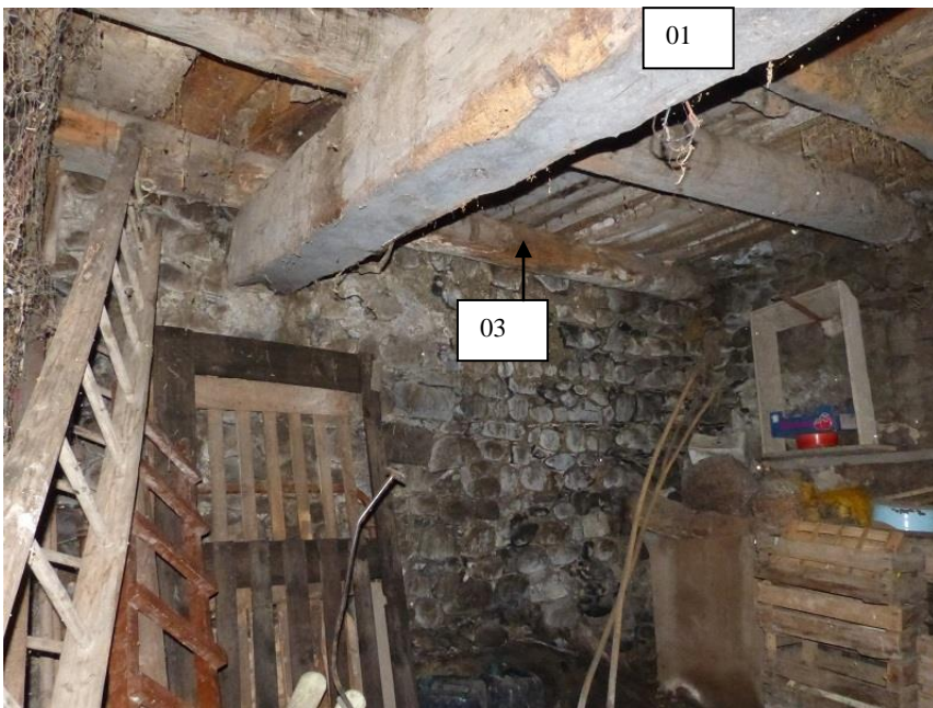
Figure 737 : Partie sud-est de la solive 03 qui repose sur l'extrémité nord de la poutre 01 (La Javie).
