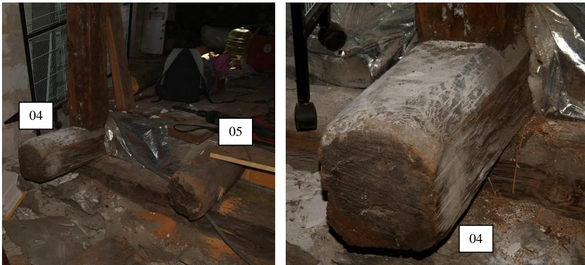
Figure 542 : Les solives 04 et 05 ont été échantillonnées. A droite, détail de la solive 04 (le Pinet, Puy-St-Pierre).
