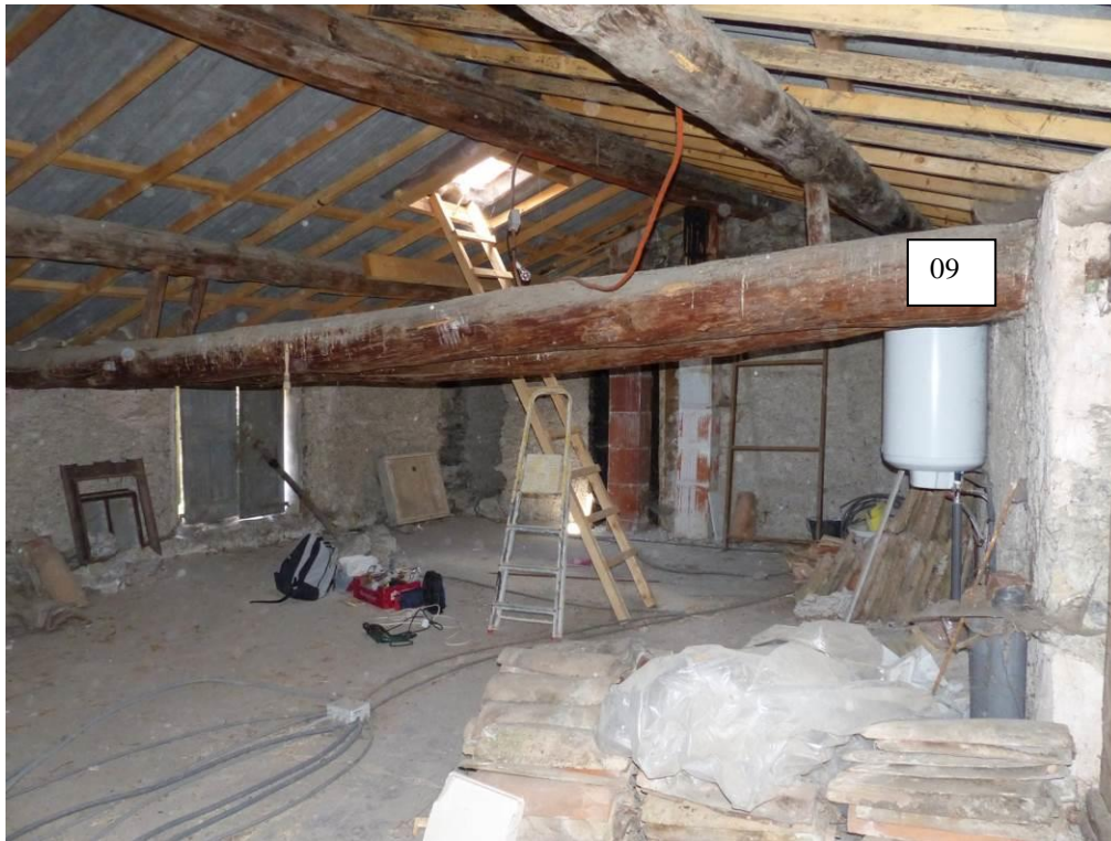
Figure 717 : Niveau 4, combles, pièce sud, vue vers le nord (le Moulin, La Javie).
