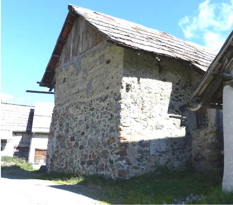
Figure 484 : Vue du bâtiment depuis le nord-ouest (la Chau, Cervières).
