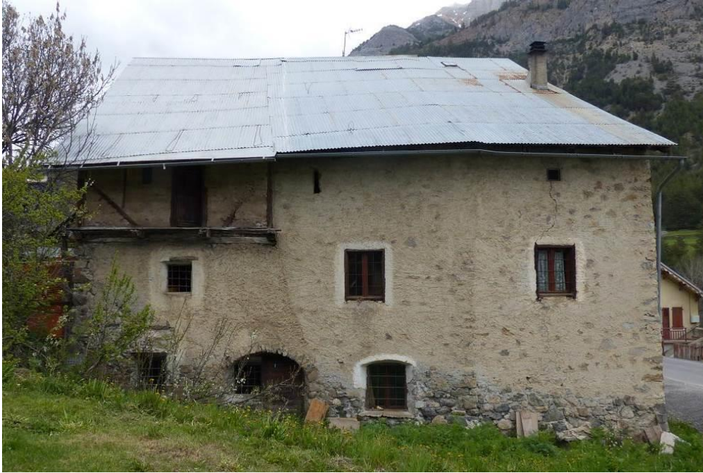
Figure 351 : Façade sud des fermes (Pra Premier, Val-des-Prés).
