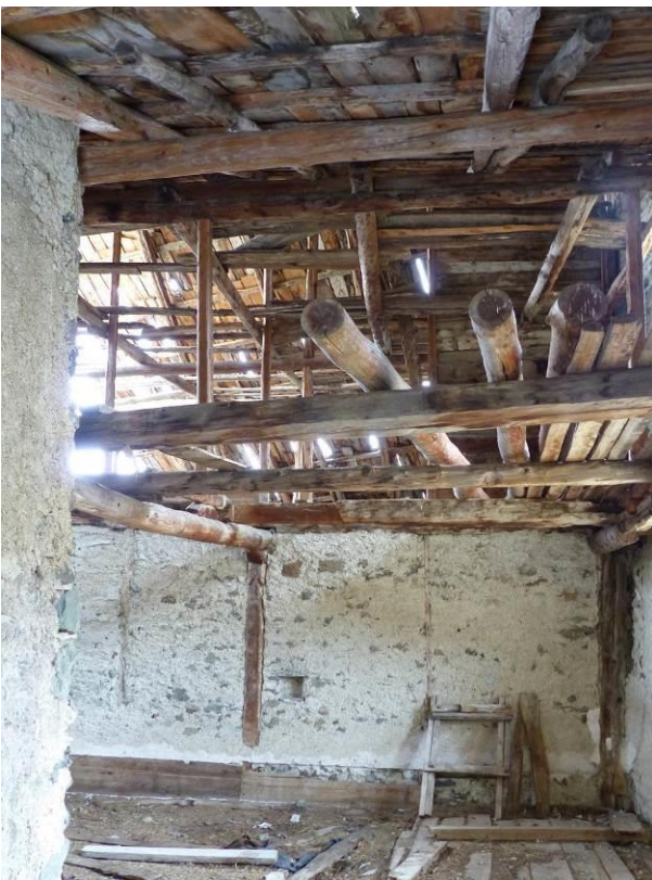
Figure 479 : Deuxième niveau, grange nord-est vue vers le sud-ouest. La charpente, toujours en place a ici permis la conservation des différents niveaux de la grange (les Fraches, Cervières).
