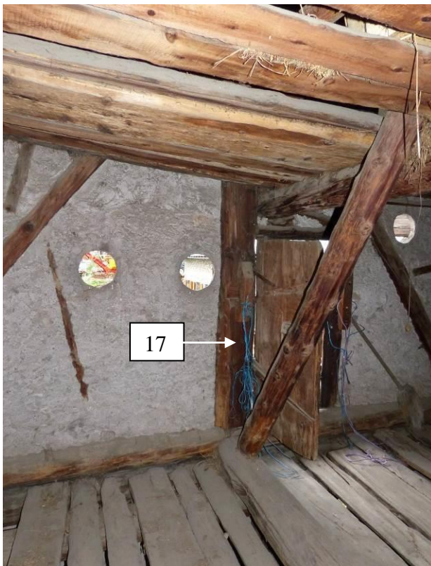
Figure 43 : N+3, pan de bois ouest, la porte donne accès au balcon ouest (le Serre, Val-des-Prés).
