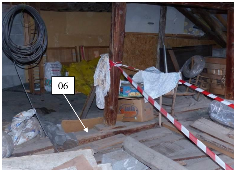
Figure 406 : Sablière de plancher, dans l'ancienne cloison en pan de bois du troisième niveau (le Serre, Val-des-Prés).
