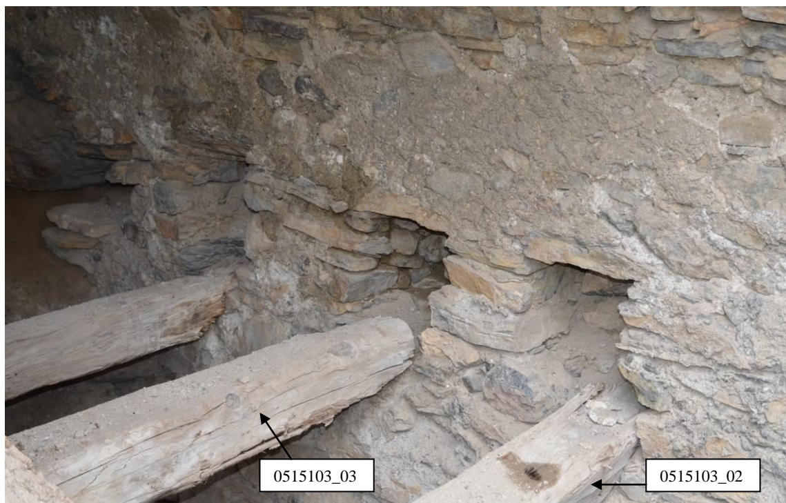
Figure 143 : Pressoir Bermont B04 (0515103). Détail des niches dans la maçonnerie où reposent les extrémités nord-est des solives (cliché V. Labbas).
