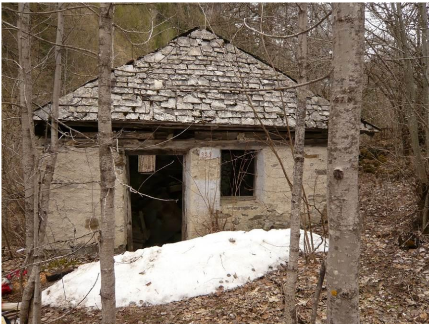
Figure 606 : Façade nord du moulin, couverture en ardoise (les Viollins, Freissinières).
