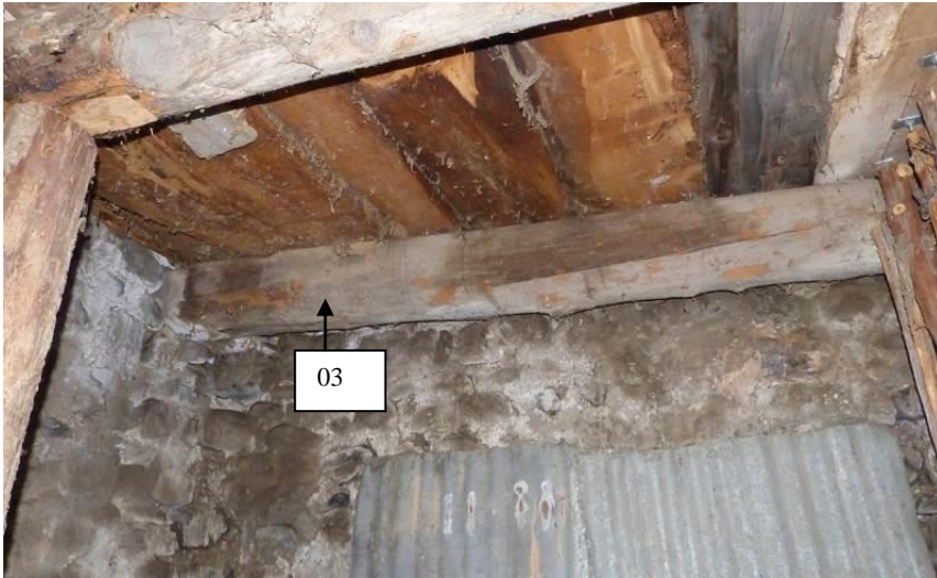
Figure 736 : Partie nord-ouest de la solive 03 (La Javie).
