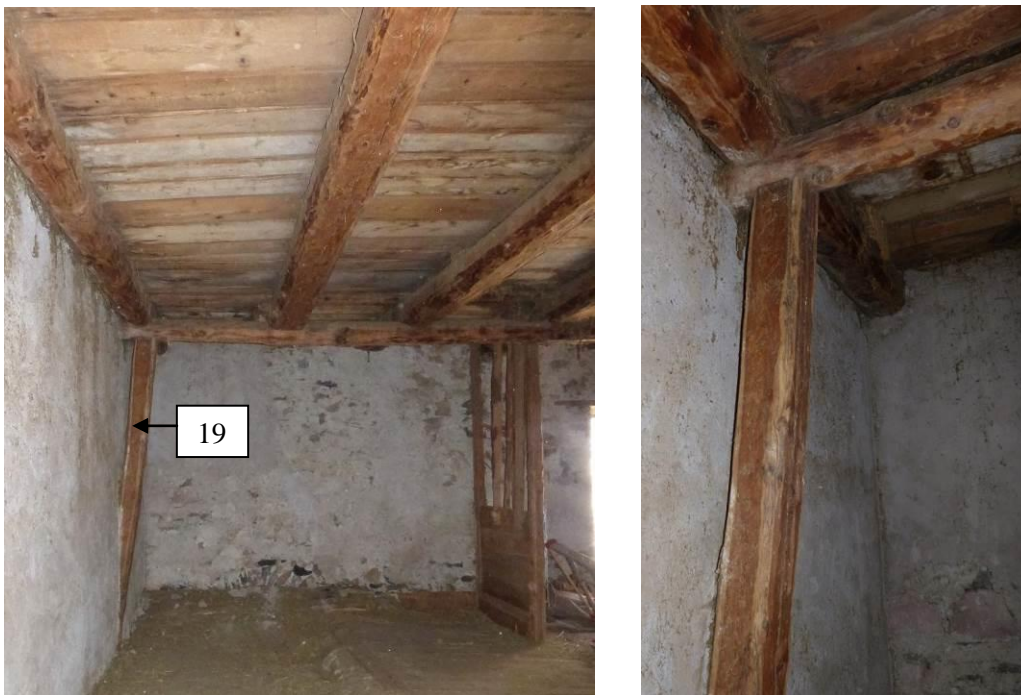
Figure 31 : N+1, aire de battage, vues vers le sud, ensemble et détail de la décharge 19 (le Serre, Val-des-Prés).
