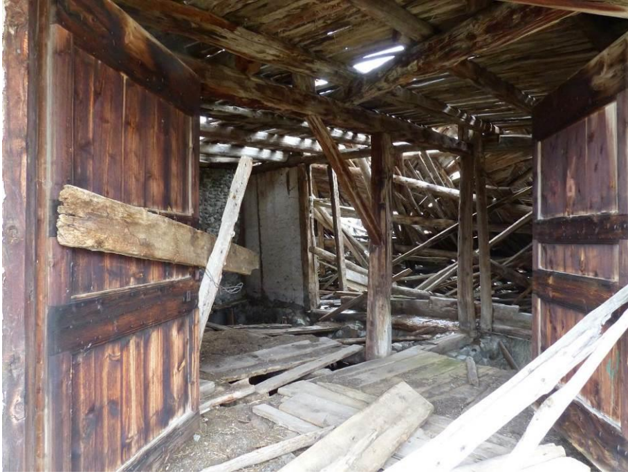
Figure 480 : Deuxième niveau, vue vers l'est. La porte à double battant donne accès à la grange sud-ouest, octobre 2013 (les Fraches, Cervières).
