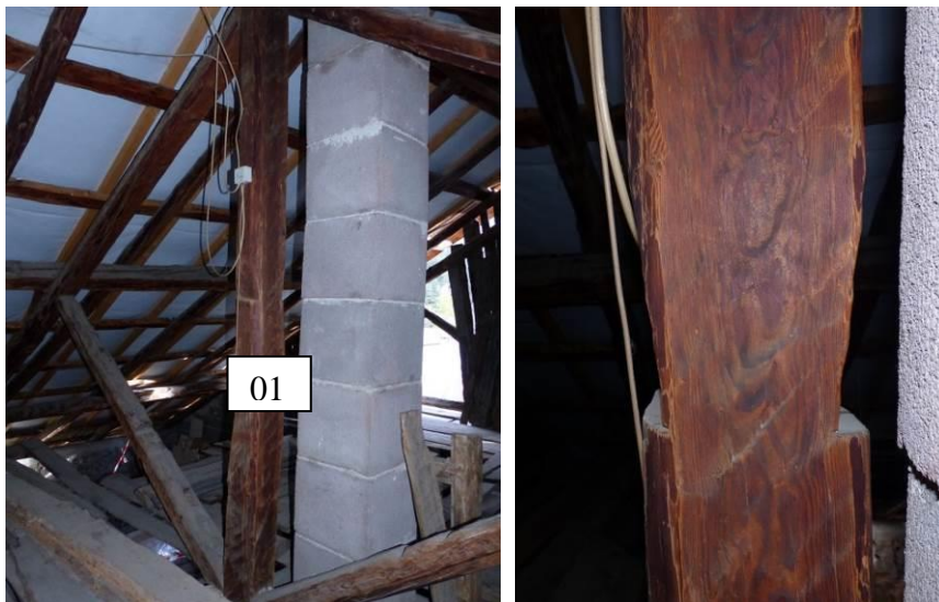
Figure 402 : Poinçon de la deuxième ferme en partant de l'est et détail de deux entailles (faces est et ouest) aujourd'hui non utilisées, où devaient autrefois s'appuyer des contrefiches (le Serre, Val-des-Prés).
