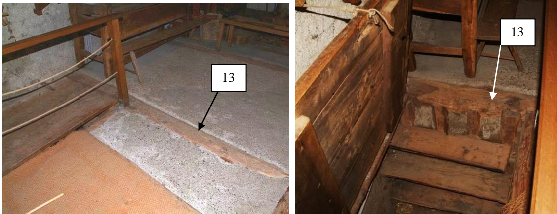
Figure 86 : Fenil, niveau 3, la poutre 13, prise dans le sol fait office de marche d'escalier (le chef-lieu, Cervières).
