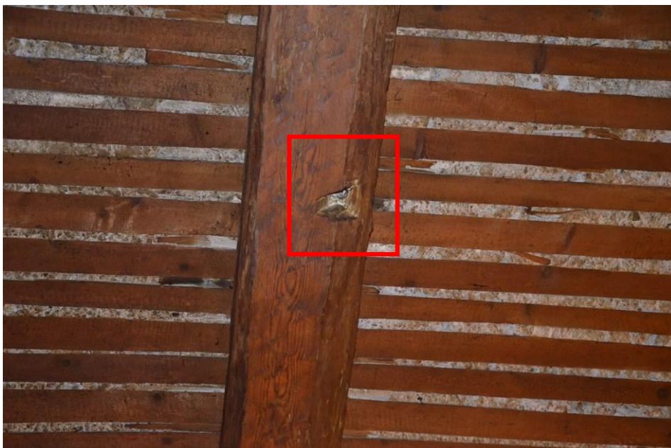
Une cavité pyramidale est creusée dans cette poutre équarrie (P. Hoffsummer, avril 2014).
