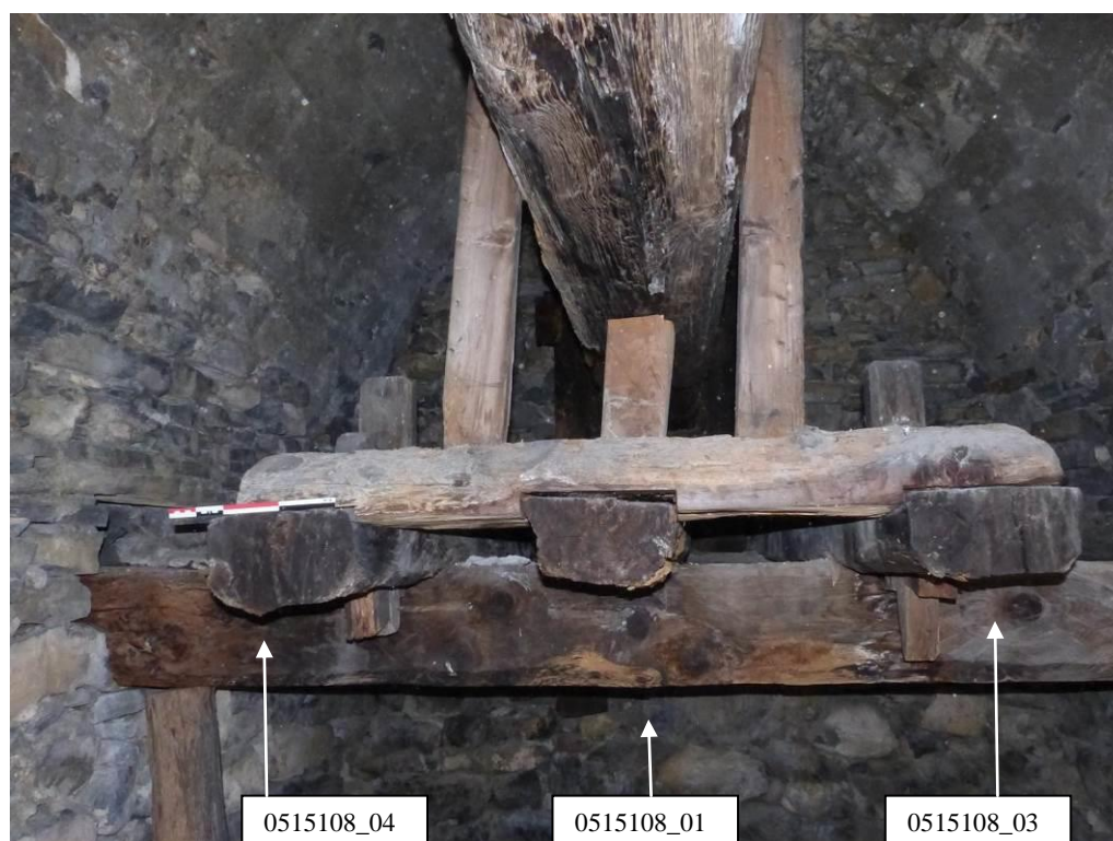
Figure 161 : Pressoir de l'Encombrouze (0515108). A gauche de la photographie, la poutre 0515108_04 (avec la mire de 30 cm).
