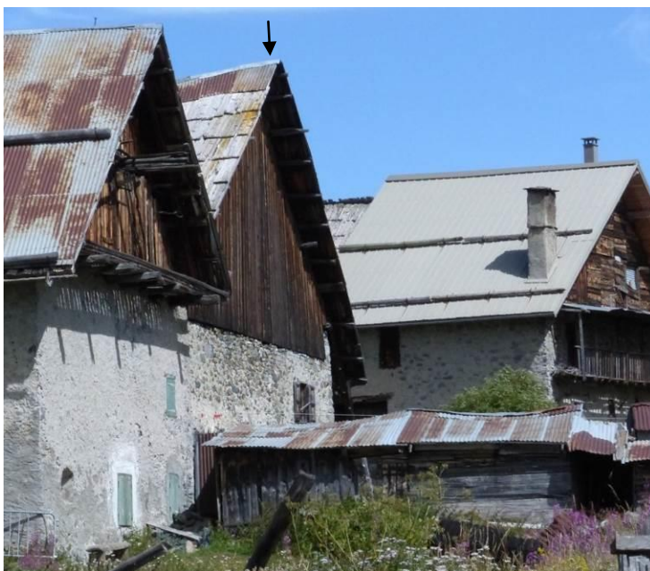
Figure 487 : Vue de la façade sud du bâtiment étudié, celui au deuxième plan (la Chau, Cervières).
