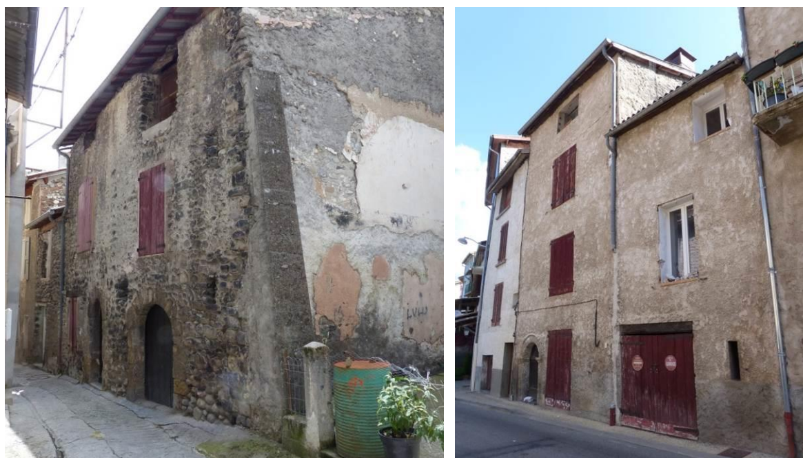
Figure 229 : Vues des façades nord-est côté ruelle (à gauche) et sud-ouest côté route de Prads (à droite). Sur cette dernière photographie, le bâtiment sud-est au premier plan, dont la toiture est à un niveau inférieur, se distingue du bâtiment nord-ouest (La Javie).
