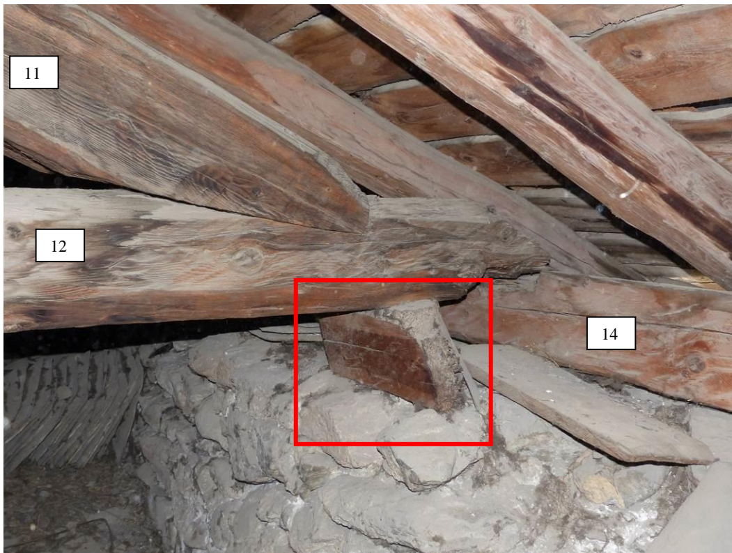
Figure 216 : Détail de l'extrémité sud de l'entrait de la ferme centrale. Il repose sur une calle de bois posée devant la panne sablière sud (église St-Laurent, La Roche-de-Rame).
