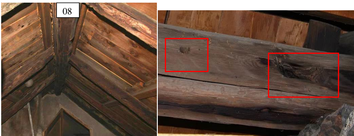
Figure 429 : Panne faîtière orientée nord-sud, dans les combles (niveau 4), vue depuis le sud. Dans les cadres rouges, un trou de cheville et une mortaise sont les témoins du remploi de cette pièce de bois (le Serre, Val-des-Prés).
