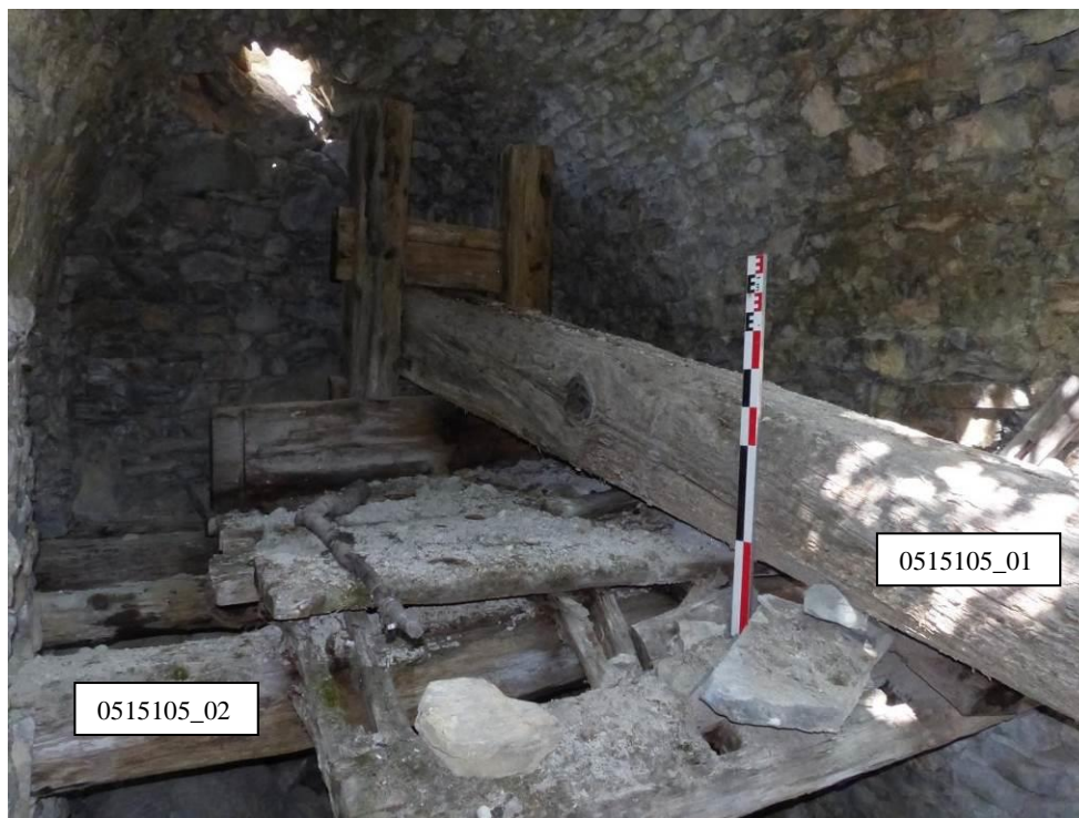
Figure 148 : Pressoir E08 (0515105). La partie ouest, sous la voûte est en assez bon état de conservation et seule la maie est endommagée.
