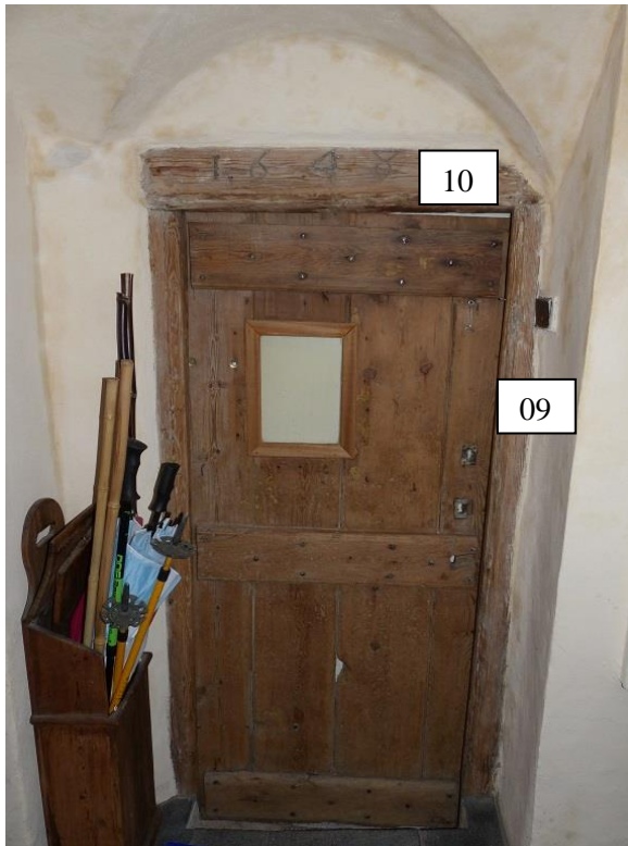
Figure 390 : Porte de la cave, au rez-de-chaussée (le Serre, Val-des-Prés).
