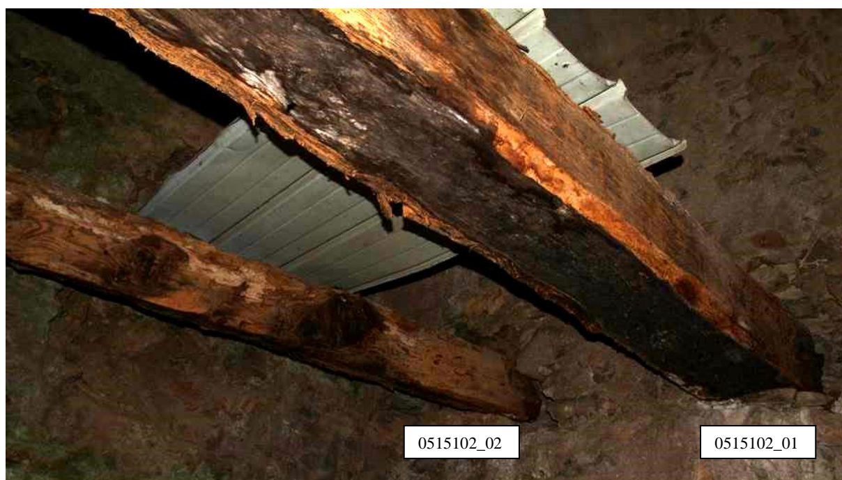
Figure 139: Pressoir Martin Courcier B02 (0515102), détail de l'équarrissage de la solive sud-est (0515102_01).
