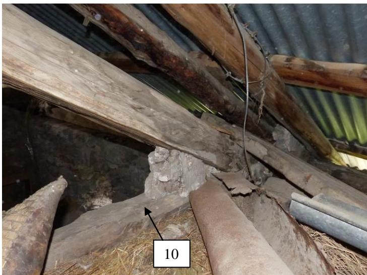
Figure 369 : Grange, N+3, extrémité sud de la ferme centrale. Un reste de mortier est visible entre l'arbalétrier et l'entrait (10), il s'agit peut-être d'un reste du comblement de l'ancien mur pignon est (Pra Premier, Val-des-Prés).
