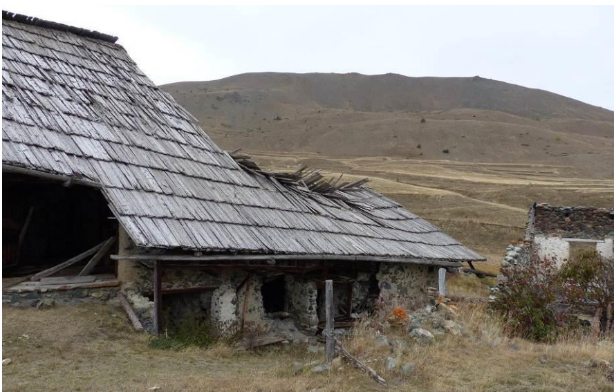
Figure 460 : Mur gouttereau sud-ouest, octobre 2013 (les Fraches, Cervières).
