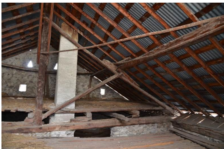
Figure 564 : Intérieur de la grange vue vers le nord-est (Prelles, St-Martin-de-Queyrières).
