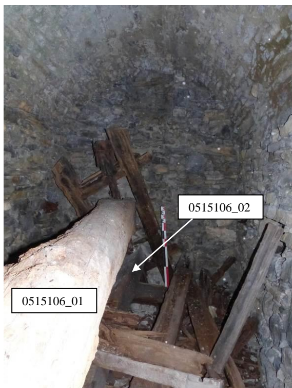
Figure 153 : Pressoir B08 (0515106), vue de la partie nord-est du cellier. La poutre 0515106_02, sous le levier, est orientée comme ce dernier.
