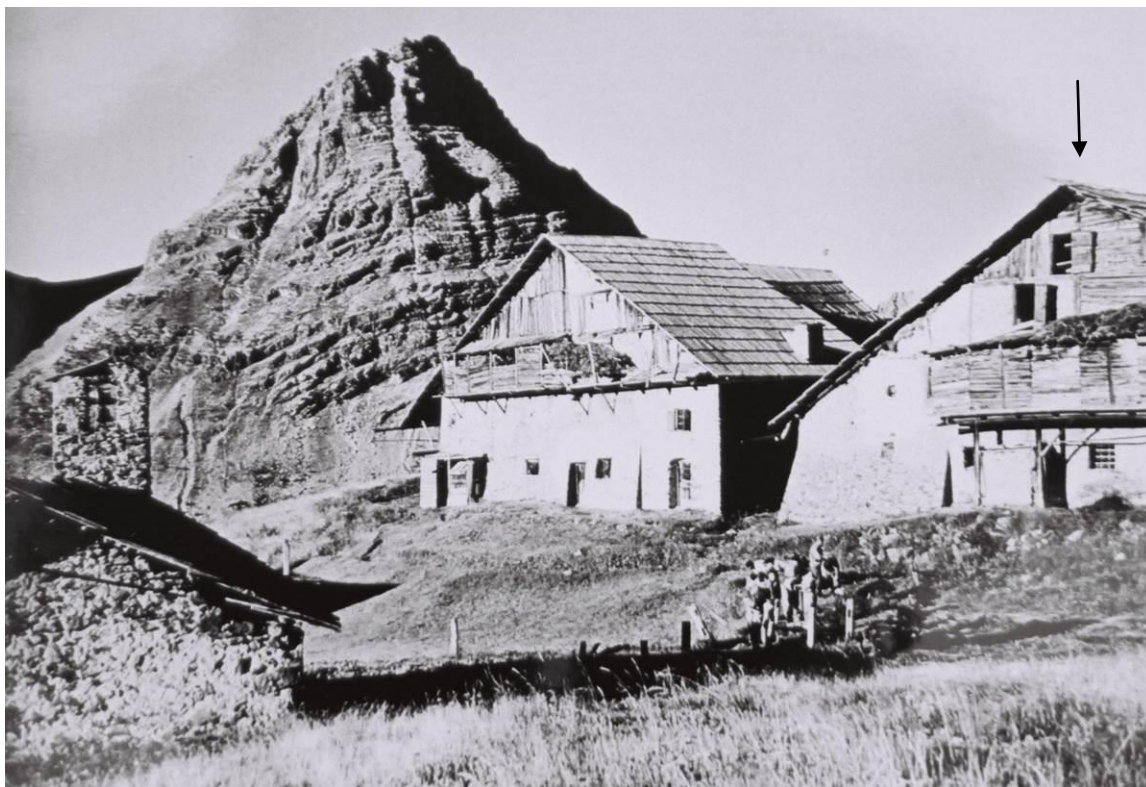
Figure 448 : Vue du hameau vers le sud -ouest. Au premier plan, à gauche, se trouve la chapelle. A droite, le mur pignon du bâtiment étudié, est actuellement en place et on y voit une resserre en planches (aujourd'hui disparue) construite en encorbellement au deuxième niveau (Photographie appartenant à Daniel Rey, Cervières, datant d'avant l'incendie des années 1930).
