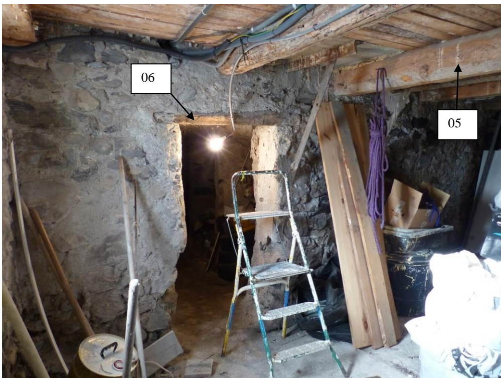
Figure 714 : Niveau 1 (caves), pièce centrale vue vers le nord-est (le Moulin, La Javie).
