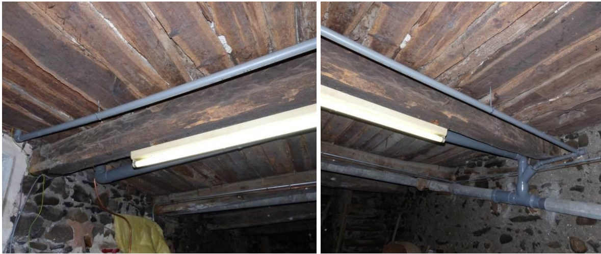
Figure 231 : Vues de la solive 01 depuis le sud-ouest (niveau inférieur du bâtiment sud-est) (La Javie).
