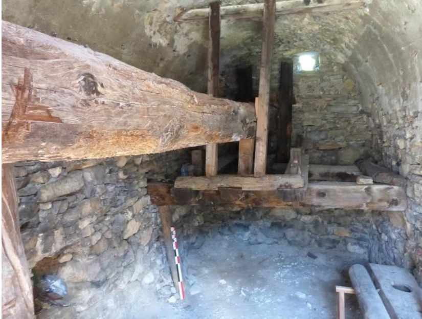
Figure 158 : Pressoir de l'Encombrouze (0515108), vue du pressoir depuis le sud.
