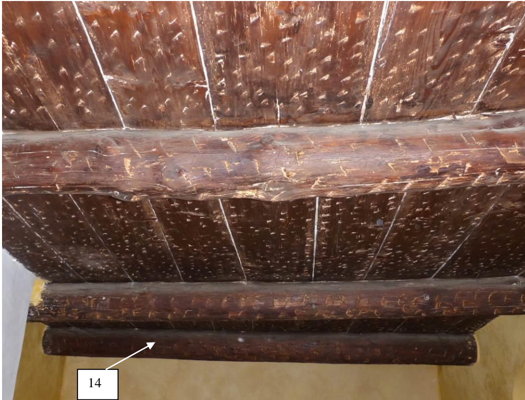
Figure 721 : Niveau 2, pièce centrale, vue vers l'est (le Moulin, La Javie).
