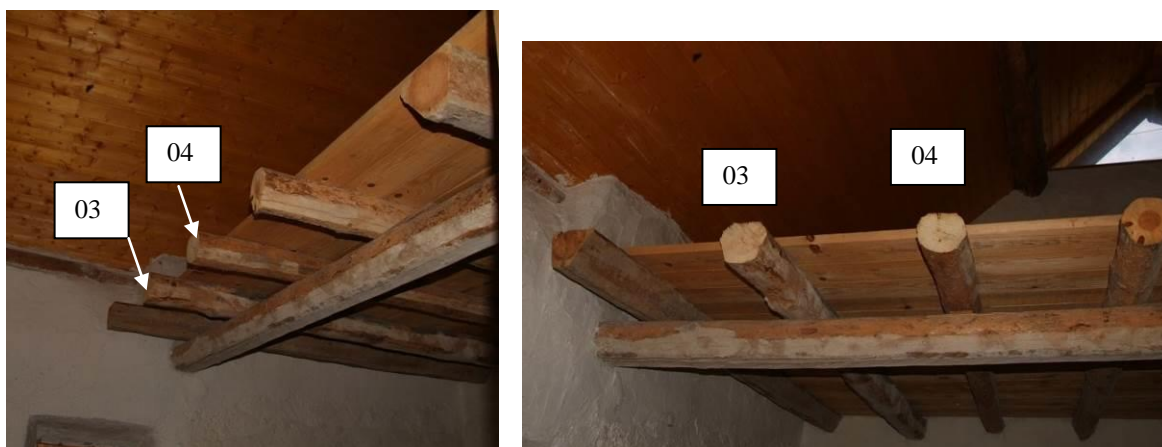
Figure 103 : Deuxième niveau de la partie ouest du bâtiment, deux solives soutenant la mezzanine nord ont été échantillonnées (la Maison Crénelée, Briançon).
