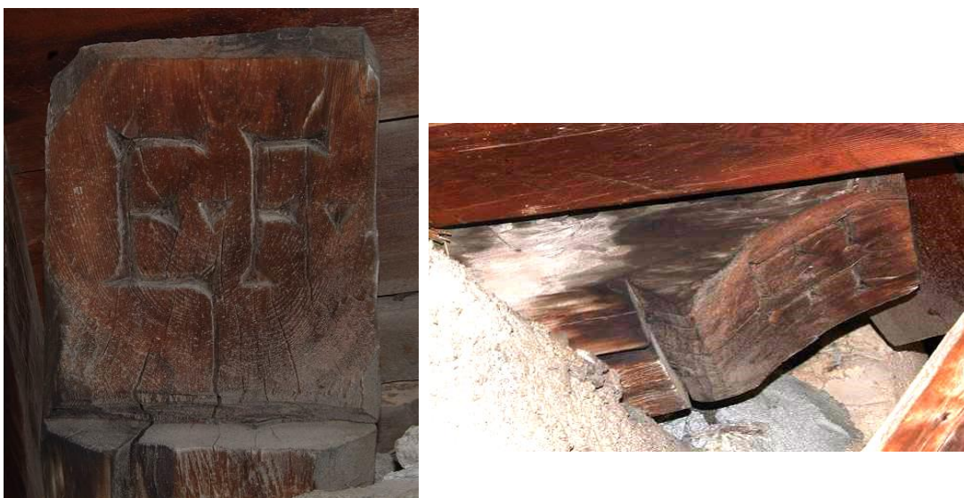
Figure 78 : Grange, niveau 4. Vues de l'extrémité sud de la panne sablière orientale 07 et de l'inscription gravée « E.F. » (le chef-lieu, Cervières).
