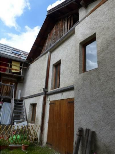
Figure 400 : Façade ouest de la maison sud. La partie supérieure de ce mur pignon est fermée par des planches, tout comme le mur pignon oriental (le Serre, Val-des-Prés).
