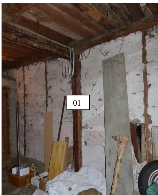
Figure 355 : Aire de battage, N+1, pan de bois ouest (Pra Premier, Val-des-Prés).
