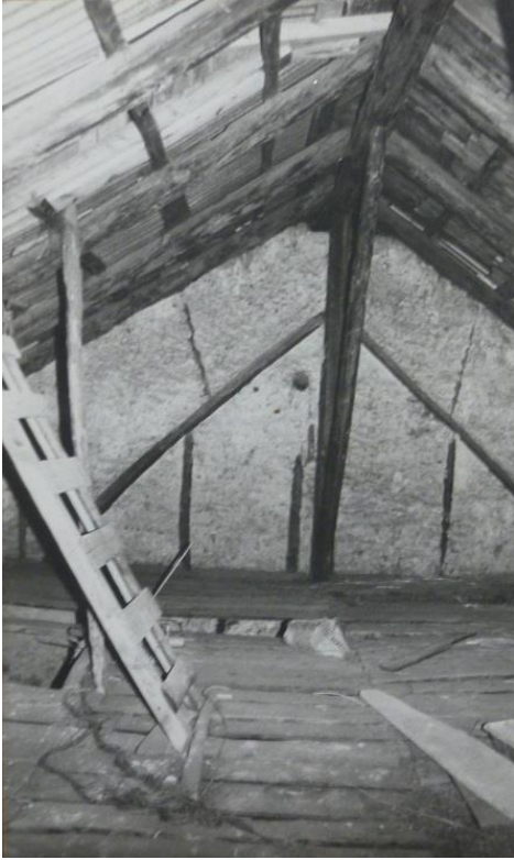
Figure 384 : Vue des combles avant les travaux (photographie de M. et Mme Wion) (le Serre, Val-des-Prés).
