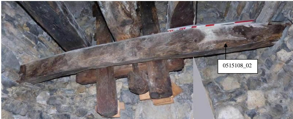
Figure 162 : Pressoir de l'Encombrouze (0515108), partie nord du pressoir. Sous la mire de 1 m, la solive 0515108_02. Les extrémités nord des trois poutres reposent sur cette solive et les parties inférieures des jumelles sont visibles en-dessous.
