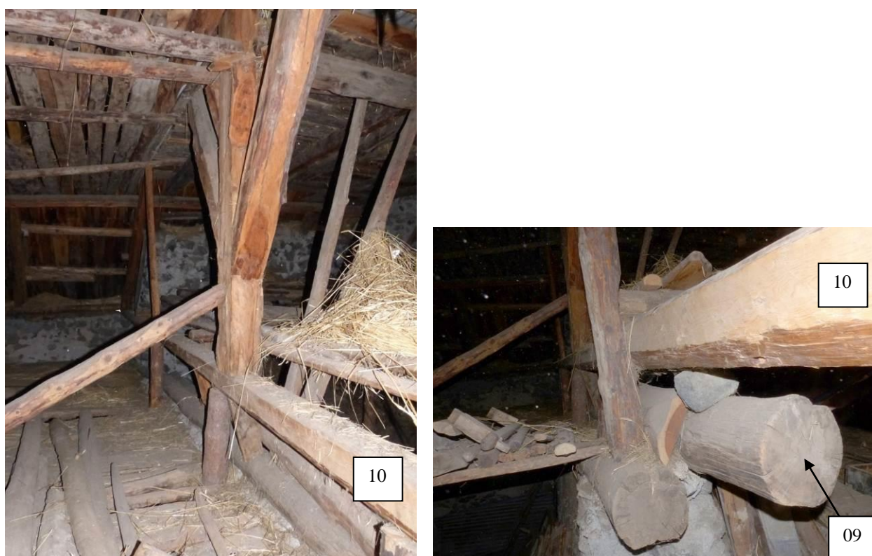
Figure 499 : Partie nord du deuxième niveau de la grange. A gauche, détail de la ferme nord dont l'entrait a été carotté (10), à droite, détail des pièces de bois situées au-dessus de l'ancien mur pignon nord (vue vers l'ouest) (la Chau, Cervières).
