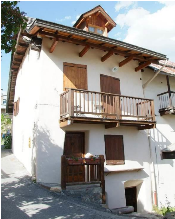
Figure 535 : Façade sud, juin 2013 (le Pinet, Puy-St-Pierre).
