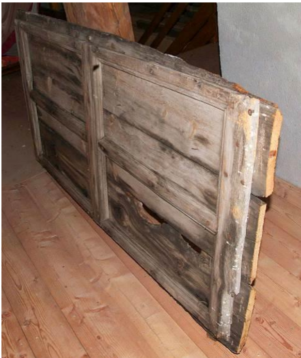
Figure 586 : Petite porte sud de la grange, déposée. Les séries de cernes des trois planches verticales ont été mesurées d'après photographies, après ponçage (Pina-36 à 38) (La Bâtie, Les Vigneaux).
