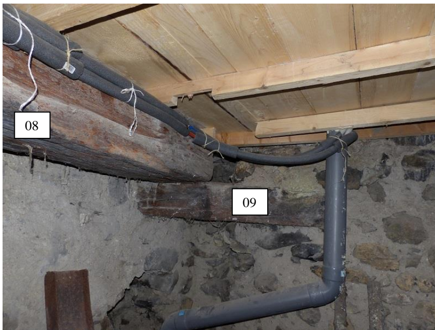
Figure 676 : Vue de la partie nord-est de la cave située à l'arrière du deuxième niveau (côté sud-est). La poutre 08 repose sur la poutre 09 (Chanolles, Prads-Haute-Bléone).
