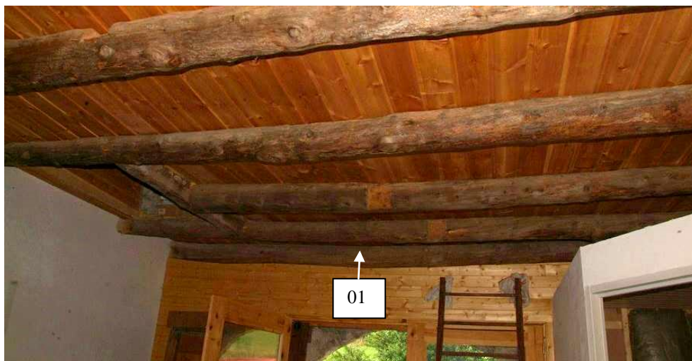
Figure 101 : Pièce à vivre du deuxième niveau vue vers le nord. La solive 01 se trouve à l'entrée (la Maison Crénelée, Briançon).
