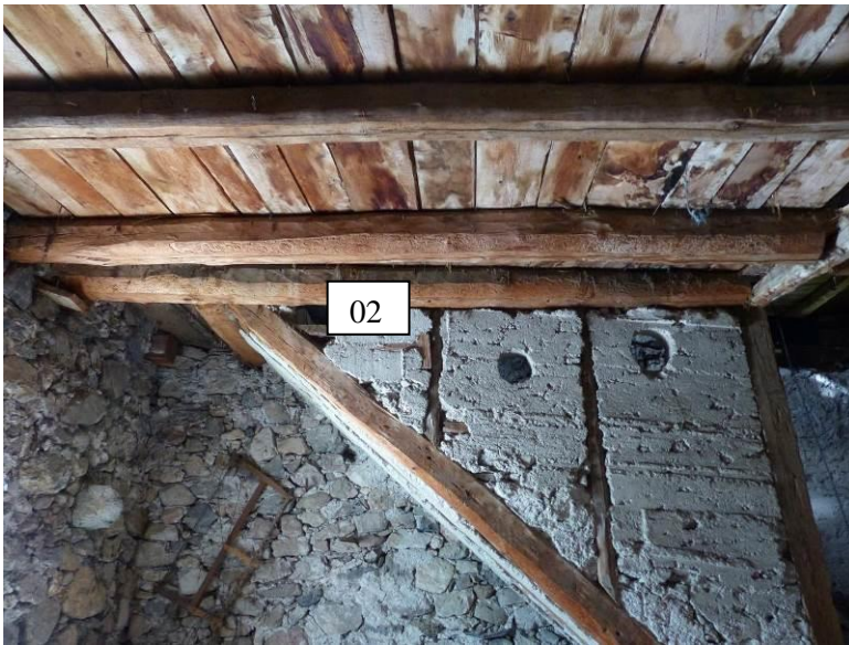
Figure 356 : Grange, N+1, partie est, pan de bois au sud fermant l'escalier menant à N+2 (Pra Premier, Val-des-Prés).
