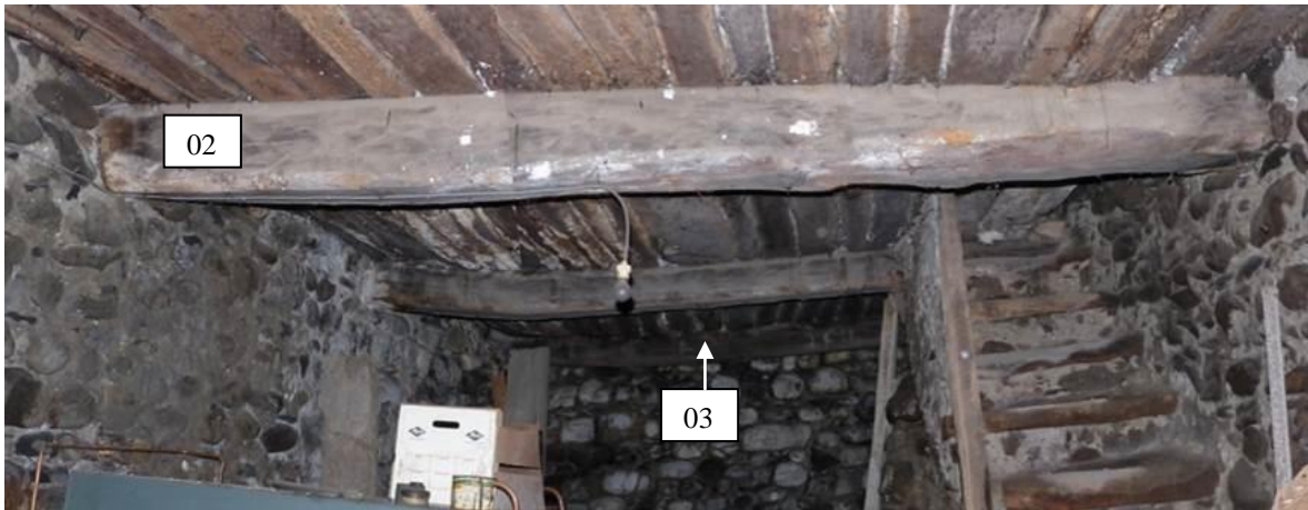
Figure 232: Vue des solives 02 et 03 depuis le sud-ouest (niveau inférieur du bâtiment sud-est) (La Javie).
