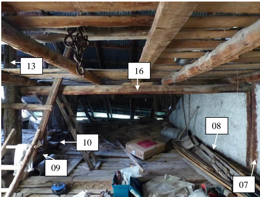
Figure 364 : Grange, N+3, vue vers le sud de la partie ouest (Pra Premier, Val-des-Prés).
