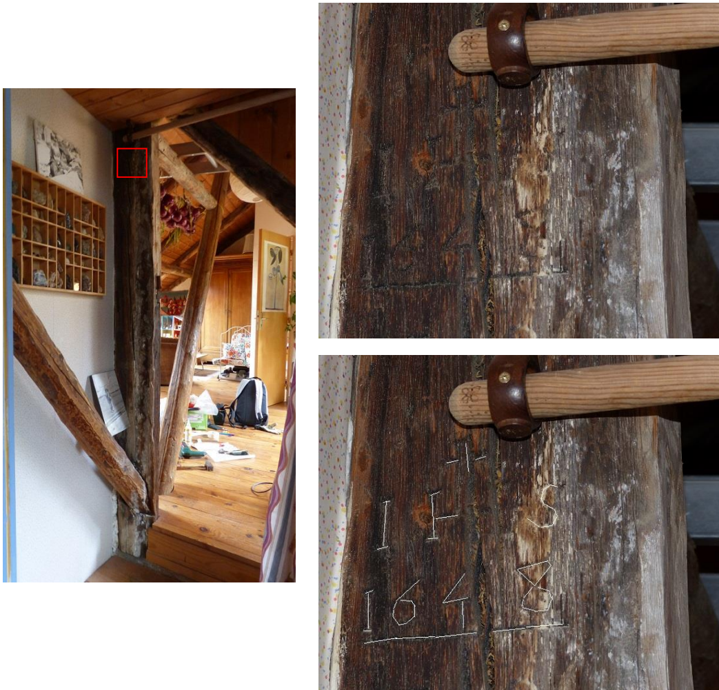
Figure 386 : Poinçon de la ferme sud de la charpente des combles, portant sur sa face sud (dans le carré rouge) l'inscription « IHS / 1648 », peut-être précédée d'une croix (le Serre, Val-des-Prés).
