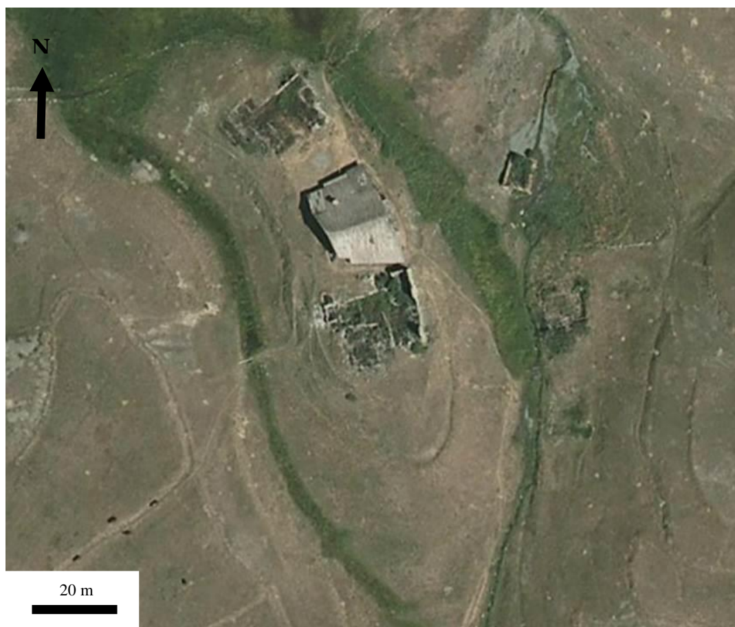
Figure 450 : Vue aérienne des Fraches en 2009 (L. Shindo, d'après Geoportail.fr) : la toiture du bâtiment étudié est encore en place à cette époque. Au nord et au sud de celui-ci, on distingue aisément les soubassements de deux fermes. Ces trois bâtiments sont construits sur une butte qui les isole des ruisseaux. De l'autre côté du torrent, au nord, on voit les quatre murs de la chapelle. Les deux bâtiments au sud de la chapelle se devinent grâce à la couleur de la végétation.
