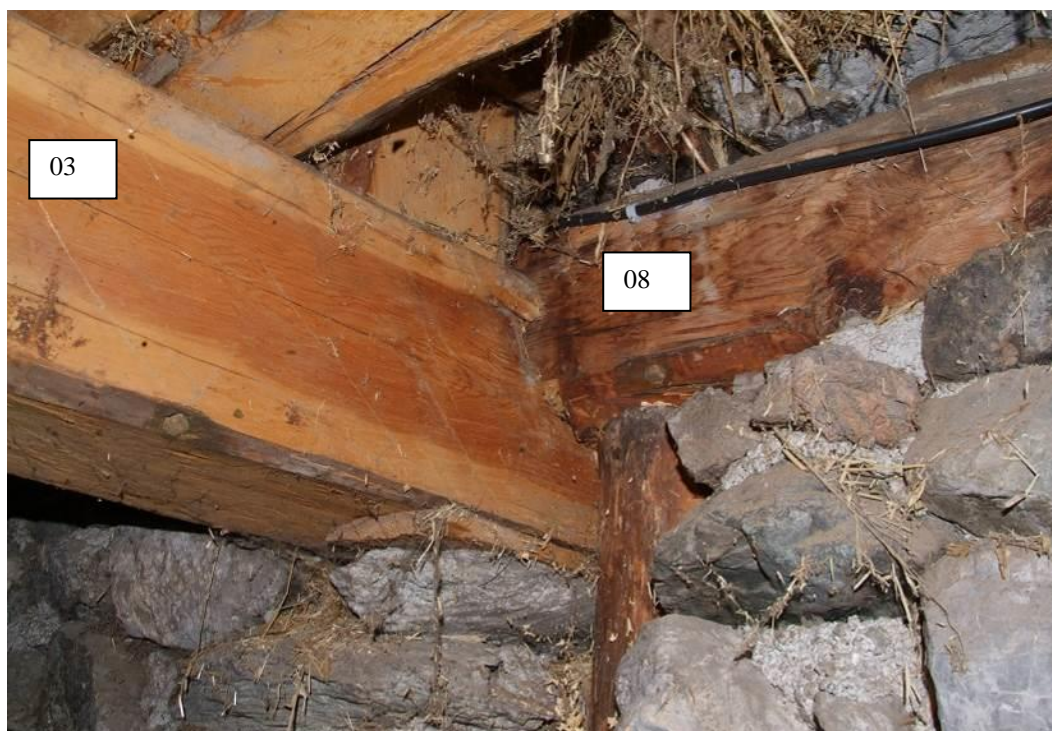
Figure 80 : Grange, niveau 4. Détail de l'assemblage entre la poutre 03 (à gauche) et la panne sablière ouest 08 à droite (le chef-lieu, Cervières).
