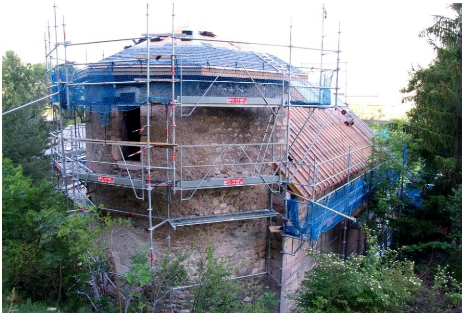
Figure 655 : Vue de la chapelle depuis le nord-est, le 17 Juin 2013 (Mont-Dauphin).
