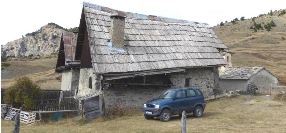
Figure 486 : Deux vues du bâtiment étudié, depuis le nord-est et sud-est. Sur la photographie inférieure, la chapelle Ste-Elisabeth est visible à droite (au nord) (la Chau, Cervières).
