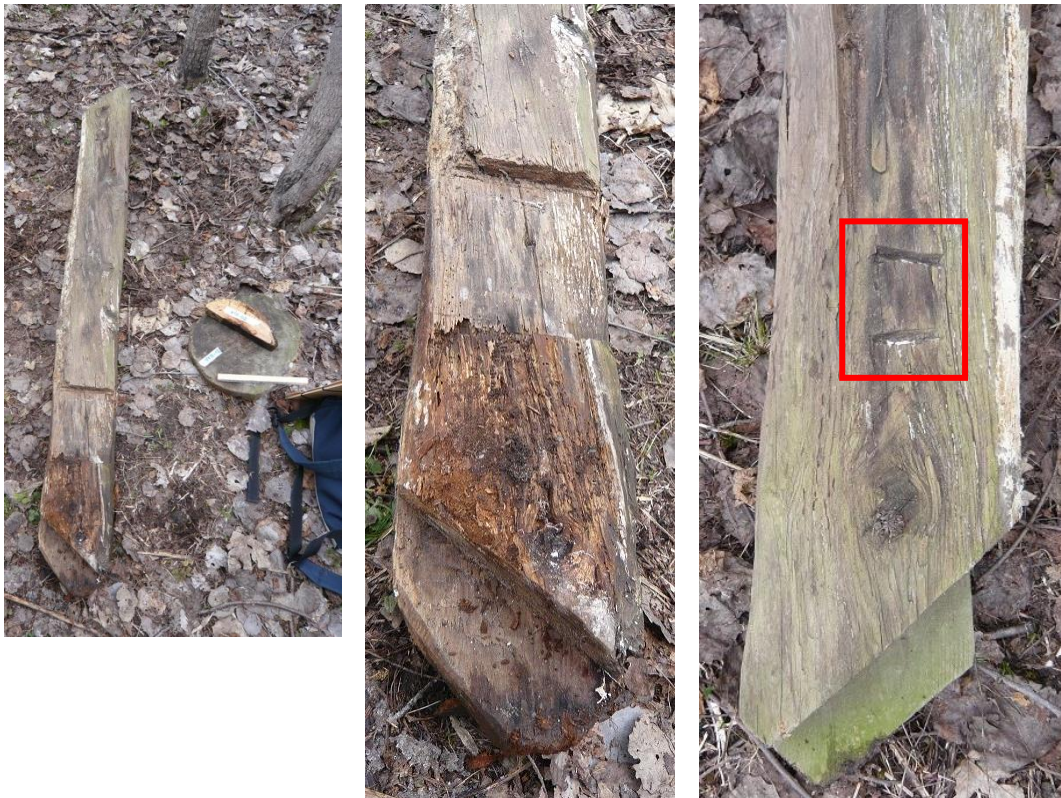
Figure 616 : Pièce de bois VIOL03 (contrefiche de la ferme centrale). La photographie centrale est un agrandissement de celle de gauche. La face opposée de cette pièce est visible sur la photographie de droite : deux encoches y sont gravées, les mêmes que sur les éléments en place de la ferme centrale (les Viollins, Freissinières).
