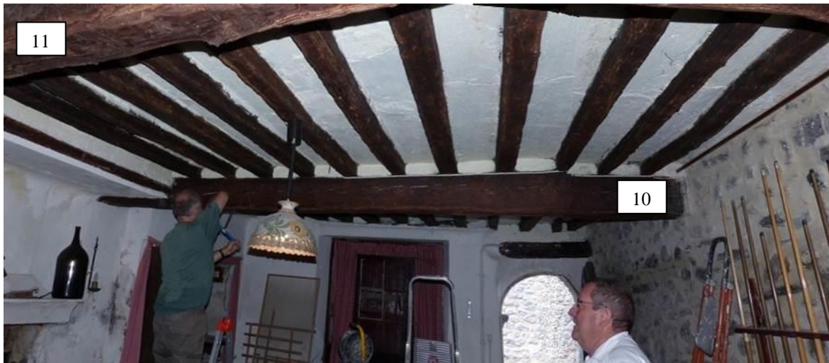
Figure 238 : Les poutres 10 et 11 sont situées dans la pièce du rez-de-chaussée donnant sur la route de Prads (La Javie).
