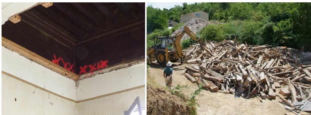
Figure 252 : Certaines pièces de bois ont été marquées à la bombe de chantier (ici, plafond nord-ouest du premier étage) puis, pendant la déconstruction, certains éléments en bois ont été entreposés sur une aire de stockage, un terrain municipal à l'extérieur du centre-ville.
