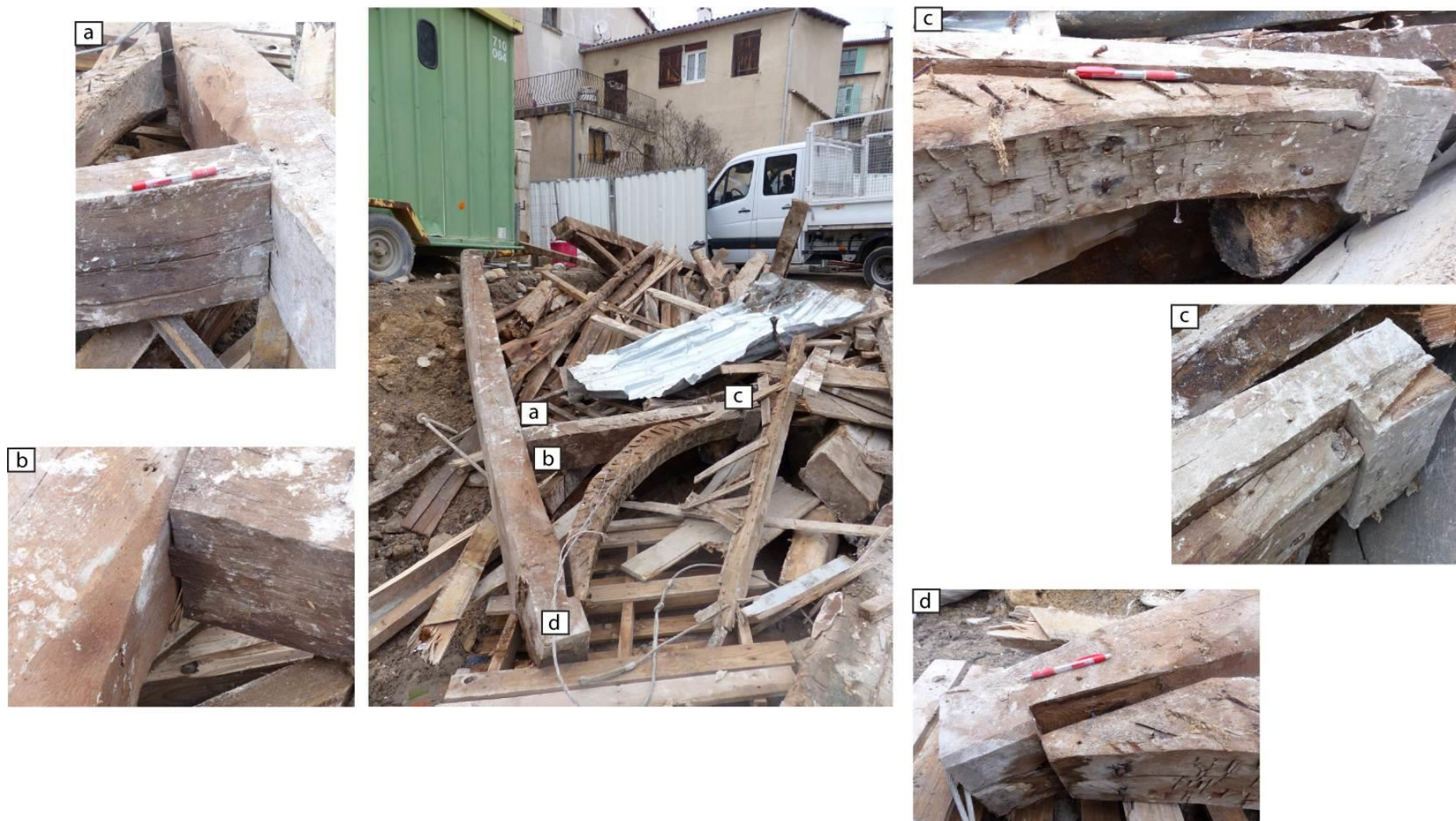
Figure 274 : Détails des assemblages d'une des potences qui soutenait certainement la façade en encorbellement de l'hôtel Ferrier. La solive (0416601_571) en pin sylvestre, le poteau porteur (0416601_572) en chêne et la jambe de force (0416601_573) également en chêne, ont été échantillonnés.
