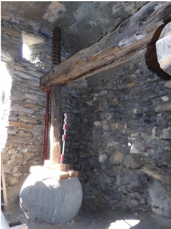
Figure 159 : Pressoir de l'Encombrouze (0515108), la vis et le contrepoids, partie sud du pressoir.
