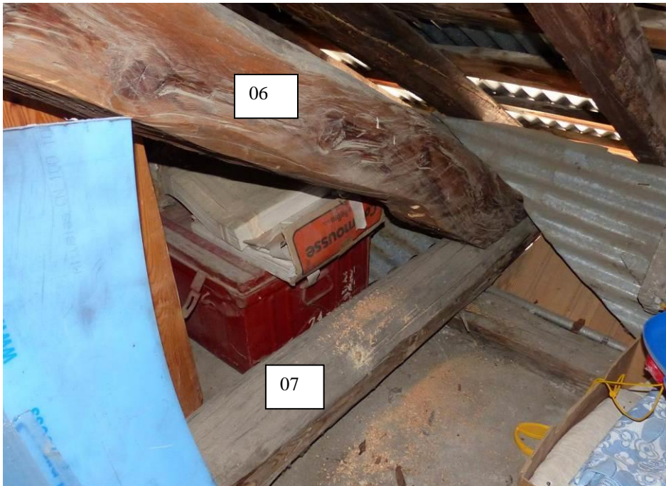
Figure 601 : Détail de la ferme nord, au niveau inférieur de la grange. L'arbalétrier (06) et le tirant (07) ont été échantillonnés (Favette, L'Argentière-La Bessée).
