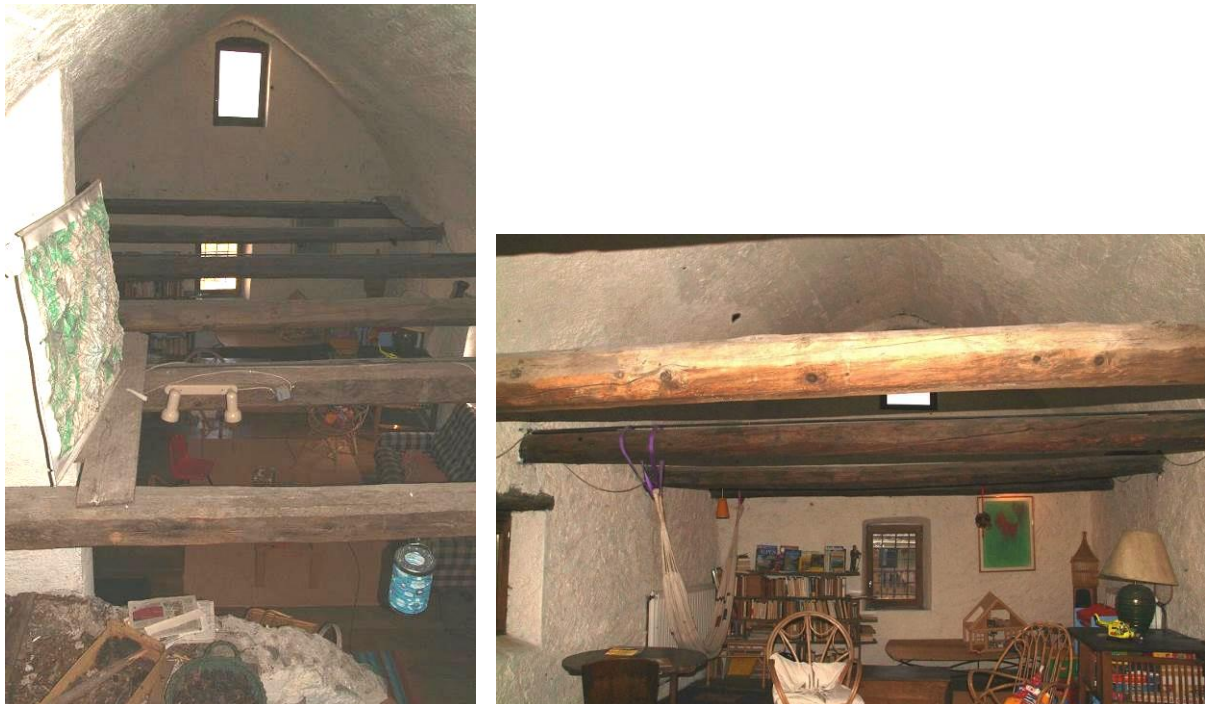
Figure 420 : Vue d'ensemble du grenier depuis le sud. Seules subsistent les solives de plancher (le Serre, Val-des-Prés).
