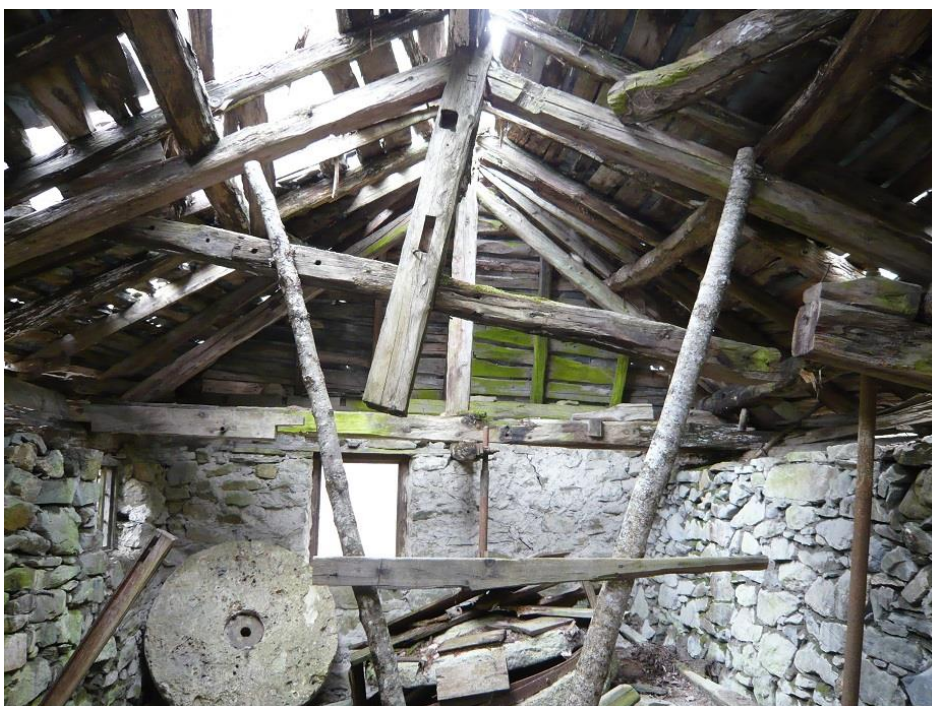
Figure 614 : Vue depuis le nord du deuxième niveau du moulin (les Violins, Freissinières).
