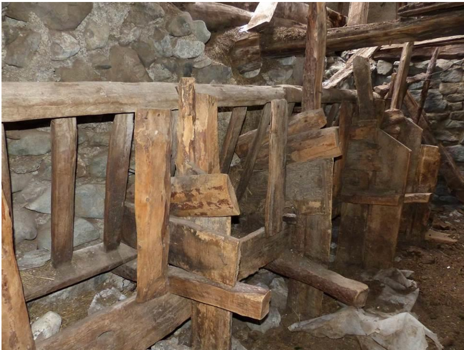
Figure 477 : Détail des mangeoires et des stalles de l'écurie sud-ouest, octobre 2013 (les Fraches, Cervières).
