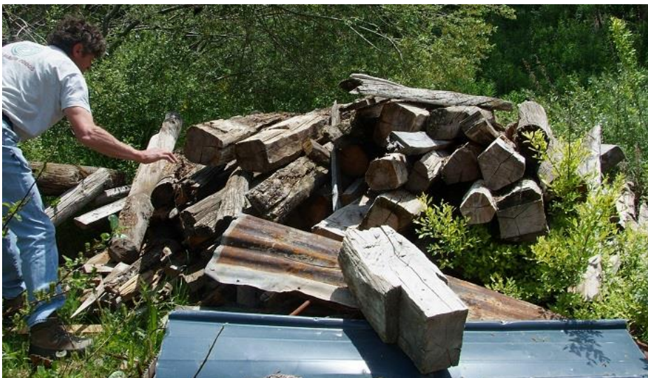
Figure 513 : Des pièces de bois de l'ancien balcon nord ont été déposées puis stockées derrière l'église Saint-Michel-et-Saint-Mammès de Cervières.
