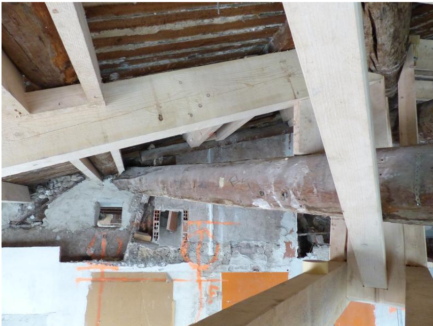
Vue d'ensemble de la poutre avec la marque.
