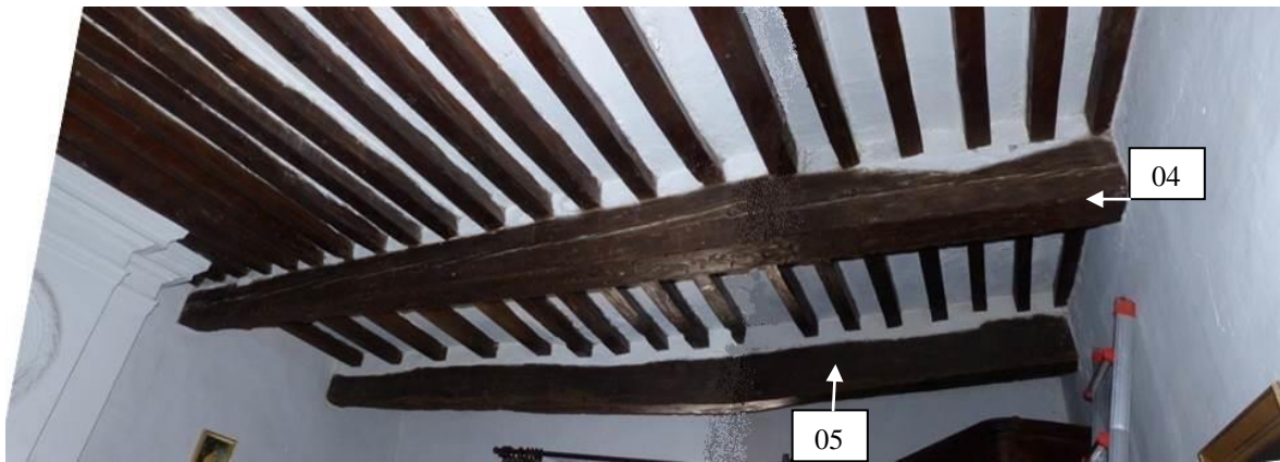
Figure 233: Les poutres 04 et 05 sont au deuxième étage du bâtiment nord-ouest (vue depuis le nord-est) (La Javie).
