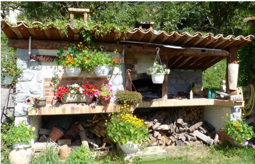
Figure 664 : L'arbre de transmission du moulin est réemployé comme élément de charpente de la toiture de l'abri de jardin. Vue depuis le sud (Chavailles, Prads-Haute-Bléone).
