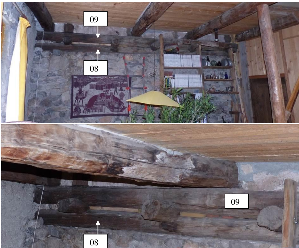
Figure 408 : Vue d'ensemble depuis le sud et détail de l'empilage nord du deuxième niveau dans le salon actuel (le Serre, Val-des-Prés).
