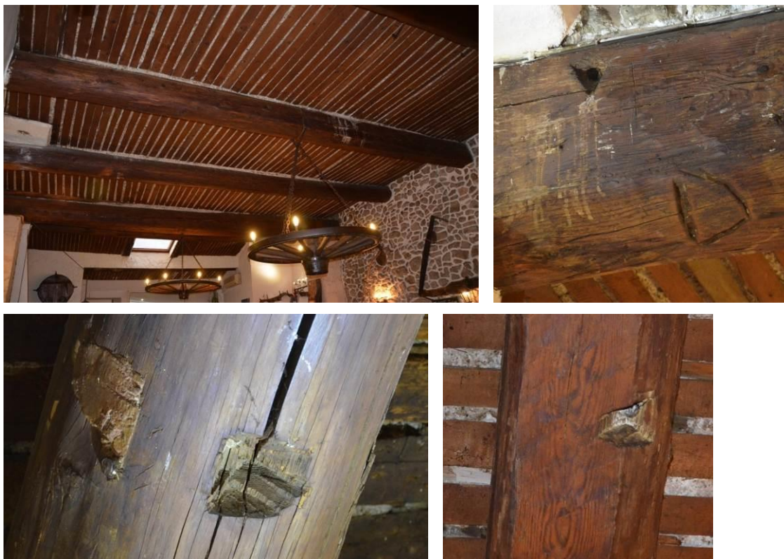
Figure 13 : Le restaurant La Brocherie (5 rue Fernand Dol, Aix-en-Provence) est un ancien relais de poste, sans doute construit au XVII e siècle. Plusieurs solives du plafond conservent des marques des systèmes de fixation liés à leur transport, certainement par flottage. Si c'est bien le cas, ils se composaient de coins et de liens végétaux (photographies P. Hoffsummer, avril 2014).
