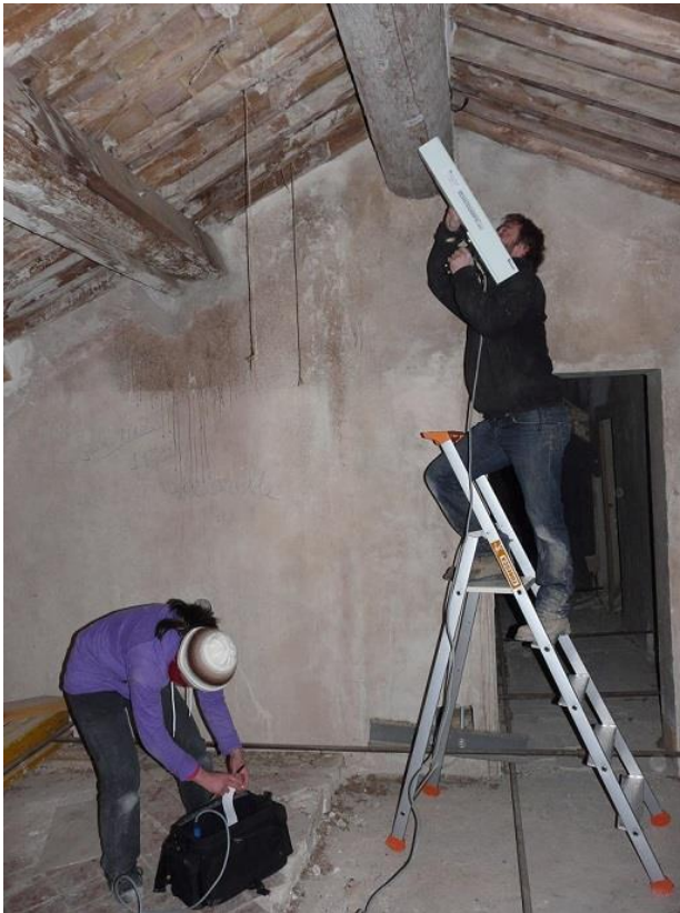
Figure 15 : V. Labbas réalise le sondage d'une panne faîtière et L. Shindo examine le profil de résistance au niveau du module de stockage, domaine du Grand-St-Jean, Aix-en-Provence (photographie J.-L. Edouard, 10/02/2015).
