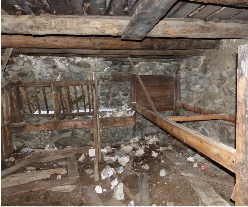
Figure 474 : Ecurie sud, vue vers le nord-ouest. Le mobilier de cette pièce (mangeoires, stalles et lit) est toujours en place, octobre 2013 (les Fraches, Cervières).
