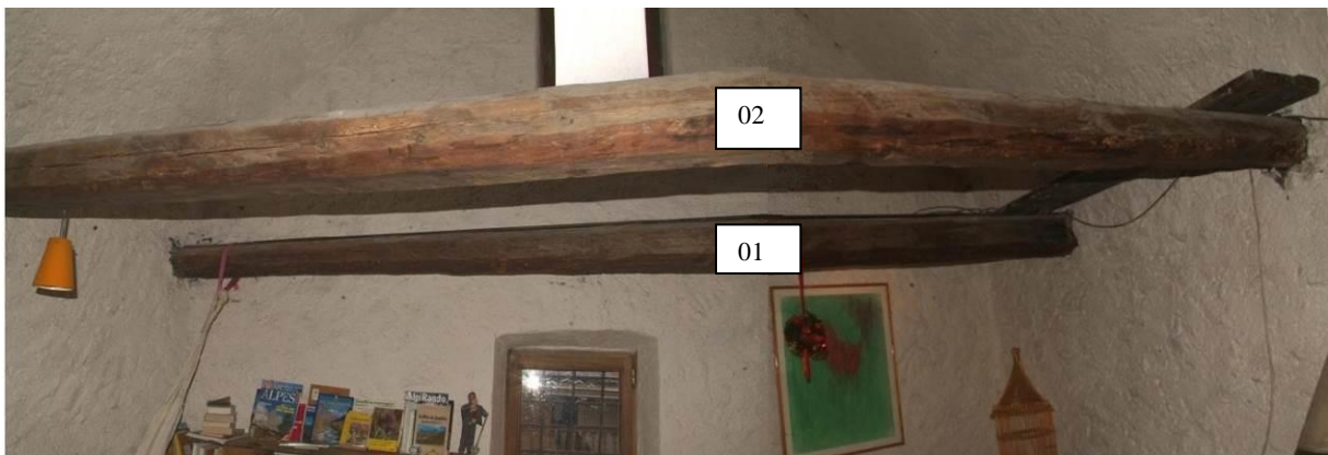
Figure 424 : Poutres transversales 01 et 02, vue depuis le sud (niveau 3) (le Serre, Val-des-Prés).
