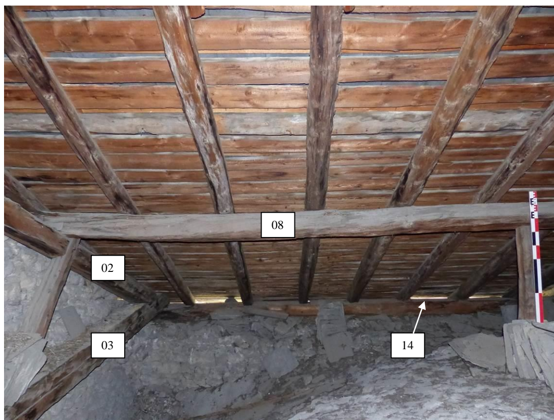
Figure 201 : La panne intermédiaire sud-est (08) est soutenue par une cale verticale (église St-Laurent, La Roche-de-Rame).
