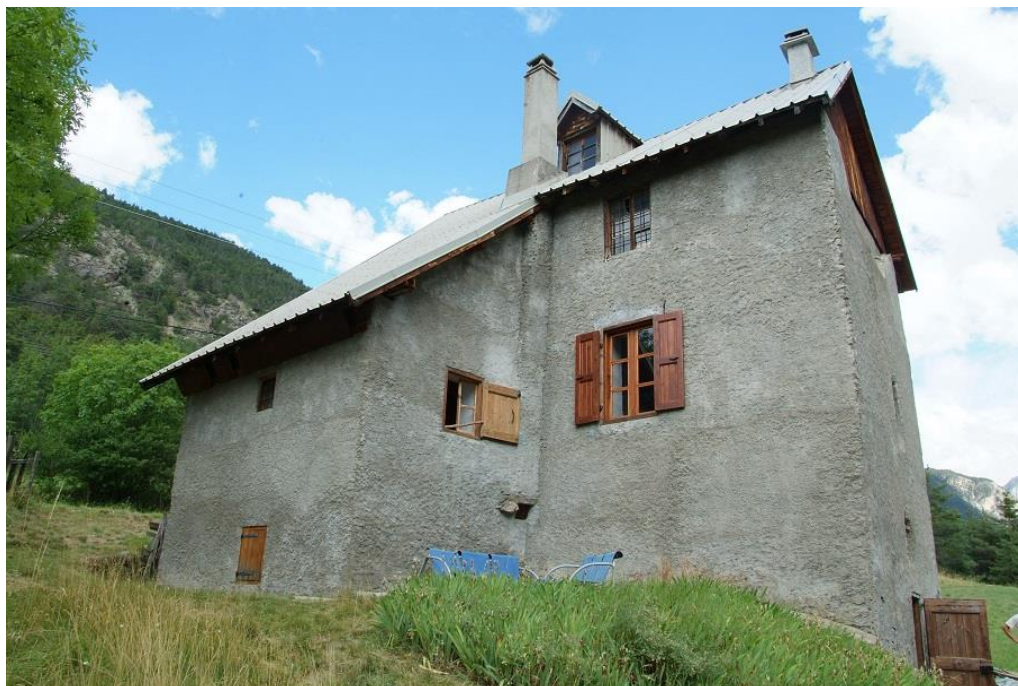
Figure 99: Vue du bâtiment depuis le sud-ouest (la Maison Crénelée, Briançon).
