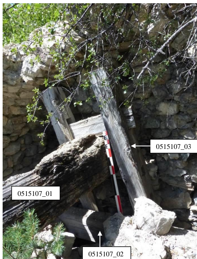
Figure 156 : Pressoir B09 (0515107), détails du levier, des jumelles et de la solive nord.
