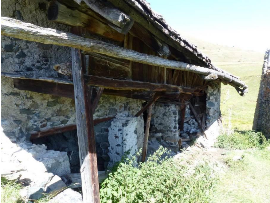
Figure 461 : Détail de la galerie construite en encorbellement, au second niveau du mur gouttereau sud-ouest, août 2014 (les Fraches, Cervières).
