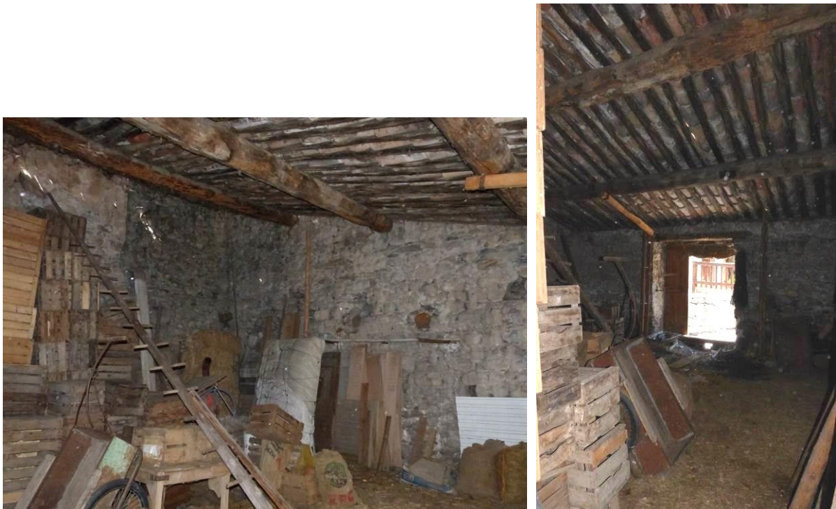
Figure 727 : Vue de l'angle sud-ouest de la grange (à gauche) et du mur gouttereau nord-est (à droite) (La Javie).
