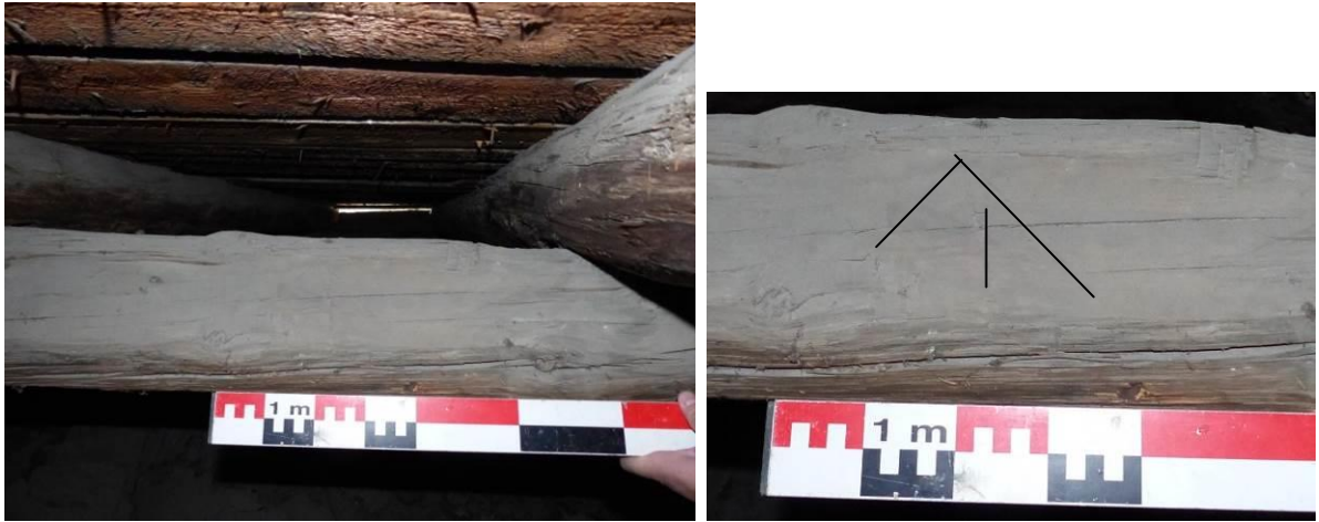
Figure 218 : La seconde inscription relevée sur la panne intermédiaire 08 est plus difficile à lire. Elle représente un « V » irrégulier et un trait vertical (le chiffre 6 ?) (église St-Laurent, La Roche-de-Rame).
