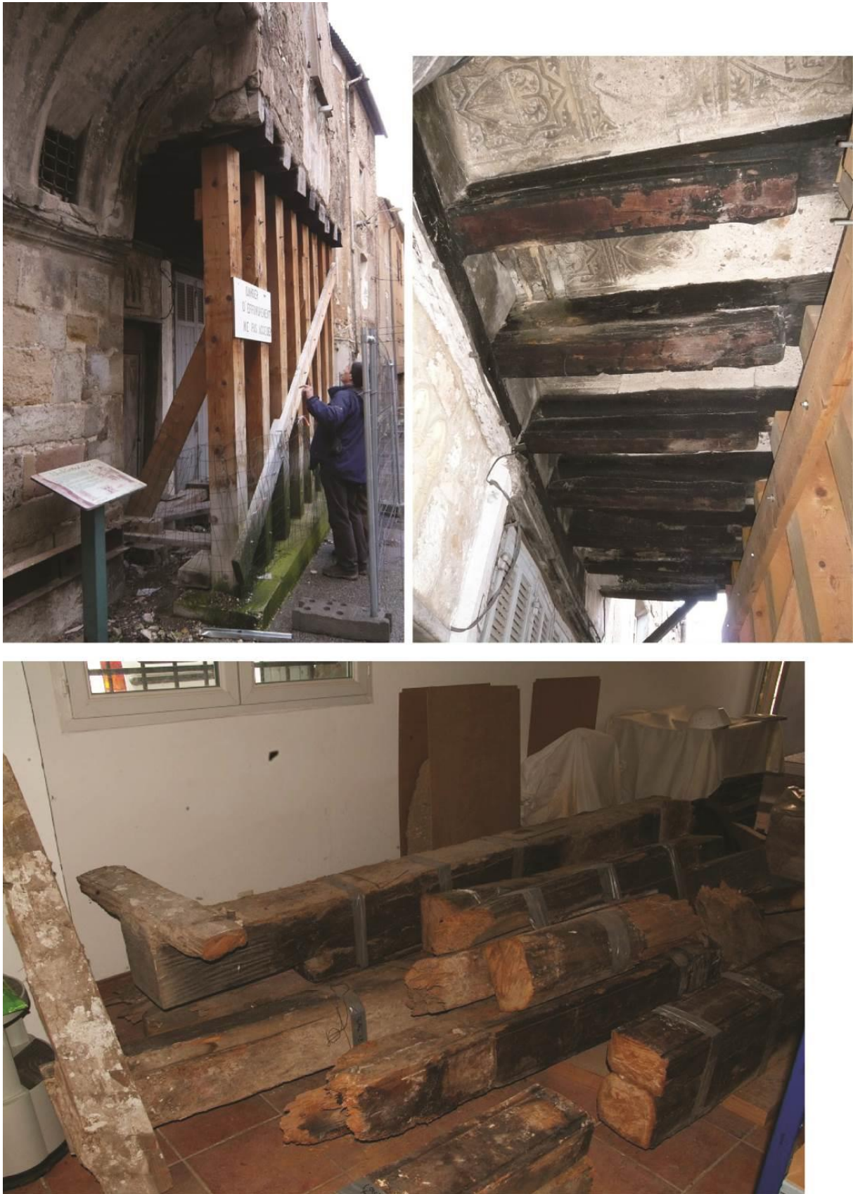
Figure 272 : Les solives soutenant la façade en encorbellement de l'immeuble n°3 ont été déposées et prélevées en juillet 2013, au dépôt archéologique municipal de Riez. Elles sont en saule et reposaient sur deux sablières basses, en noyer et en chêne.
