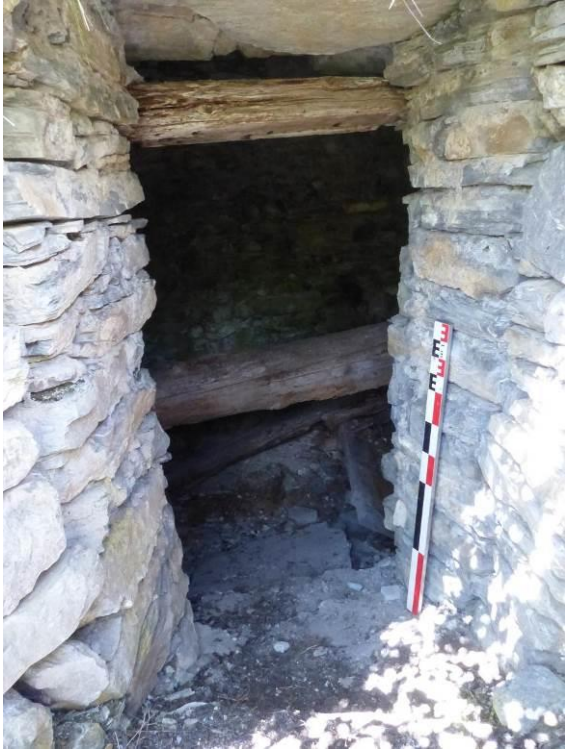
Figure 151 : Pressoir B08 (0515106). Couloir d'accès, vue vers le nord-ouest.
