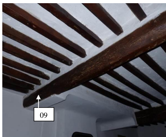
Figure 237 : La poutre 09 est la seule non équarrie. Elle se trouve dans la chambre du premier étage côté route de Prads (La Javie).
