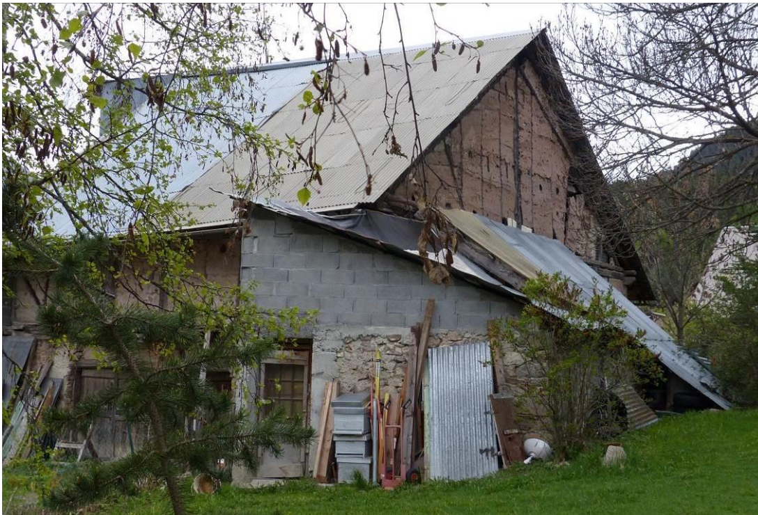
Figure 352 : Vue des fermes depuis le nord-ouest. Le pignon ouest de la ferme ouest (celle non étudiée, à l'arrière de l'îlot), est construit en pan de bois sur trois niveaux (Pra Premier, Val-des-Prés).
