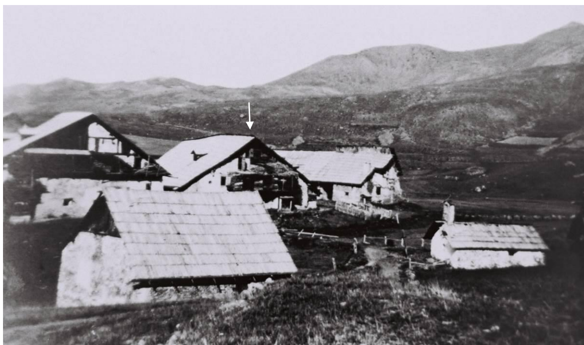
Figure 447 : Vue du hameau vers le nord-ouest. Seul le bâtiment au centre de la photographie (celui étudié) est toujours debout aujourd'hui (Photographie appartenant à Daniel Rey, Cervières, datant d'avant l'incendie des années 1930).
