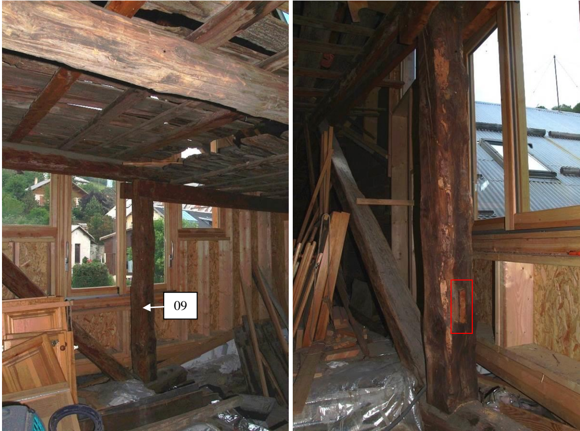
Figure 546 : Poinçon (09) de la ferme ouest. La mortaise présente sur sa face sud est le témoin d'un assemblage aujourd'hui disparu ou du réemploi de ce bois (le Pinet, Puy-St-Pierre).
