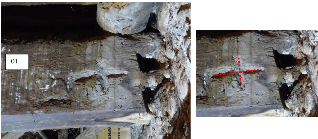
Figure 732: Détail de l'extrémité nord-est de la poutre 01 : une croix y est gravée et deux cavités y ont été creusées (La Javie).
