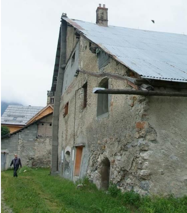
Figure 28 : Vue de la ferme depuis le nord-est (le Serre, Val-des-Prés).
