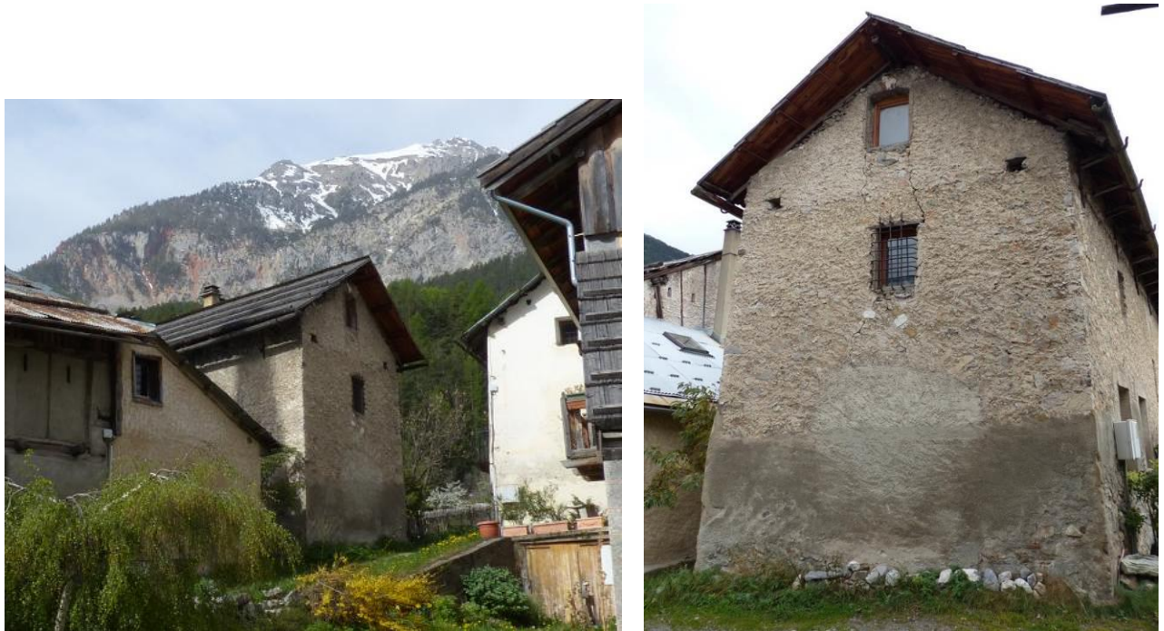
Figure 418 : Vue de la maison depuis le nord-est. On distingue au niveau inférieur du mur pignon nord, l'emplacement de l'ancienne ouverture de l'écurie (le Serre, Val-des-Prés).
