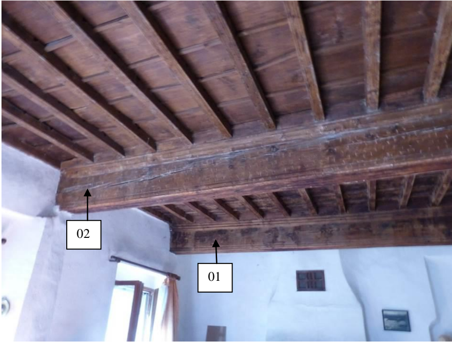
Figure 694 : Vue de la partie sud-est de la pièce et des poutres 01 et 02 (Blégiers, Prads-Haute-Bléone).
