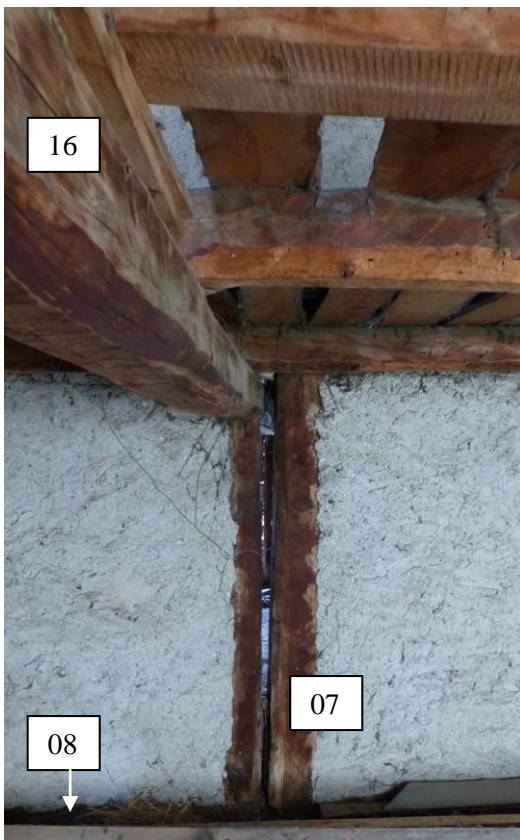
Figure 365 : Grange, N+3, pan de bois ouest. La grange de la ferme mitoyenne se devine à travers l'espace entre le poteau et le poinçon 07 (Pra Premier, Val-des-Prés).
