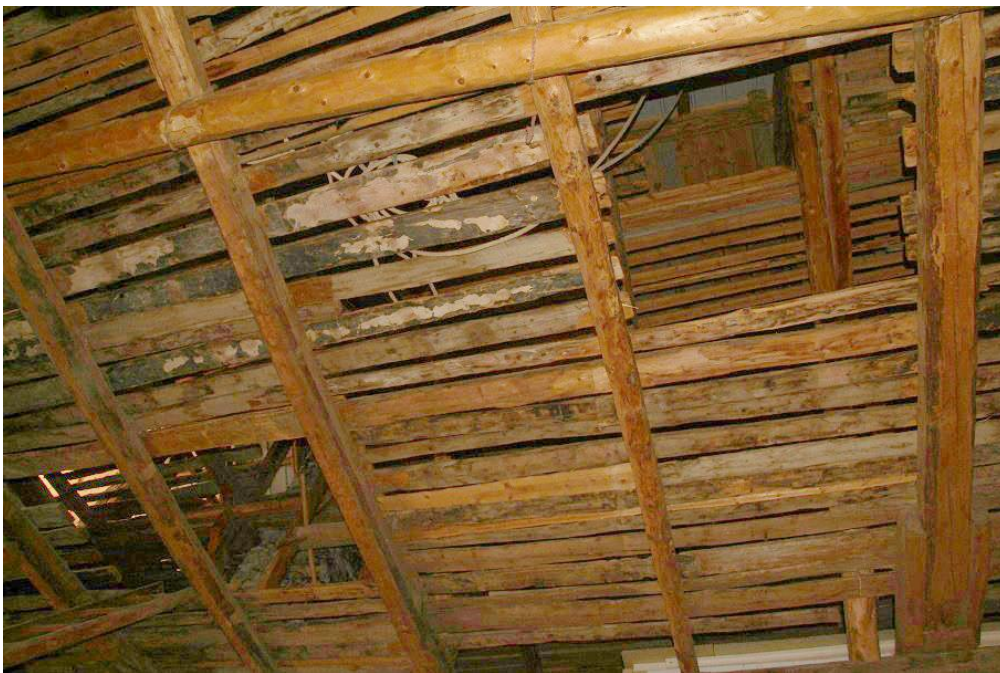
Figure 510 : Vue des différents plans de la grange, à travers les ouvertures ménagées dans les planchers. La photographie est prise depuis le premier étage du bâtiment, vue depuis l'est (le Laus, Cervières).
