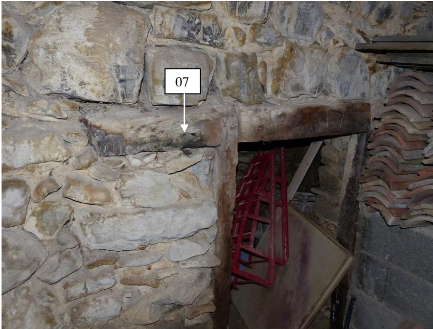
Figure 675 : Détail de la pièce de bois numéro 07, prise dans la maçonnerie, dans le prolongement du linteau de l'ouverture dans le mur sud-est (Chanolles, Prads-Haute-Bléone).
