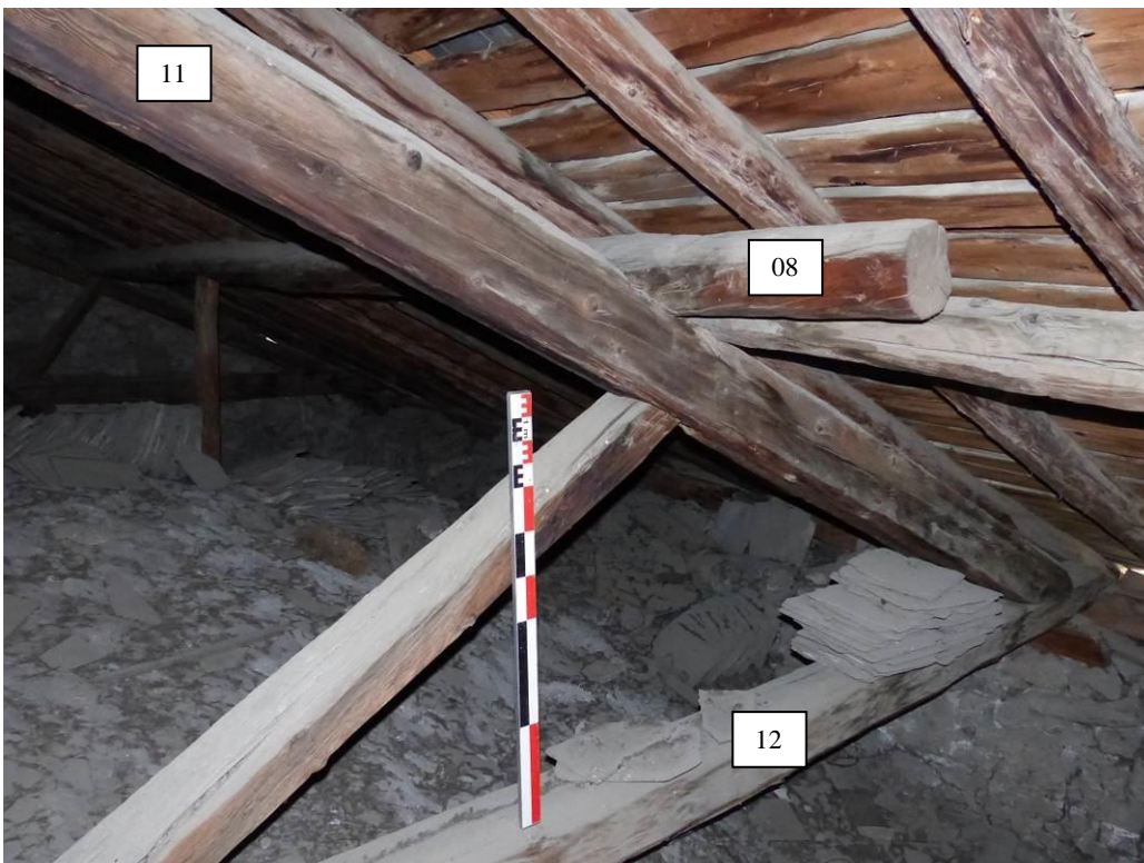
Figure 207 : Détail de la partie sud de la ferme centrale, vue depuis le nord-ouest. Comme sur la partie nord, l'extrémité de la panne intermédiaire sud-est (08) repose sur celle de la panne intermédiaire sud-ouest (non échantillonnée) (église St-Laurent, La Roche-de-Rame).
