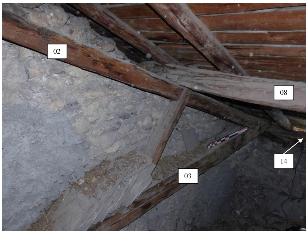
Figure 200 : Vue de la partie sud-est des combles (église St-Laurent, La Roche-de-Rame).
