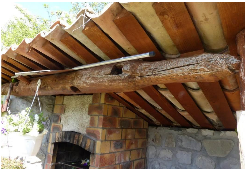
Figure 665 : Détail de l'extrémité est de l'arbre de transmission, taillée pour s'insérer dans une autre pièce (Chavailles, Prads-Haute-Bléone).
