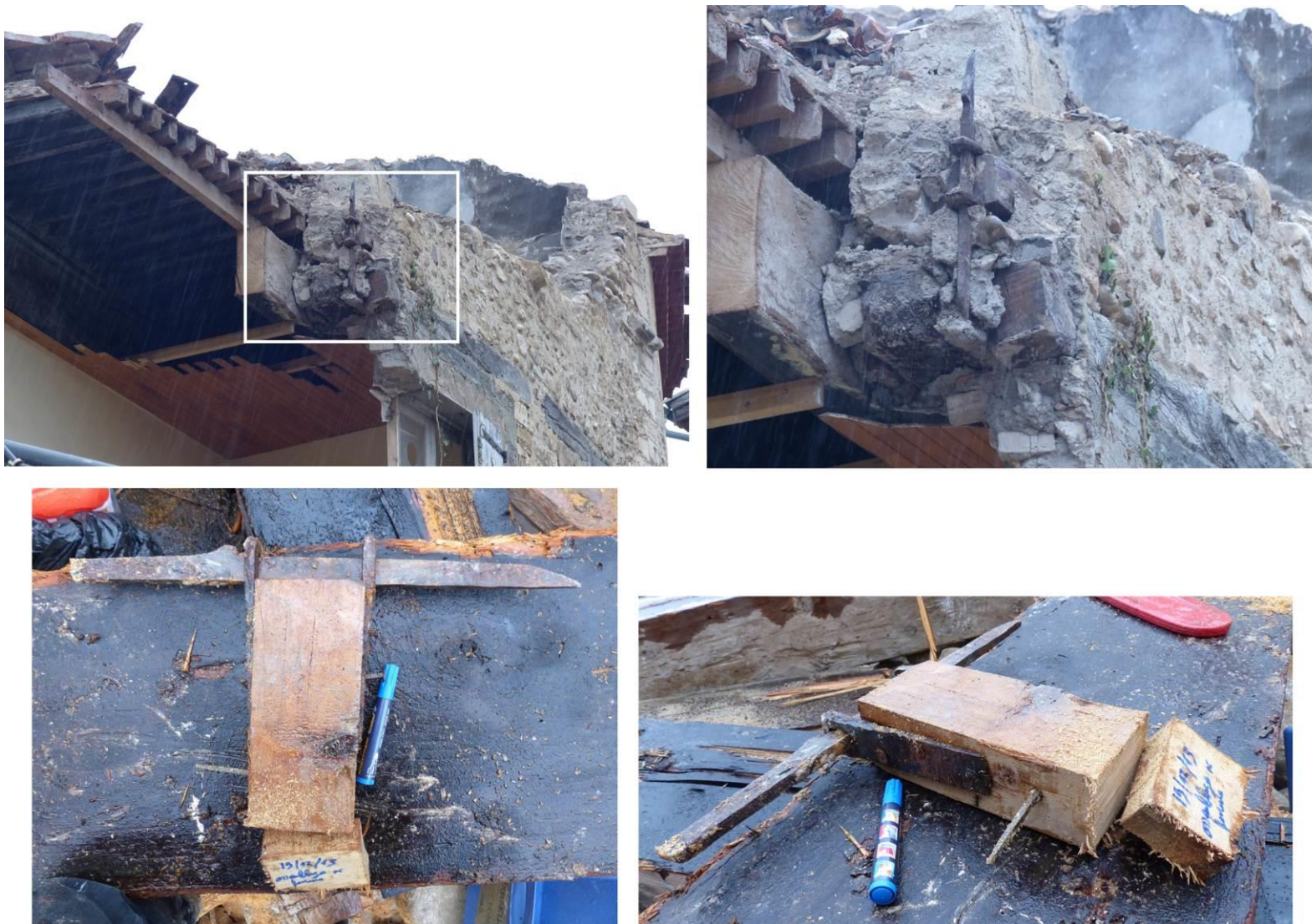
Figure 276 : Agrafes métalliques fixées aux extrémités de certaines pièces de bois. Sur une pièce en place (premier étage, mur sud du corps de bâtiment nord de l'hôtel Ferrier) et sur une pièce de bois déposée.
