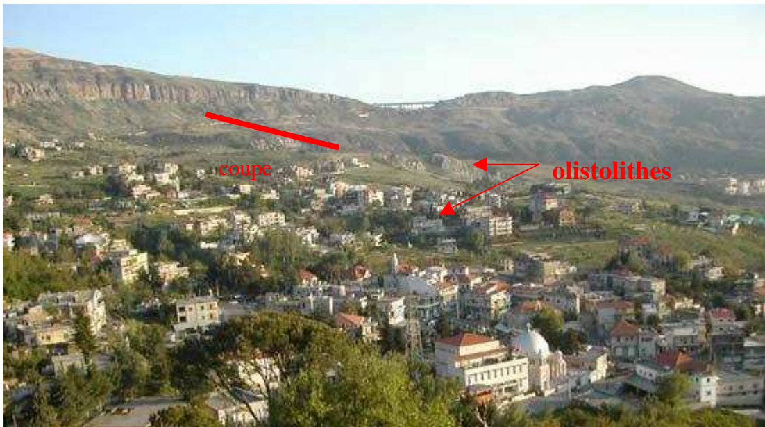
Figure 112 : Observation satellitale, carte topographique et vue sur la coupe d’Hammâna avec localisation des olistolithes .
