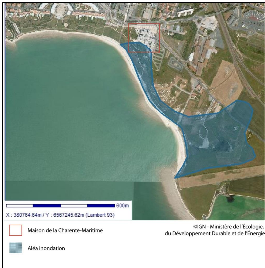
Photo 7 : La Maison de la Charente-Maritime soumise à l'aléa inondation
