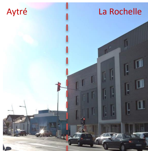
Photo 8 : Limite entre la commune de La Rochelle (Bâtiment en R+4) et la commune d'Aytré en zone pavillonnaire, rue Emile Normandin. (Source : V.Kolb)
