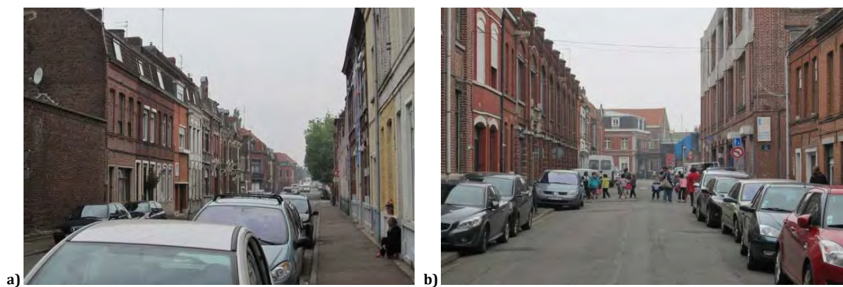
Figure 30, Voies de desserte locale « niveaux 4 et 5 », a) Rue de l'industrie à Roubaix ; b) Rue de Crouy à Roubaix – (Photos par Mahran Haidar).
