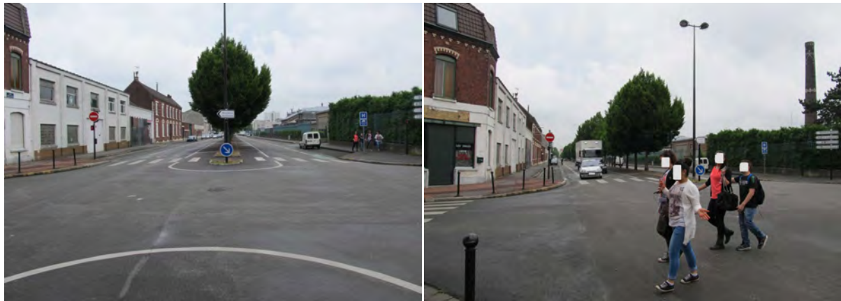
Figure 28, Artère urbaine « Niveau 2 ». Avenue Julien Lagache à Roubaix (Photos par Mahran Haidar).
