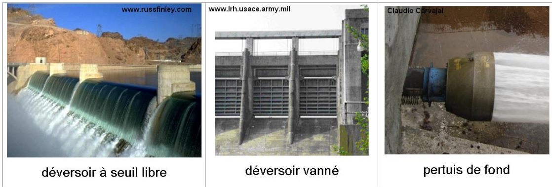
Figure 3-5 : Exemple de déversoirs à seuil libre, vanné et de pertuis de fond.
