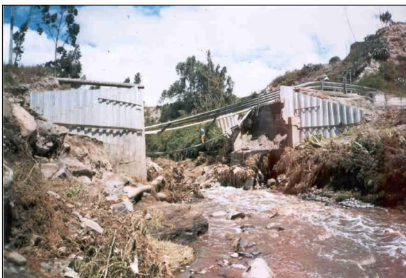
Photo 5 – A gauche, destruction du pont d’accès au lotissement La Pampa au nord de Quito (Pomasqui) suite à une crue du río Monjas (F. Demoraes – déc. 2001). A droite, une avenue principale sous les cendres (Fermeture du service de transport sur la Ecovía) lors de l’éruption du volcan El Reventador (F. Demoraes – nov. 2002)
