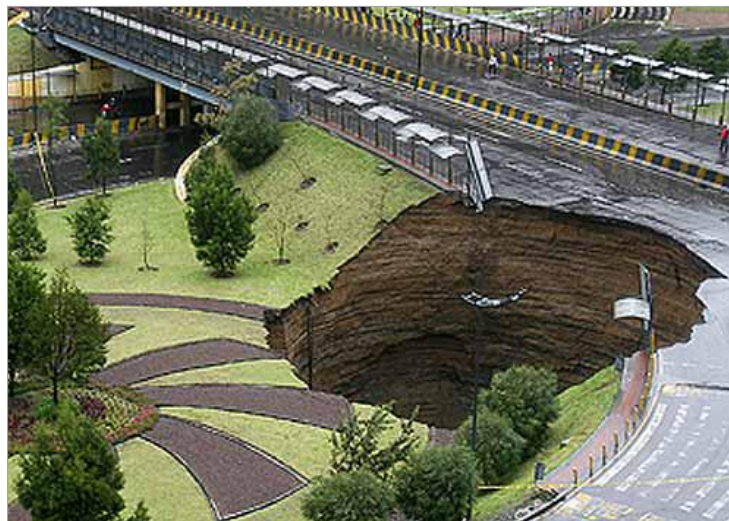
Photo 8 - Effondrement de la voirie à la hauteur de l'échangeur « El Trébol » à Quito (Cliché : Journal El Comercio - 31/03/2008)
