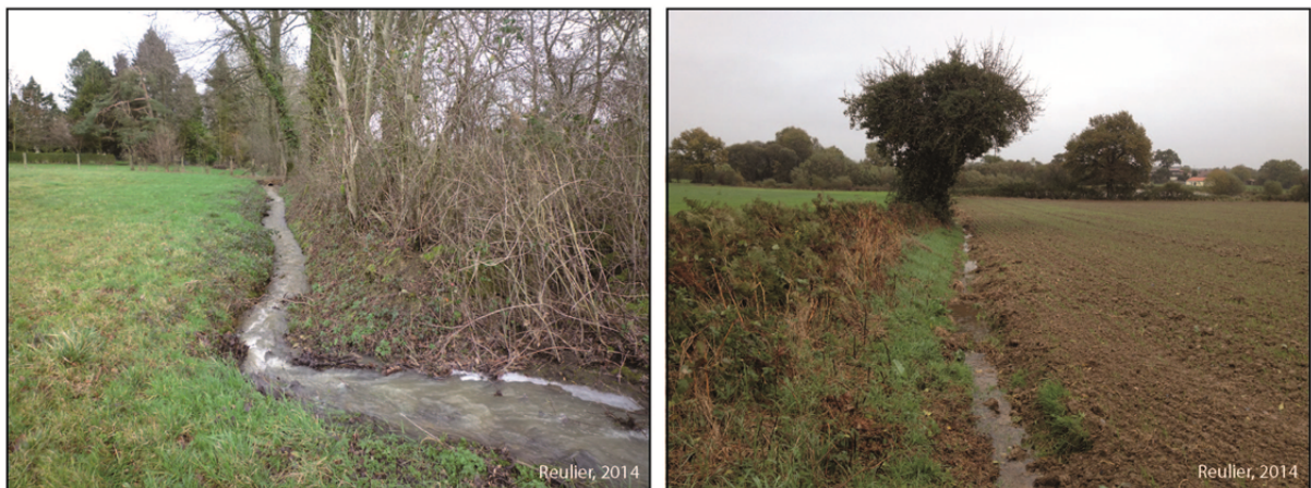
Figure 1.17 : Fossés situés en tête de bassin
