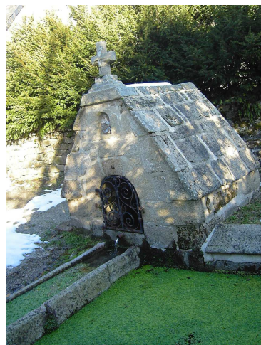
Photo 6 : Fontaine à Tarnac
