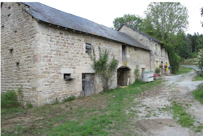
Photo 5 : Maison et grange en pierre
