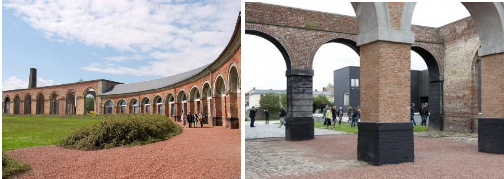
Figure 52, Ensemble du Grand Hornu après réhabilitation chromatique 250
