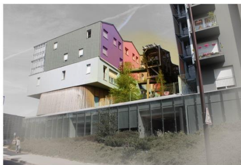
Rue Célestin Freneit, Logements Playtime: effet d'appel visuel, façades et forme architecturale intrigante
