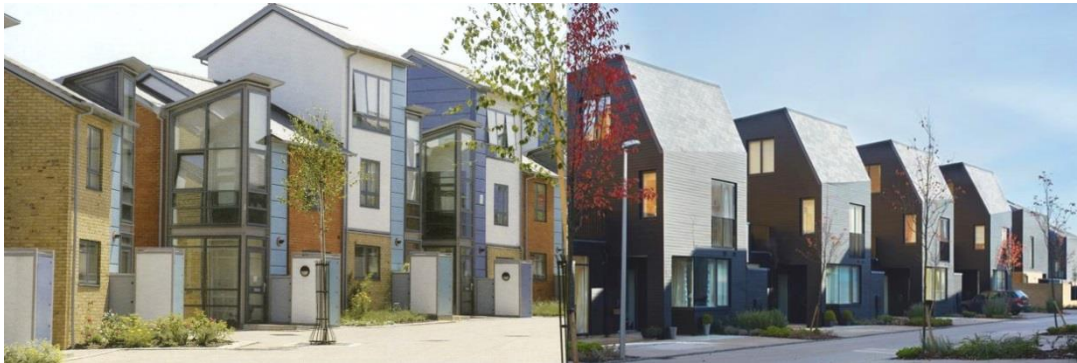
Figure 39, à Gauche, le quartier de Cala Domus à Newhall, les palettes établies par Tom Porter sont intégrées dans le projet de planification urbaine dirigé par Roger Evans et suivies dans le processus de conception architecturales par l'agence PCKO architects. Les constructions mobilisent la brique traditionnelle, les panneaux d'acier laqué, le verre, puis l'ardoise sur les toits en pente ou les feuilles de zinc pour les toits courbes. A droite, des réalisations plus récentes de l'architecte Alison Brooks qui utilise du bois noir en façade et de la brique jaune pour les rez-de-chaussée. 170
