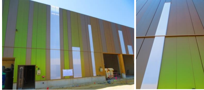
Figure 11, Changement de couleurs de la façade du vert-orange-violet-bleu lors du mouvement de l'observateur (acier pré-laqué changeant de la gamme Irysa, ArcelorMittal) usine d'eau à Plouharnel par l'architecte Stéphanie Fieve. 48
