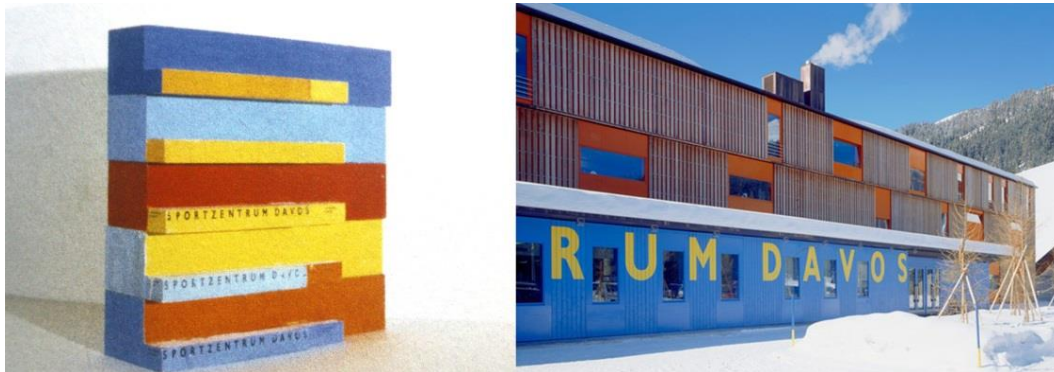
Figure 93, Cinq maquettes (empilées) et image du centre de sport Davos à Zurich, projet réalisé entre 1992 et 1996 par l'agence Gigon/Guyer architecte 362
