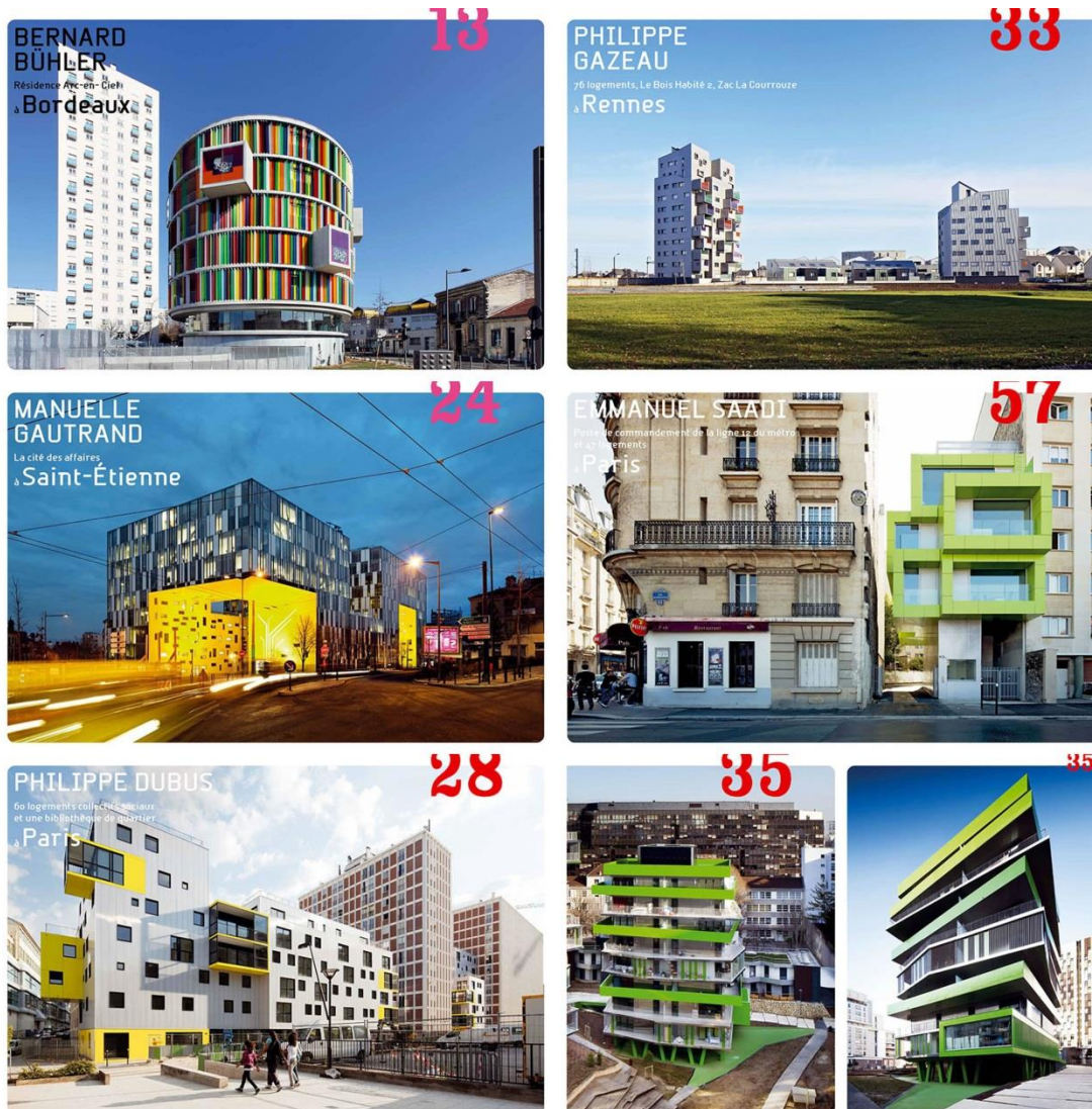
Figure 21, Exemples de constructions du collectif d'architectes français French Touch. En haut à droite, la résidence arc-en-ciel réalisée par Bernard Bühler à Bordeaux, en haut à gauche des logements collectifs réalisé par Philippe Gazeau à Rennes, au milieu à gauche la cité des Affaires réalisée par Manuelle Gautrand à Saint-Etienne, au milieu à droite le poste de commandement de la RATP du 15 e ar. de Emmanuel Saadi, en bas à gauche les logements collectifs réalisés par Philippe Dubus à Paris, en bas à droite les logements collectifs réalisés par Hamonic et Masson à Villiot-Rapé. 68
