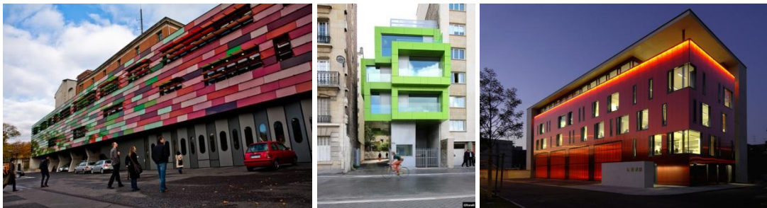
Figure 158, Rôle signalétique de la couleur : à gauche, la caserne de pompier (partie rouge) associée à la station de police (partie verte) de Berlin 602 , architectes Sauerbruch & Hutton en 1999 ; au centre, le poste de commandement de la RATP ligne 12, architecte Emmanuel Saadi, Paris 2011; à droite, la Maison de la sécurité, Lancy (Suisse), 2009, effet de lumière derrière les plaques de Dampalon (polycarbonate).
