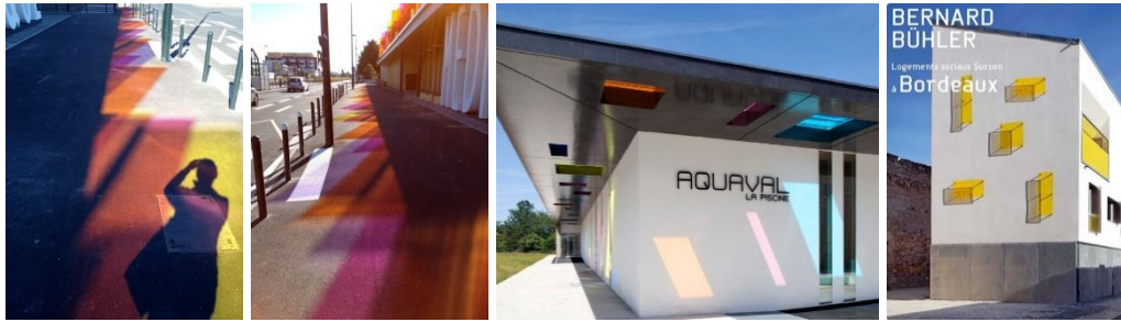
Figure 136, Effet de coulure : à gauche, médiathèque Lisa Bresner, agence d'architecture Rocheteau Saillard, 2013, Nantes 521 . Au centre, piscine Aquaval, agence d'architecture TNA, 2011, Saint-Brieuc 522 . A droite, Logements, Bernard Bühler architecte, Bordeaux. 523
