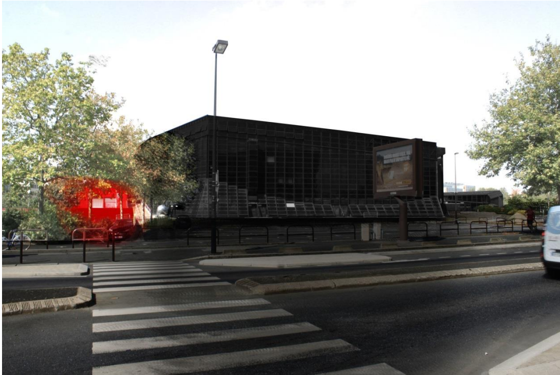
Figure 196, Effet de masse du Palais des Sports produit par le revêtement noir, la forme évasée du socle, l'absence de fenêtres, l'aspect lisse des verrières, la volumétrie intrigante. Photomontage réalisé d'après les photos des enquêtés et retravaillées sur le logiciel Adobe Photoshop® pour mieux représenter graphiquement les effets ressentis in situ par les enquêtés. Réalisation graphique: Anne Petit, 2014.
