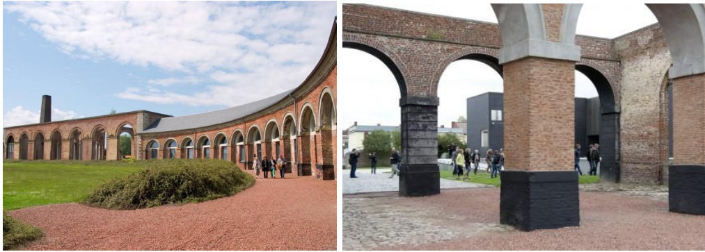
Figure 52, Ensemble du Grand Hornu après réhabilitation chromatique 250
