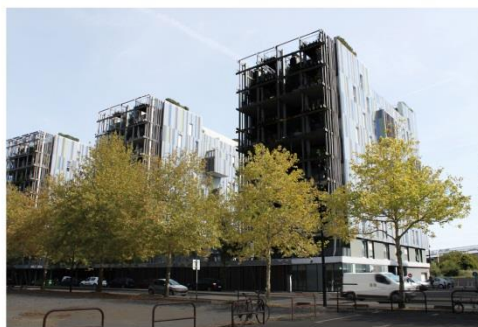
Rue René Viviani, Logements Arborea: effet de mimétisme latéral, effet de trou noir en façade, apaisement, confort visuel
