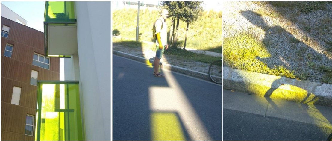
Figure 189, Effet de coulure des balcons de verre du bâtiment Chroma , rue du Cher 636 .
