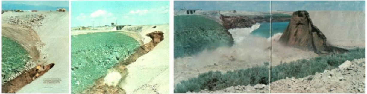
FIGURE 1.1: Différentes prises de vue du barrage de Teton au cours de sa rupture.
