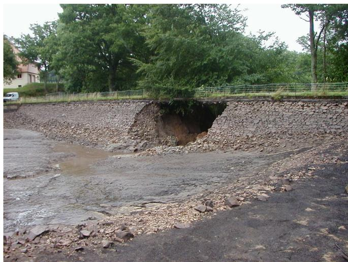
FIGURE 1.2: Exemple de brèche suite à l'érosion d'une digue (R. Frell et J.-J Fry [37]).
